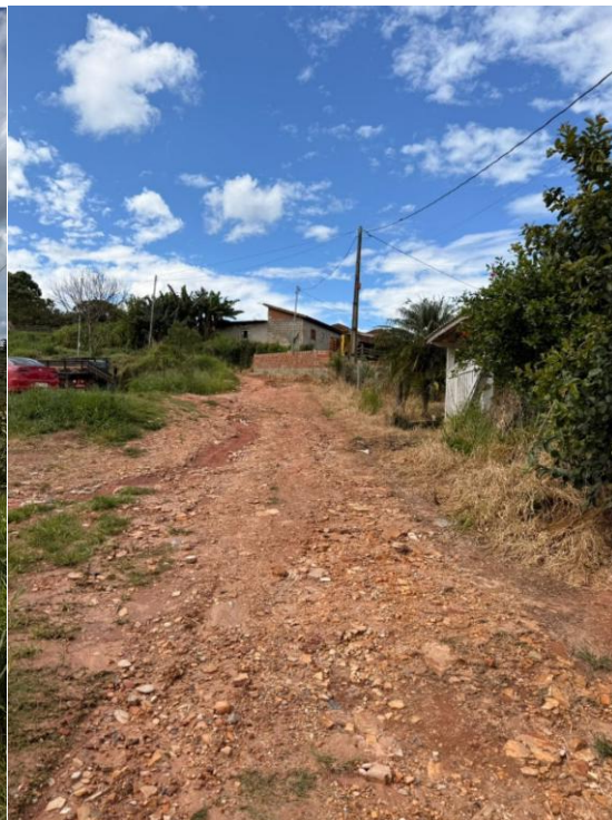
FINAL DO CALÇAMENTO
