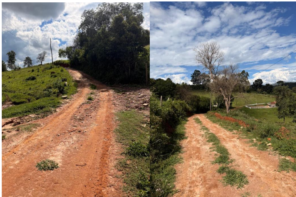
INÍCIO DO CALÇAMENTO
