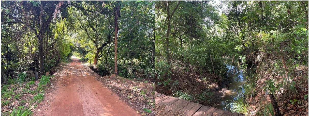
Figura 40 – Ponte 12, sobre o Córrego do Matão.
