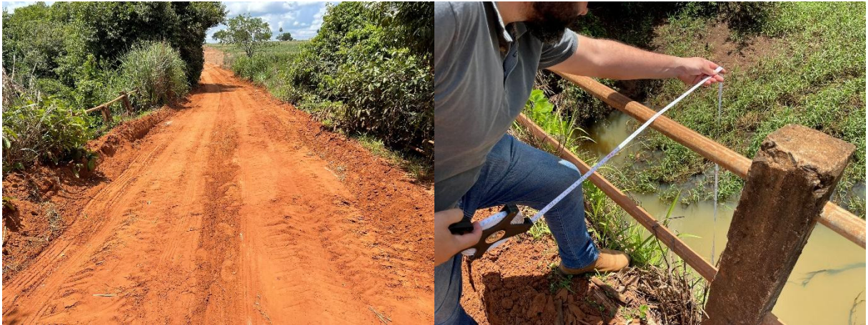
Figura 23 – Ponte 02 , sobre o Ribeirão Lagoa Seca.
