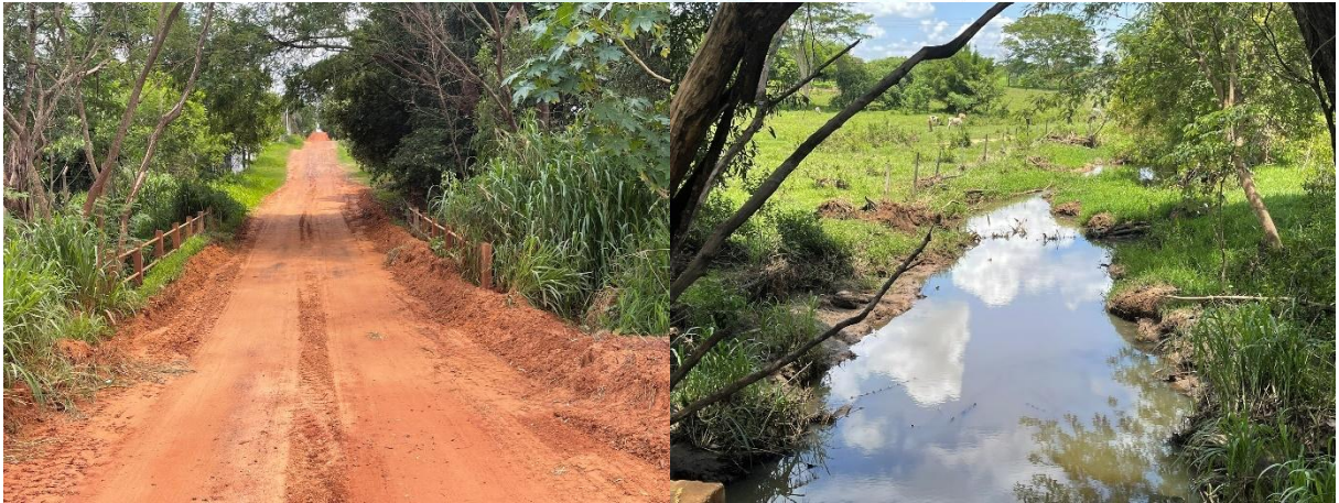
Figura 28 – Ponte 05, sobre o Ribeirão Lagoa.
