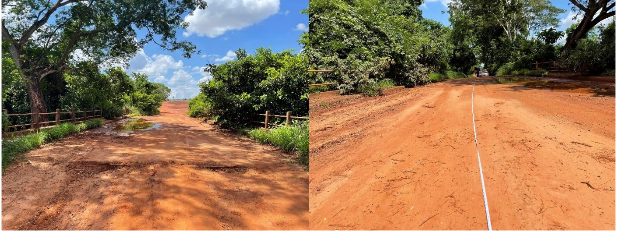
Figura 21 – Ponte 01 , de concreto, sobre o Ribeirão Lagoa Seca.
