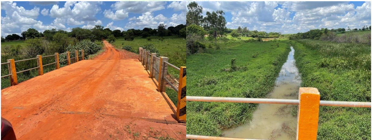
Figura 26 – Ponte 04, sobre o Ribeirão Lagoa.
