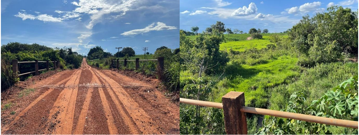
Figura 44 – Ponte 14, sobre o Córrego Sofia.
