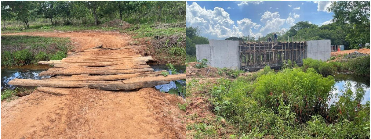
Figura 38 – Ponte11 , sobre o Córrego do Cupim.
