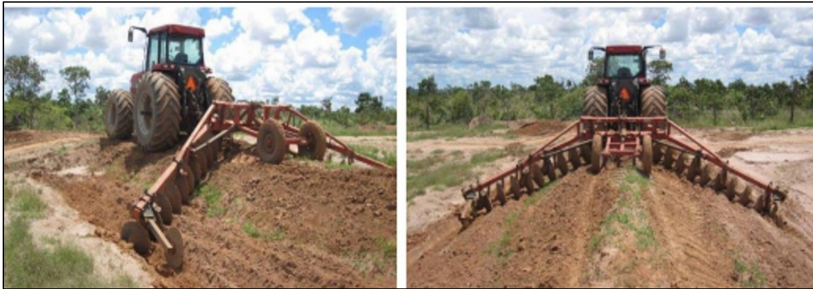
Figura 97 - Construção de terraço de base larga com arado terraceador
