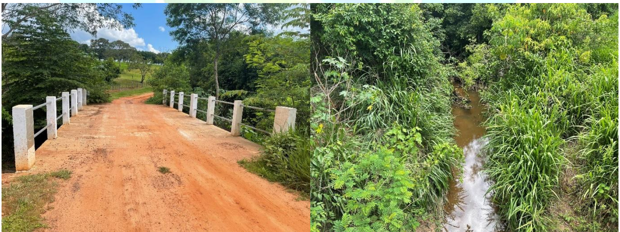
Figura 36 – Ponte 10 , sobre o Córrego do Veadão.
