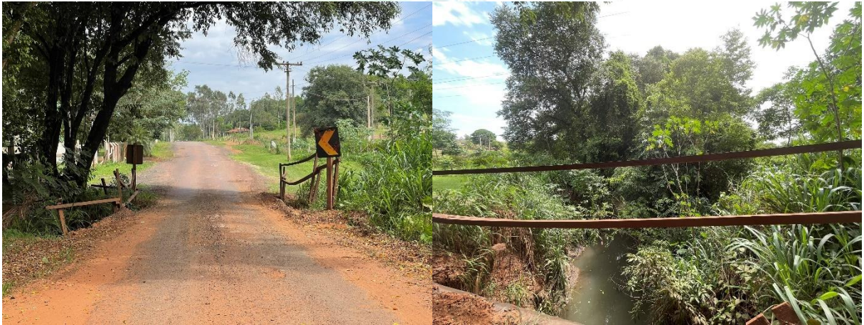
Figura 56 – Ponte 22 , sobre o Córrego Figueira.
