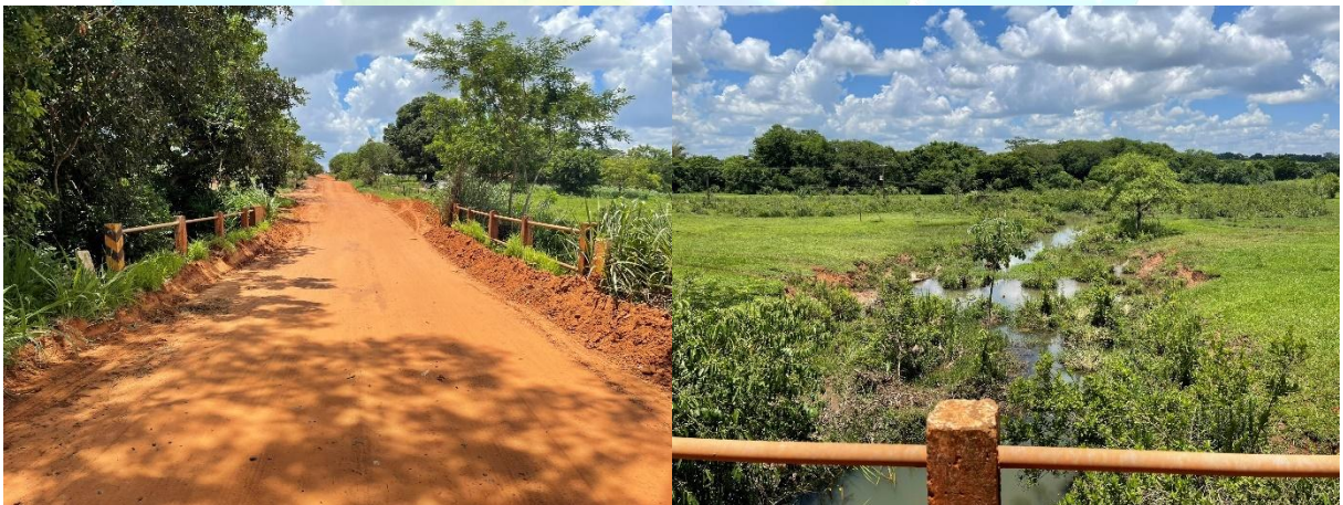
Figura 29 – Ponte 06, sobre o Ribeirão Lagoa.
