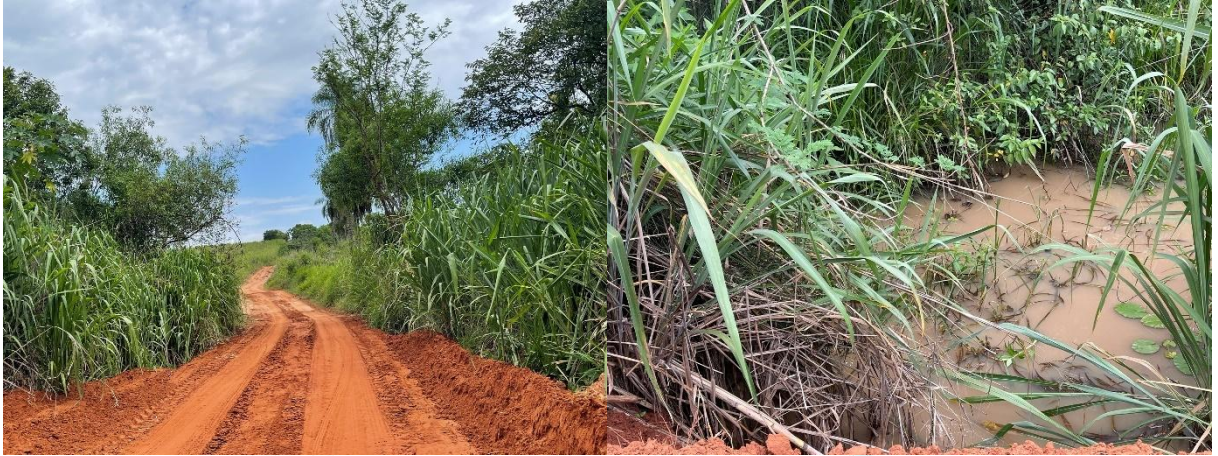
Figura 52 – Ponte 18 , sobre o Córrego do Tanquinho.
