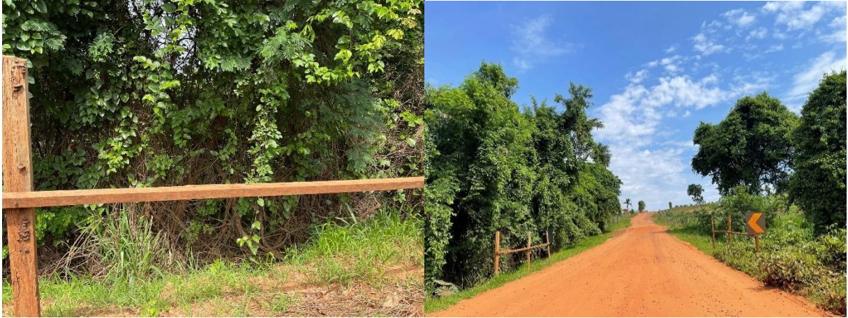
Figura 55 – Ponte 21 , sobre o Córrego do Tanquinho.
