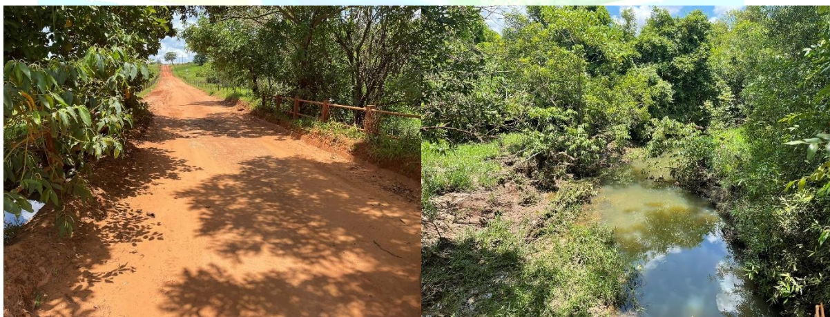
Figura 31 – Ponte 07 , sobre o Córrego da Roça.
