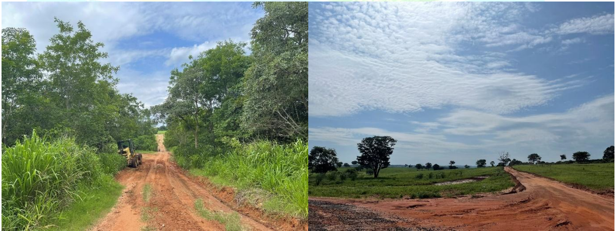
Figura 49 – Estrada em manutenção.
