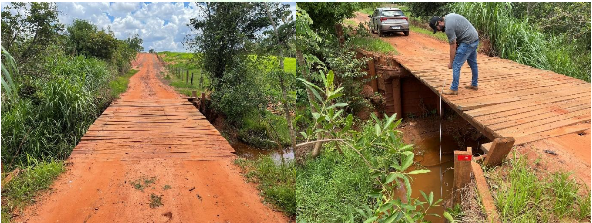
Figura 24 – Ponte 03 , sobre o afluente do Ribeirão Lagoa Seca.
