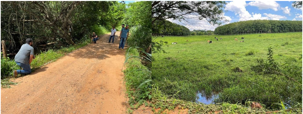
Figura 35 – Ponte 09 , sobre o Córrego do Veadão.
