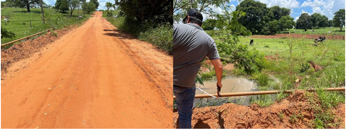
Figura 32 – Ponte 08 , sobre o Córrego da Roça.
