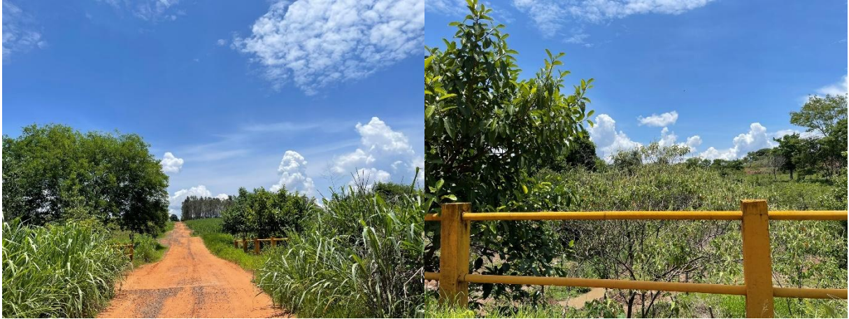
Figura 67 – Ponte 24 , sobre o Afluente do Ribeirão Lagoa.
