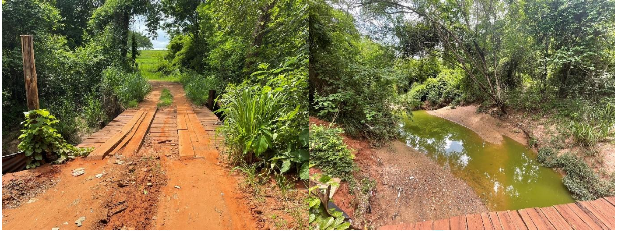
Figura 61 – Ponte 23, sobre Córrego Tamboril.
