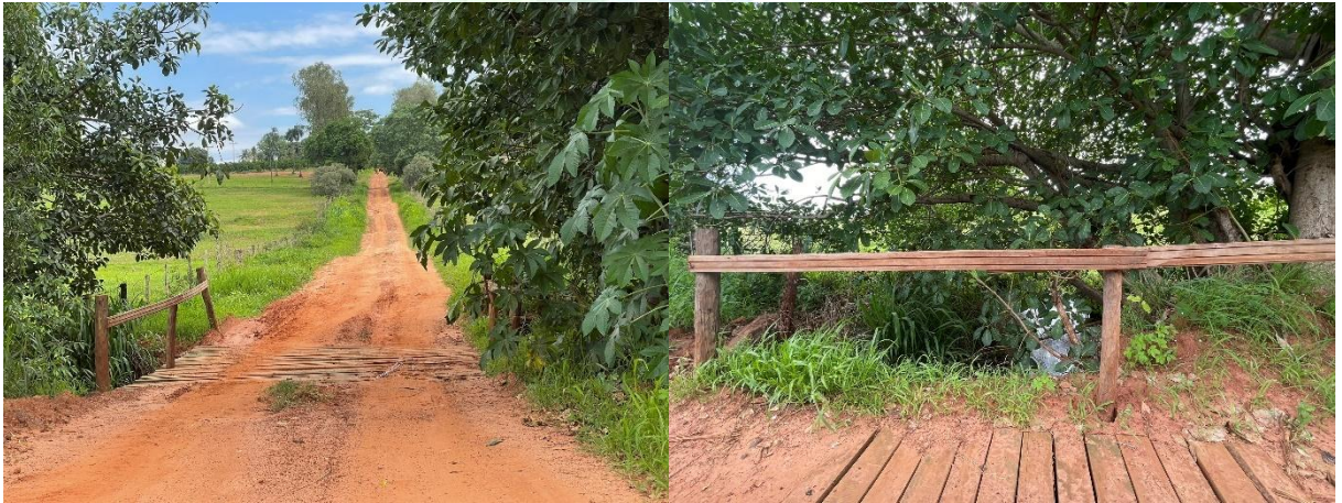
Figura 53 – Ponte 19 , sobre o Córrego do Tanquinho.
