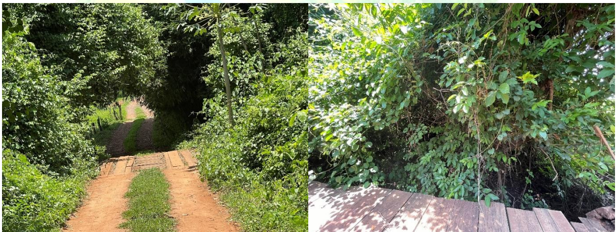
Figura 70 – Ponte 25 , sobre o Ribeirão Lagoa Seca.
