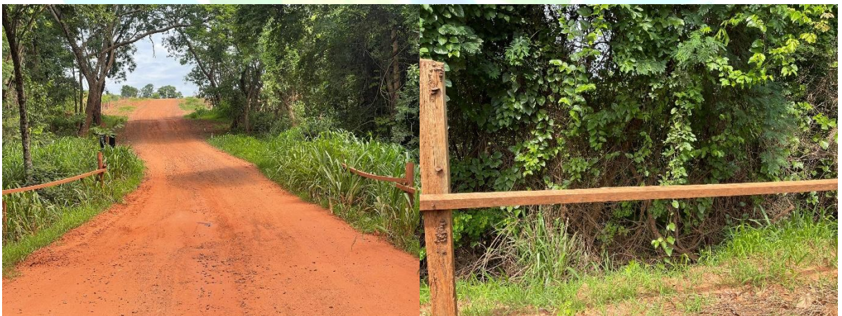
Figura 54 – Ponte 20 , sobre o Córrego do Tanquinho.
