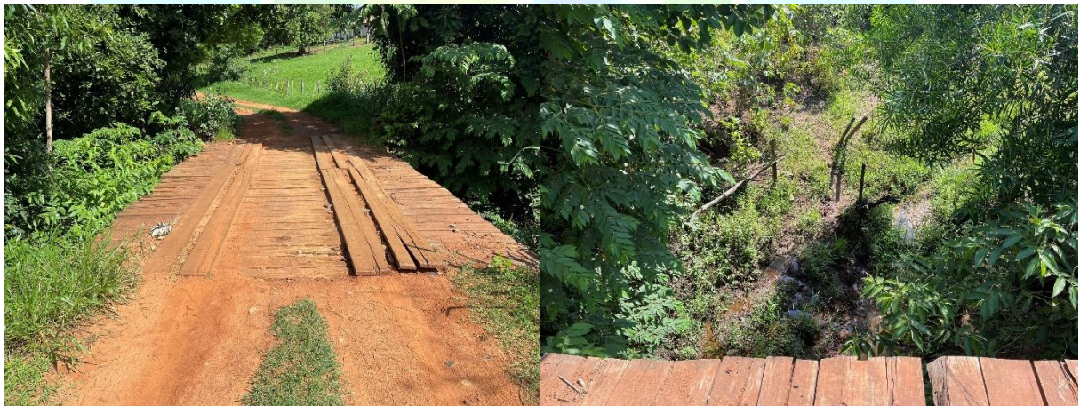
Figura 41 – Ponte 13, sobre o Córrego do Matão.
