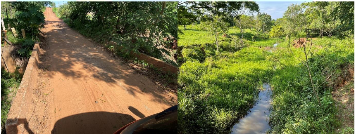
Figura 47 – Ponte 15 , sobre o afluente do Córrego da Figueira.
