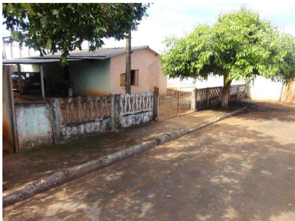
Foto 6.7 – Área de alagamento no cruzamento da rua Santos com a avenida Quinze de Novembro
