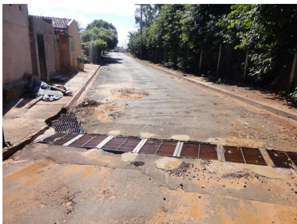
Foto 6.1 – Grelha transversal recém instalada na rua Roberto dos Santos
