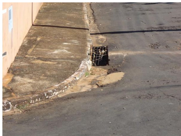
Foto 6.2 - Boca de lobo simples da rua Roberto dos Santos
