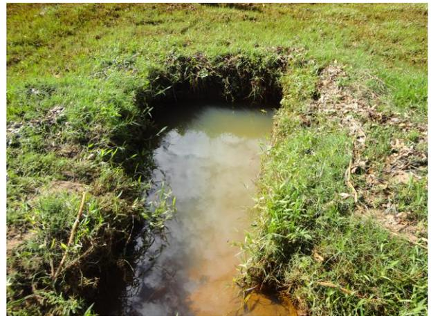
Foto 3.6 - Dissipação da rede de galerias pluviais na margem da rodovia municipal 37
