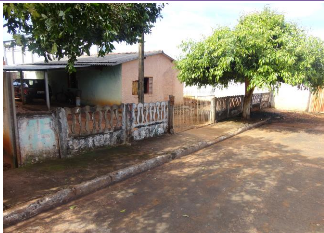
Ponto de alagamento
