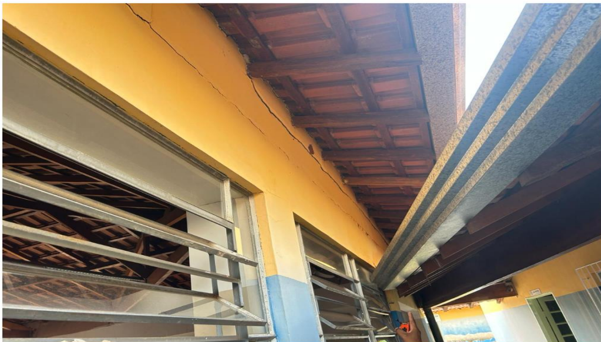
Figura 2 - Parte externa do galpão com rachaduras
