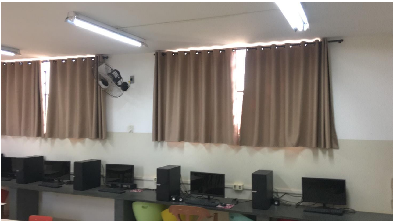
Foto 1 - Luminárias fluorescentes, sendo necessária sua atualização para lâmpadas LED, gerando economia. Instalações Aparentes sem padronização, necessitando sua adequação para instalações embutidas, que trazem menor risco aos usuários.
