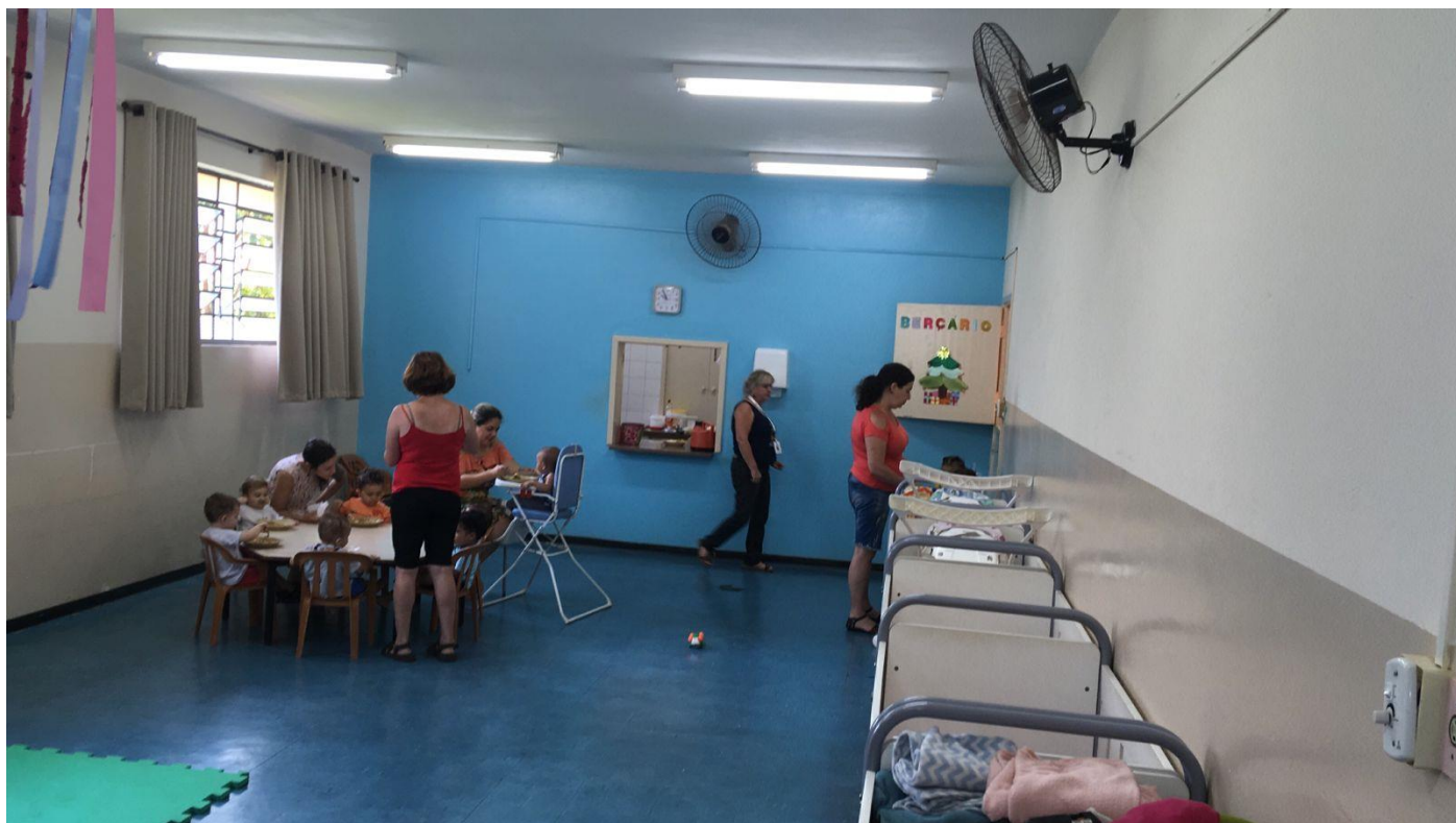
Foto 2 - Luminárias fluorescentes, sendo necessária sua atualização para lâmpadas LED, gerando economia.
