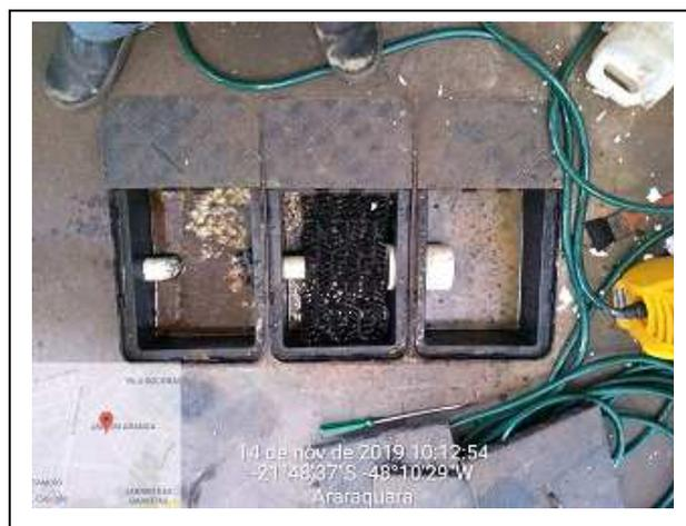
**Figura 1:** Oficina de pequeno porte contendo cobertura e pavimento impermeabilizado, com sistema SAO em funcionamento e tambores para recolher os resíduos contaminados.
