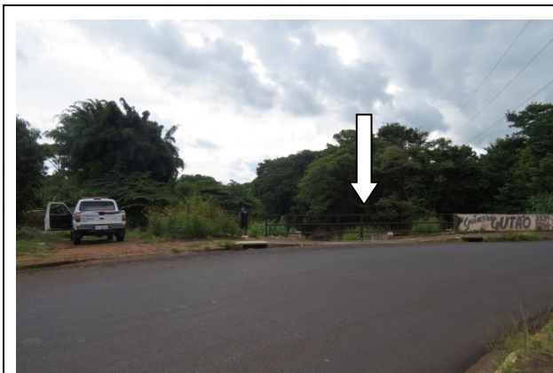
FOTO 29. Vista, de montante para jusante, de sistema de drenagem superficial (“rampa”), para condução das águas que escoam pelas vias de acesso (seta).
