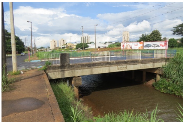
FOTO 55. Vista de ponte sobre o ribeirão do Ouro. Notar vão central e altura das margens.
