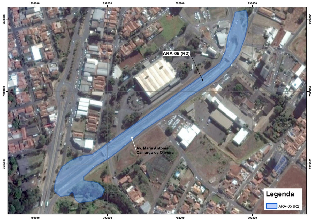
FIGURA 9 – Vista geral da área mapeada ARA-05. Fonte: Image 2015 CNES/Astrium , Google Earth Pro, 2016.
