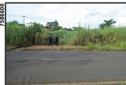
Vista do ponto no qual o ribeirão do Ouro passa a ser canalizado.
