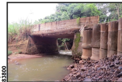
Vista da ponte sobre o córrego do Ouro.
