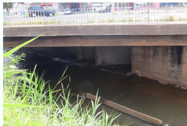
FOTO 58. Vista da chegada do córrego da Servidão no ribeirão do Ouro. Notar dimensões das galerias e tamanho do vão sob a ponte.
