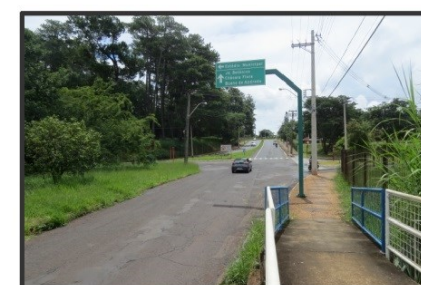
Vista de área afetada pelas inundações do ribeirão das Cruzes (margem direita do ribeirão).
