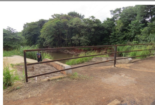
FOTO 35. Vista da “rampa” e drenagem ao fundo.
