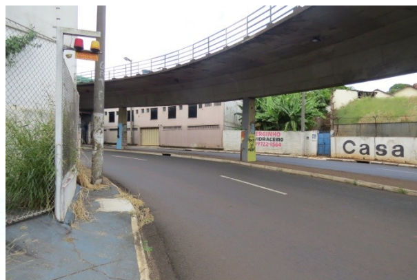
FOTO 38. Vista, de jusante para montante, da via de acesso e moradas (ao fundo) afetadas pelas inundações do córrego.
