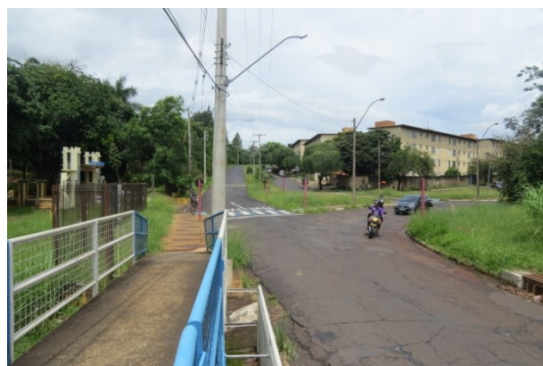
FOTO 7. Vista de área afetada pelas inundações do ribeirão das Cruzes (margem esquerda do ribeirão). Segundo informações da COMDEC, as águas atingem cerca de 0,50 m de altura e provocam transtornos temporários no local. Há contribuição de águas que se concentram no sistema viário.
