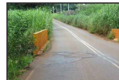
Registro de feições de movimentações que afetam o pavimento da estrada Abílio Augusto Corrêa.
