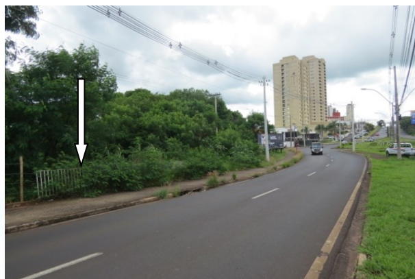
FOTO 10. Vista geral de trecho da Avenida Padre Francisco Sales Colturato bastante afetado pelas inundações do ribeirão das Cruzes. Segundo dados da COMDEC as águas podem atingir cerca de 0,40 m de lâmina d'água. A seta indica o guarda corpo de jusante da ponte. Notar arbustos cobrindo grande parte do guarda corpo.
