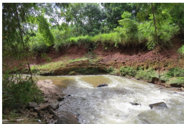
FOTO 24. Vista de erosão da margem direita do córrego do Ouro.
