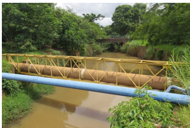
FOTO 5. Vista geral de trecho do ribeirão das Cruzes. Notar dimensões do leito e das margens e intervenções presentes neste local.
