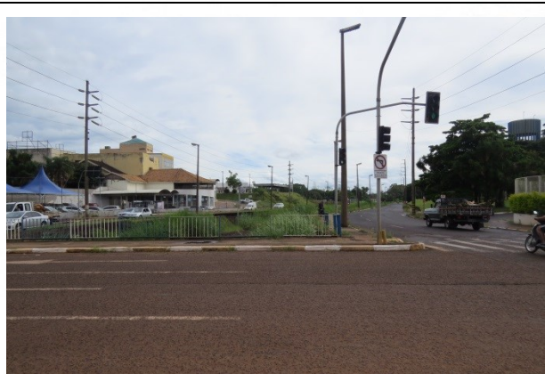
FOTO 47. Vista geral da Avenida Maria Antonia Camargo de Oliveira, nas proximidades da Rodoviária. Um grande trecho da avenida é afetado por inundações do ribeirão do Ouro.
