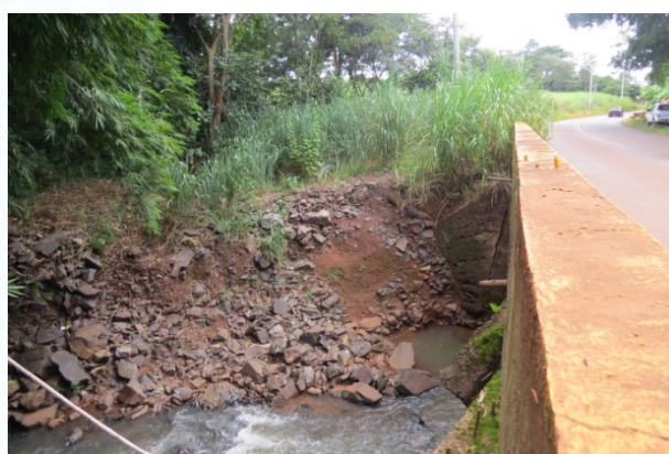
FOTO 26. Vista, de jusante, das estruturas que compõem a cabeceira da margem esquerda.
