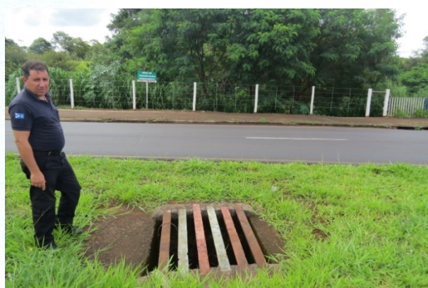
FOTO 16. Vista de sistema localizado no canteiro central da avenida executado para aumentar a eficiência no escoamento das águas após as cheias.
