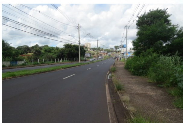
FOTO 15. Vista de área afetada pelas inundações do ribeirão das Cruzes. Há contribuição de águas que se concentram no sistema viário.
