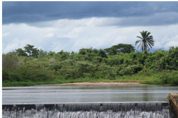
FOTO 2. Vista de banco de areia, a montante do vertedor central, mostrando grau de assoreamento do lago formado o barramento do ribeirão das Cruzes.
