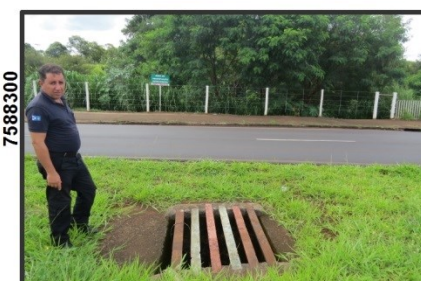
Vista de sistema localizado no canteiro central da avenida executado para aumentar a eficiência no escoamento das águas após as cheias.
