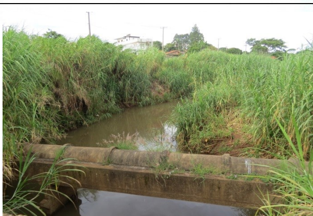
FOTO 61. Vista do ribeirão do Ouro, nas proximidades do trecho mostrado na FOTO 62.
