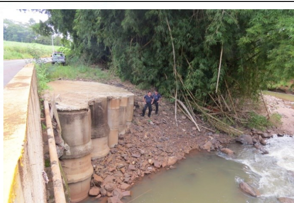
FOTO 22. Vista lateral das obras de recuperação e contenção.
