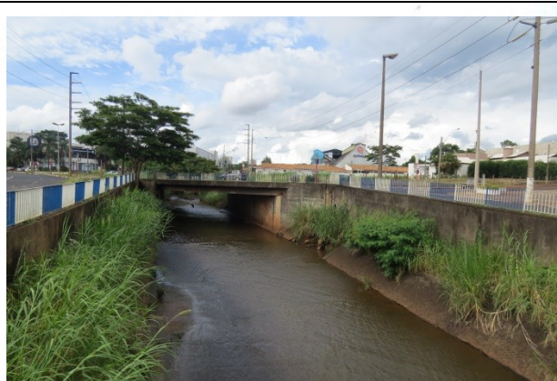
FOTO 45. Vista de trecho do ribeirão do Ouro. Notar as dimensões do vão da ponte e a presença de vegetação nos talues marginais.
