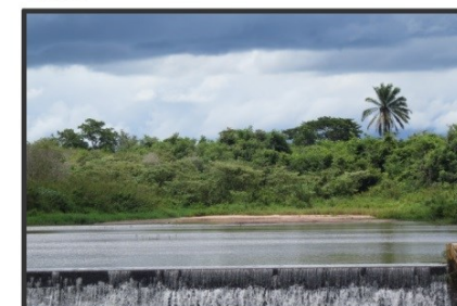
Vista de banco de areia, a montante do vertedor central, mostrando grau de assoreamento do lago formado o barramento do ribeirão das Cruzes.
