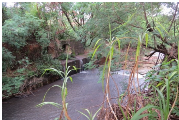
FOTO 11. Vista de trecho do ribeirão das Cruzes, margem esquerda. Notar tubulações que conduzem as águas de coletadas nas áreas impermeabilizadas do bairro.
