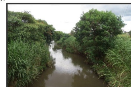
Vista geral da drenagem. Notar dimensões e proteção vegetal das margens. Há poucas moradas nas proximidades.
