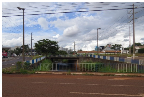
FOTO 44. Vista de trecho do ribeirão do Ouro e respectiva travessia. Notar dimensões do vão do córrego e do sistema viário afetado pelas inundações.
