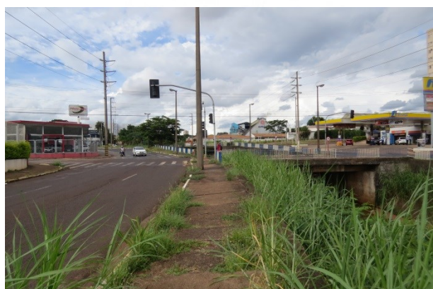
FOTO 43. Vista geral de cruzamento próximo à Rodoviária e a Avenida Maria Antonia Camargo de Oliveira, atingidas, frequentemente, por eventos de inundação do ribeirão Ouro.
