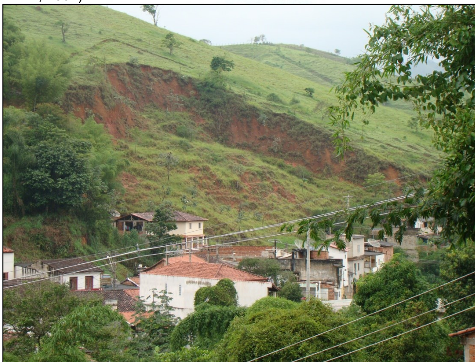
Figura 6 – Deslizamento circular ou rotacional (Fonte: Sirden-CTGeo-IPT).
