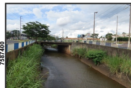
Vista de trecho do ribeirão do Ouro e respectiva travessia. Notar dimensões do córrego e do vão da ponte.
