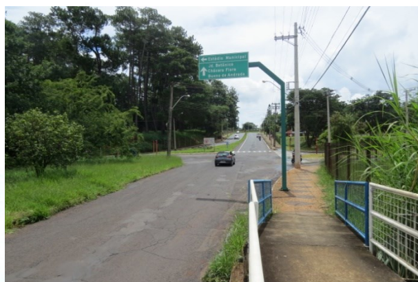
FOTO 8. Vista de área afetada pelas inundações do ribeirão das Cruzes (margem direita do ribeirão). Segundo informações da COMDEC, as águas atingem cerca de 0,50 m de altura e provocam transtornos temporários no local. Há contribuição de águas que se concentram no sistema viário.
