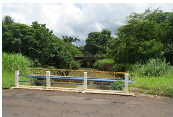
FOTO 4. Vista da travessia do ribeirão das Cruzes, localizada a cerca de 30 m a jusante do ponto mostrado na FOTO 3.
