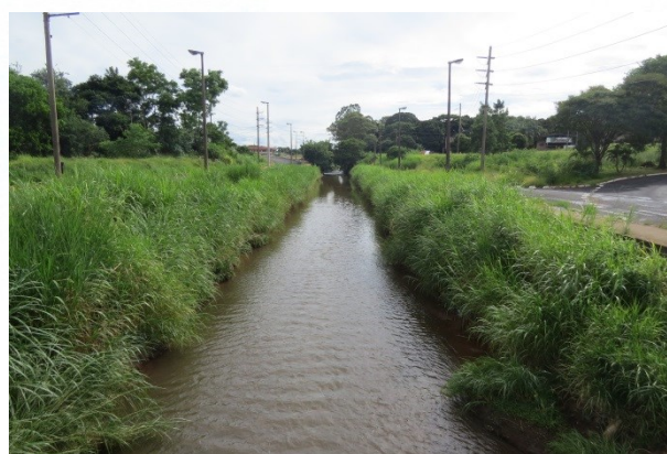
FOTO 54. Vista geral, de montante para jusante, do ribeirão do Ouro. Notar a vegetação presente em ambas as margens.
