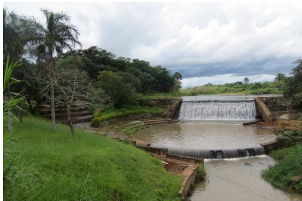
FOTO 1. Vista geral de barragem localizada no ribeirão das Cruzes. Trata-se de área de captação de água e regularização de cheia. Há extravaso lateral (margem esquerda) e vertedor central.
