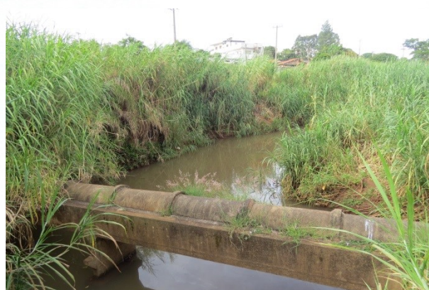
FOTO 64. Vista geral do ribeirão do Ouro com destaque para suas dimensões e altura dos taludes marginais.
