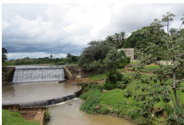
FOTO 3. Vista geral da margem direita da barragem. Na margem direita estão localizadas as instalações que compõe o sistema de captação de água.
