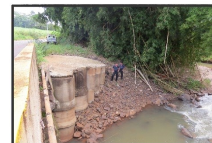
Vista lateral das obras de recuperação e contenção.
