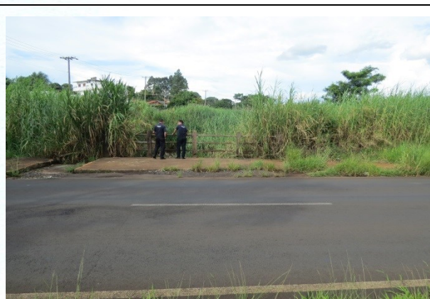
FOTO 62. Vista do ponto no qual o ribeirão do Ouro passa a ser canalizado.
