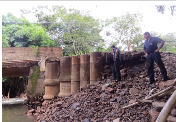
FOTO 21 Vista, de jusante para montante, das obras de recuperação e contenção da cabeceira da margem esquerda do córrego do Ouro.
