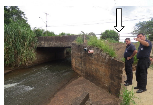
FOTO 31. Vista, de jusante para montante, da travessia sobre o córrego. Notar dimensões do vão e “rampa” construída para dar maior vazão das águas providas do sistema viário.
