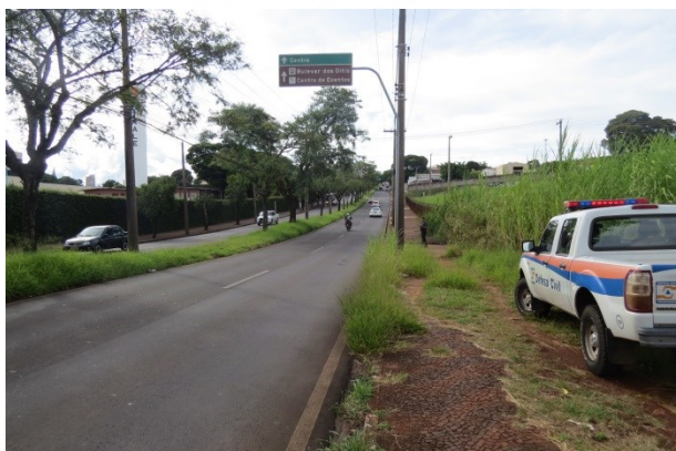
FOTO 59. Vista geral da rua Padre Anchieta em trecho frequentemente afetado por inundações do ribeirão do Ouro.
