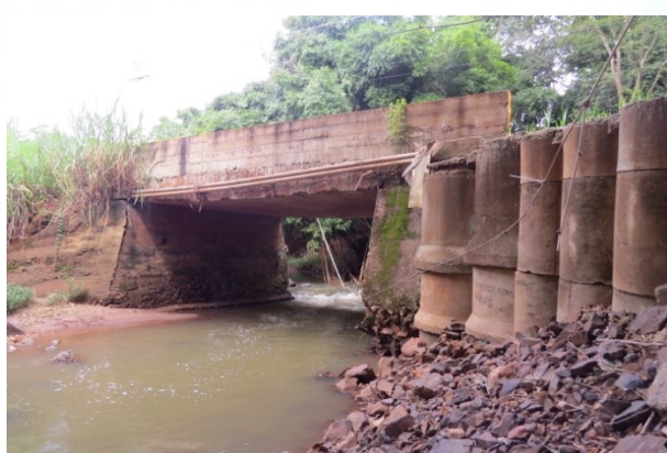
FOTO 19. Vista da ponte sobre o córrego do Ouro. Notar vão central e obras de recuperação e contenção da cabeceira da margem esquerda.
