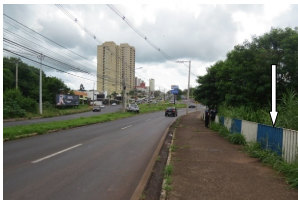
FOTO 9. Vista geral de trecho da Avenida Padre Francisco Sales Colturato bastante afetado pelas inundações do ribeirão das Cruzes. Segundo dados da COMDEC as águas podem atingir cerca de 0,40 m de lâmina d'água. A seta indica o guarda corpo de montante da ponte.
