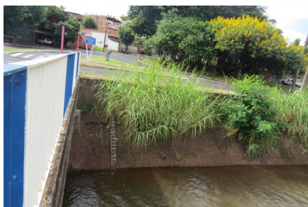
FOTO 53. Vista de régua instalada próxima a cabeceira de ponte. Notar que a vegetação chega a cobrir parte da régua de referência.
