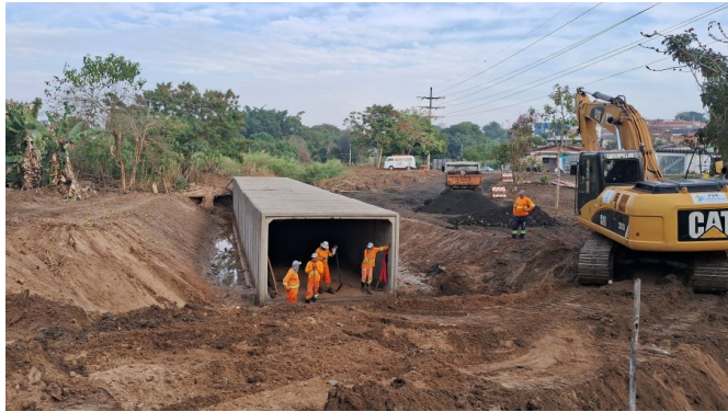
Preparação da base para muro ala
