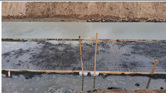
Execução do lastro de concreto magro
