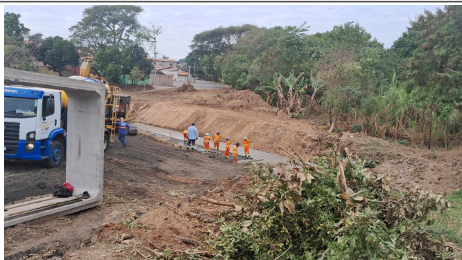
Execução do lastro de concreto magro
