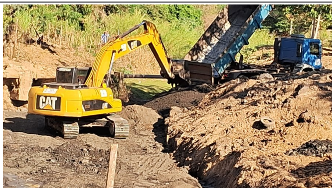
Reforço da base com camada de rachão.
