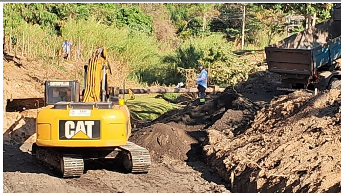
Reforço da base com camada de rachão.
