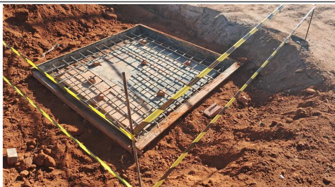
execução de tampa do segundo PV (substituição da BL da esquina no prolongamento da rua)
