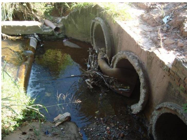
**FIGURA 146: Obstrução de Tubulações Acarreta na Diminuição da Capacidade de Drenagem**
