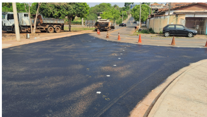
Pintura ligante para execução de capa de rolamento
