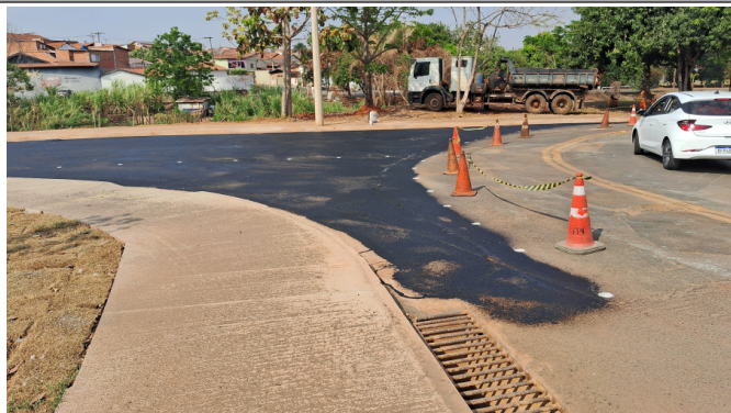
Pintura ligante para execução de capa de rolamento
