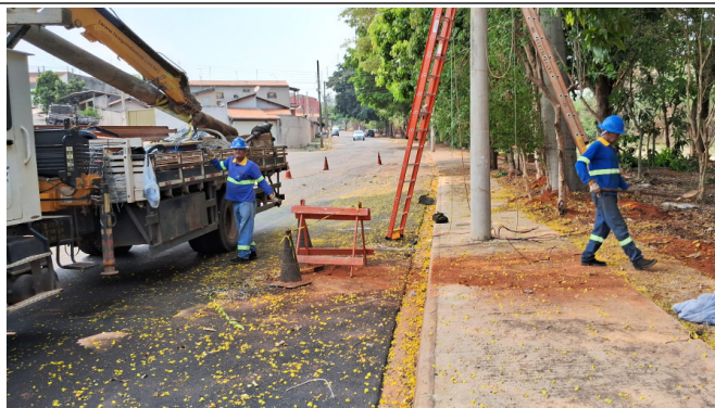
Retirada do poste de iluminação da pista de rolamento.
