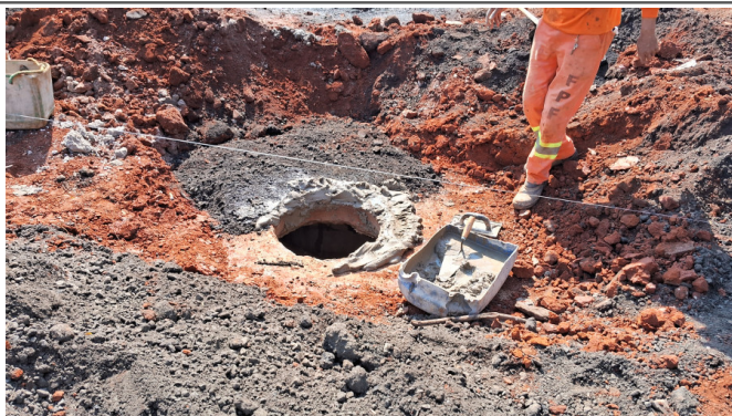
Elevação do pescoço do poço de visita
