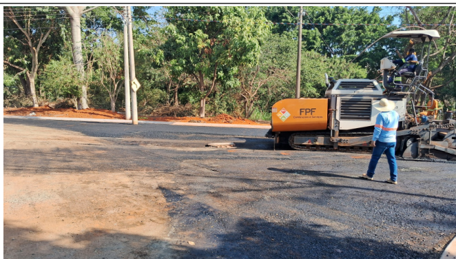
Execução da camada de binder
