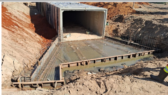
Forma, armadura e concretagem da base dos muros-ala
