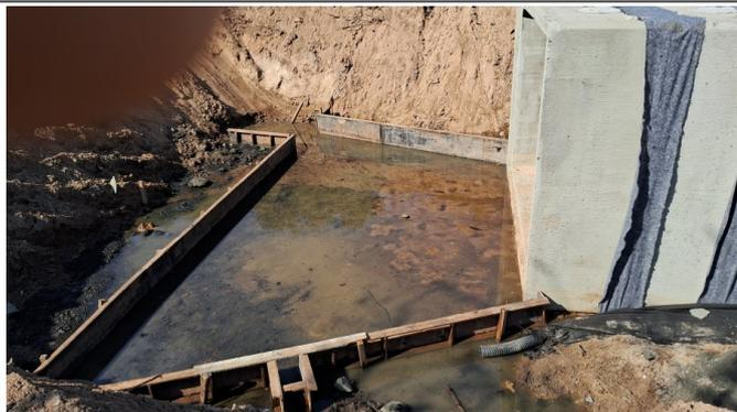
Montagem de formas para execução dos muros-ala
