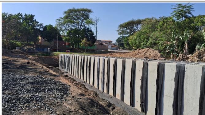
vista lateral - drenos (tubos dreno perfurados, vala com enchimento de brita e encapsulamento com manta geotextil
