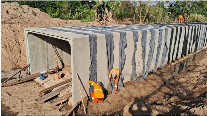
Fixação de manta geotextil nas junções argamassadas das aduelas
