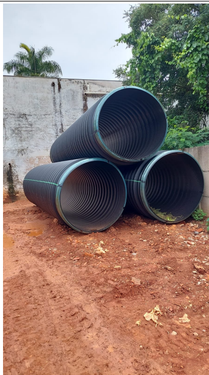
01/12/2022 - Andamento da obra
