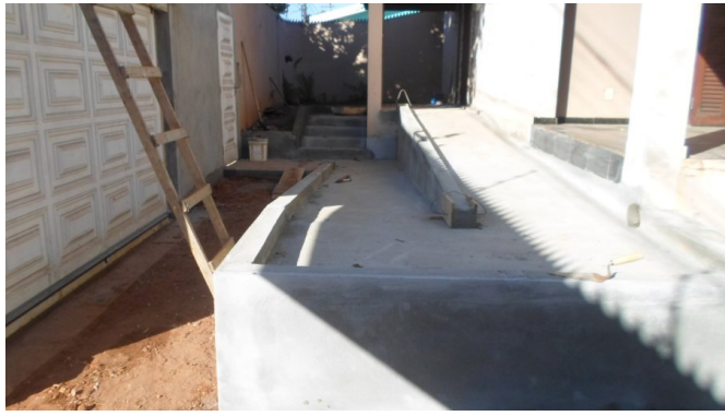
Execução de rampa de acesso e ajuste do layout do muro da fachada, execução de acabamento
