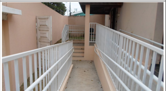
Instalação de guarda-corpos e corrimãos.
