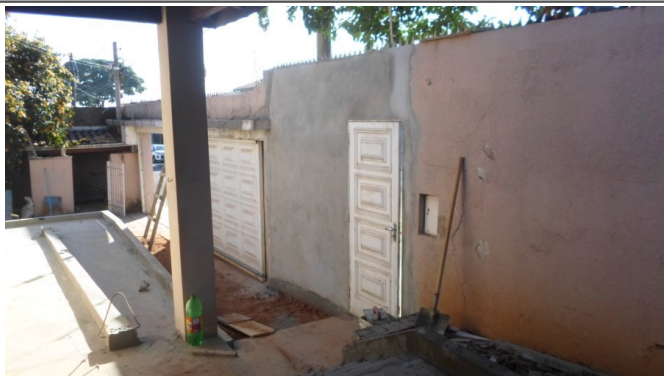
Execução de rampa de acesso e ajuste do layout do muro da fachada, execução de acabamen.
