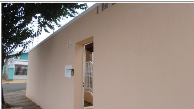
Adequação do muro da fachada e pintura.
