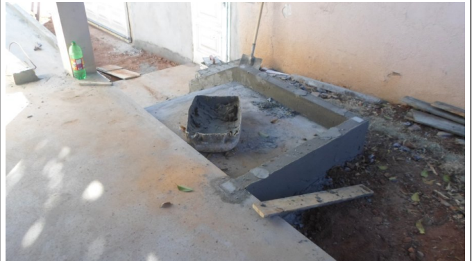
Execução de rampa de acesso e ajuste do layout do muro da fachada, execução de acabamen...
