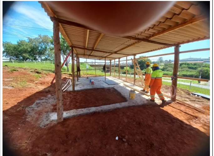
Execução do Canteiro de Obras
