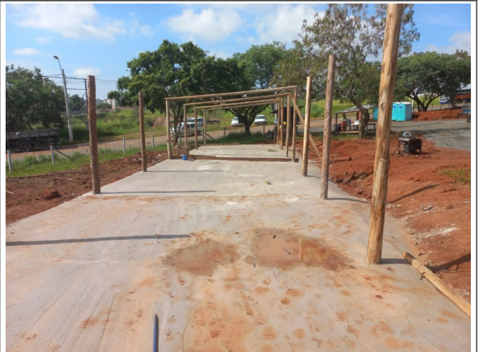
Piso da área de escritório, laboratório, refeitório e segurança do trabalho.
