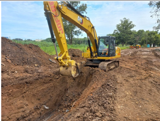
Escavação para rede de drenagem.
