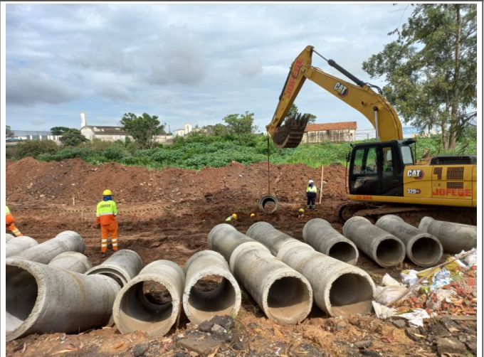
Colocação de tubos de concreto para rede de drenagem.
