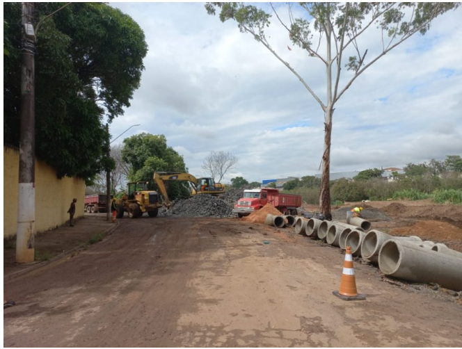
estoque de tubos de concreto para rede de drenagem
