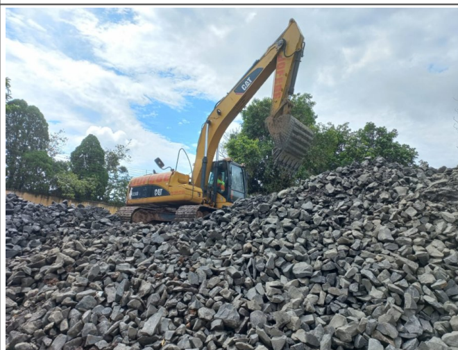
Armazenamento de materiais de pedra de mão para muro gabião
