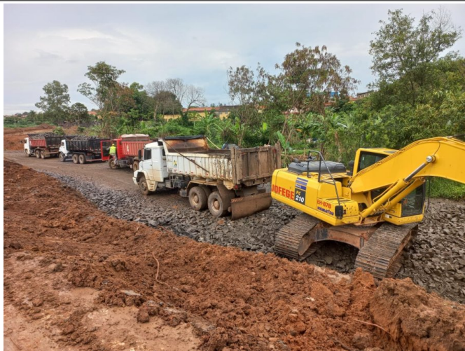
Preparo de acesso para obra
