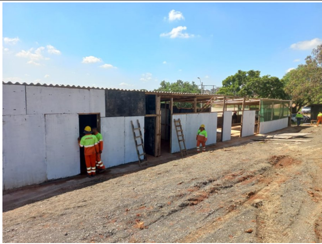
Canteiro de Obras
