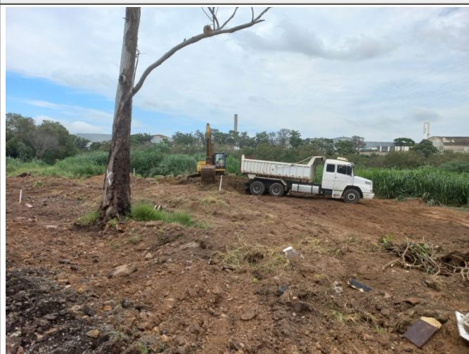
Corte de Arvores e Limpeza de vegetação.
