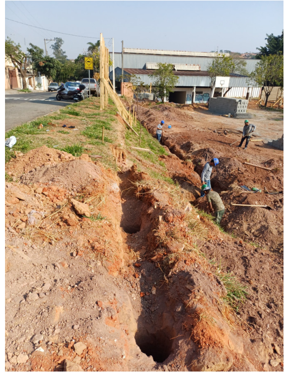
Execução da fundação do muro de arrimo (entre B8 e B33 - Fl.35/45 Estrutural).
