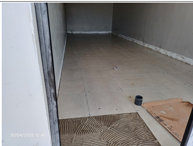
Aplicação de revestimento cerâmico nas salas (construção existente).
