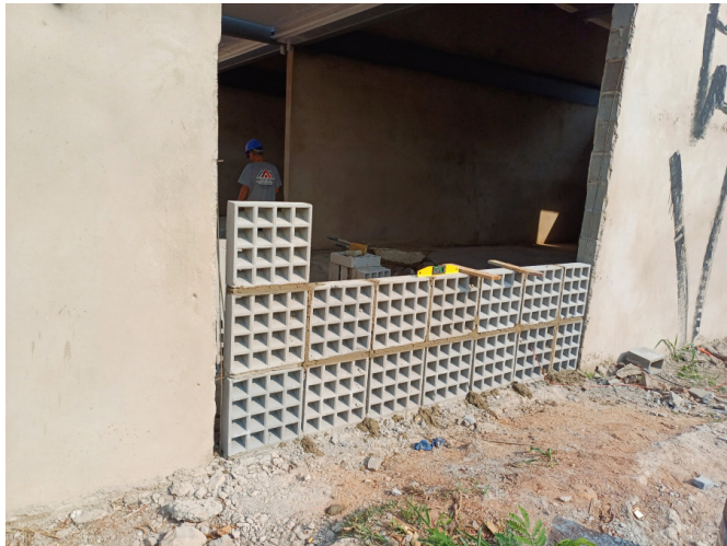
Execução do elemento vazado.
