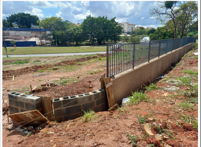
Continuação da elevação do muro de arrimo.
