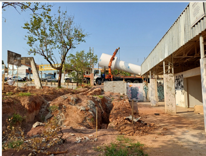
Instalação da caixa d'água.
