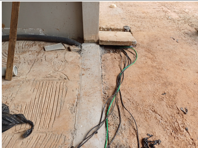
Instalação de cabos de cobre.
