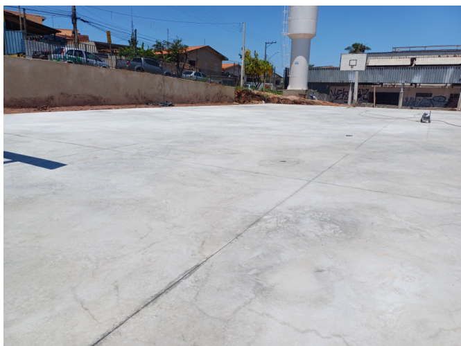
Execução da quadra externa.
