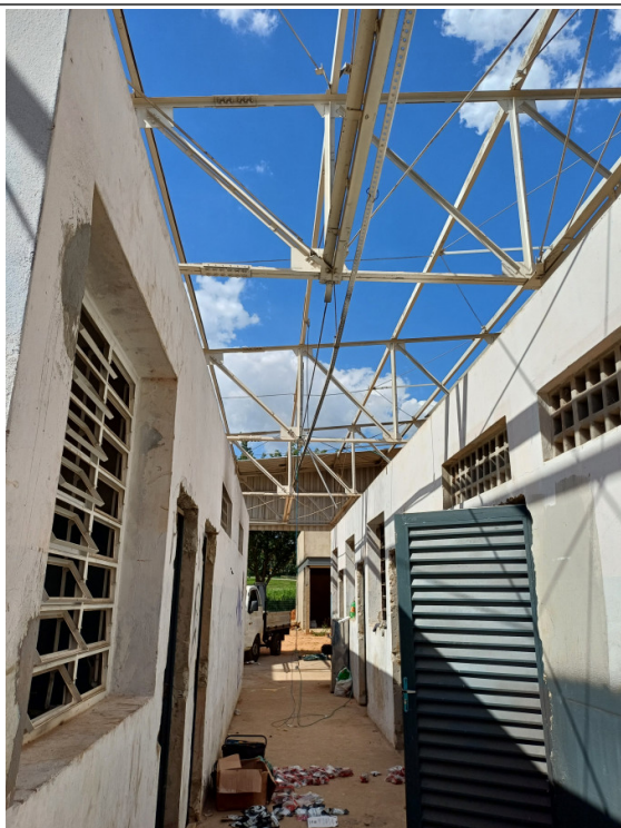
Substituição das telhas deterioradas.
