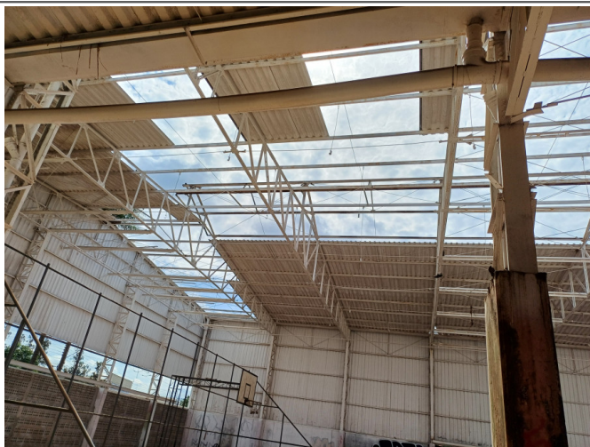
Substituição das telhas deterioradas.
