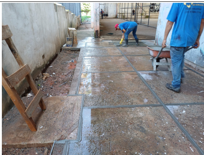
Aplicação do granilite (área existente).
