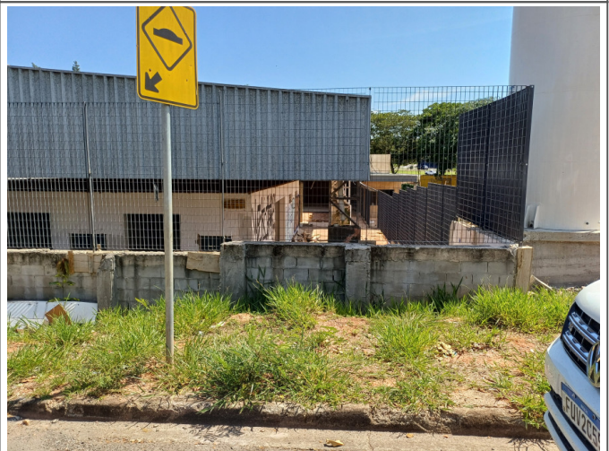
Instalação do gradil.
