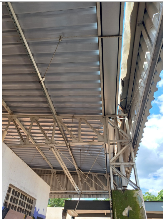
Substituição das telhas deterioradas.
