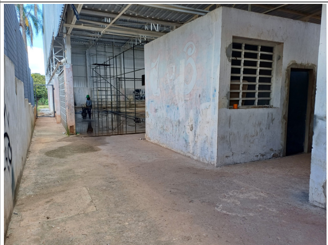
Hidrojateamento da estrutura metálica e telhas laterais.
