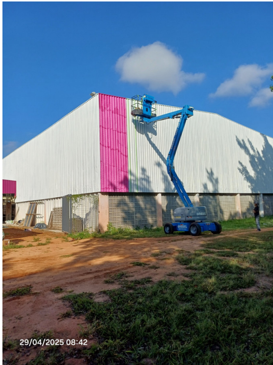
Pintura lateral externa (fundos da quadra coberta).
