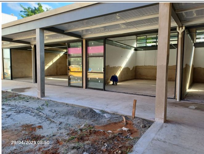
Execução do rodapé (ampliação).
