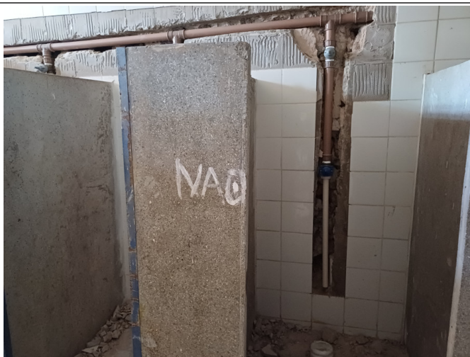
Execução das instalações hidráulicas.
