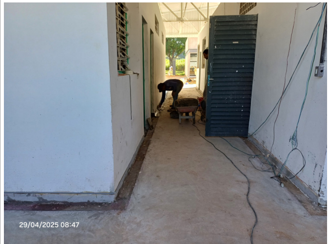
Execução do rodapé (construção existente).
