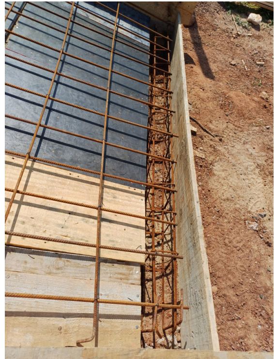
Preparação: armação da ferragem para concretagem da escada.
