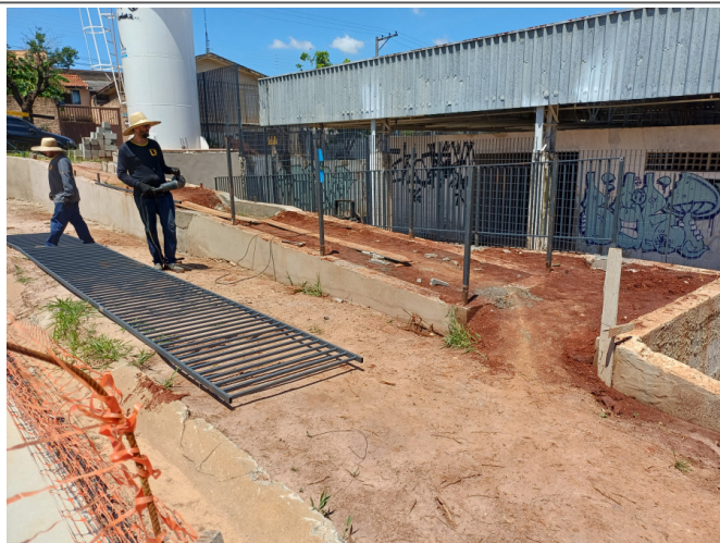
Instalação dos gradis.
