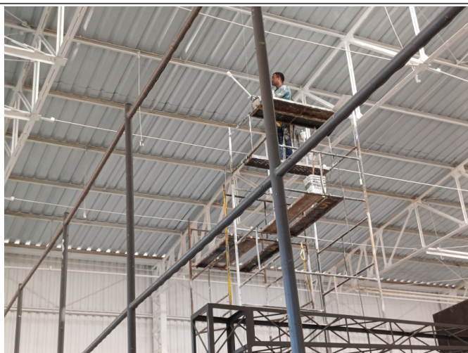
Pintura interna da estrutura metálica.
