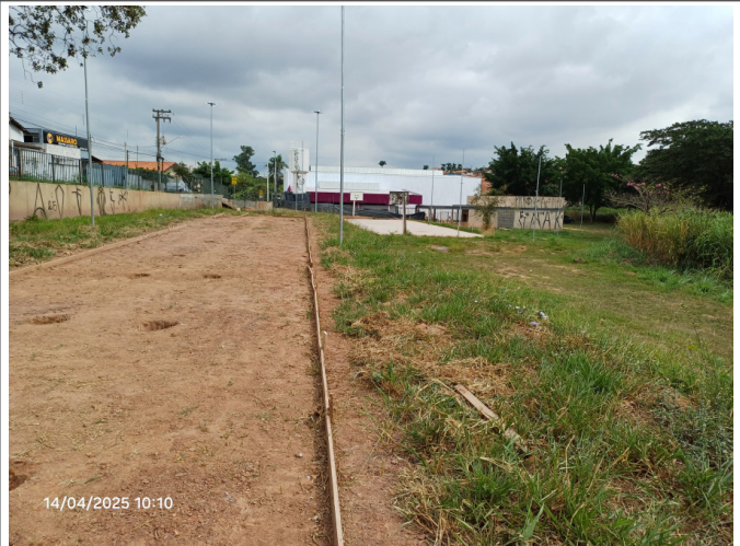
Escavação das brocas para o piso base dos equipamentos de exercício.
