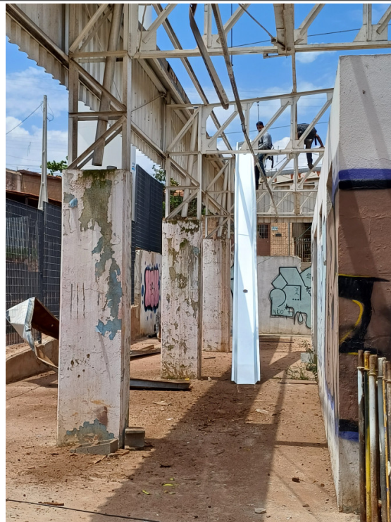
Substituição das telhas deterioradas e instalação das calhas.
