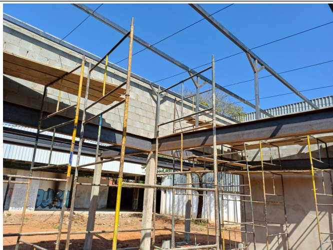
Montagem das terças para suporte do telhado da ampliação.
