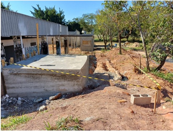
Base da caixa d'água.
