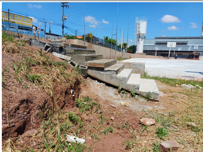
Concretagem da escada.
