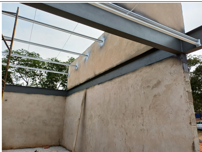
Pintura da estrutura metálica da ampliação.
