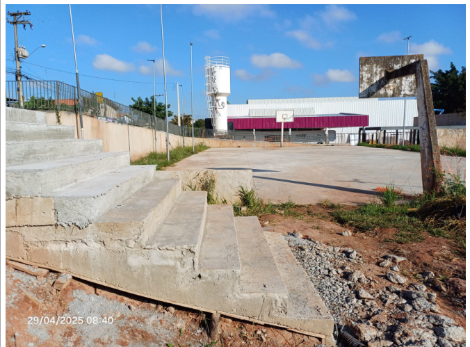
Ajuste dos degraus da escada.
