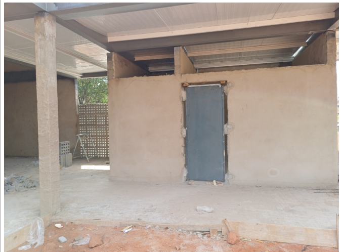
Instalação da porta metálica da ampliação.
