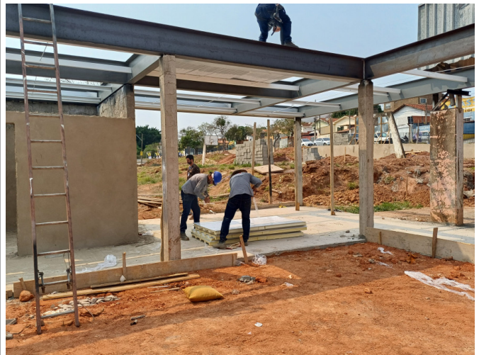
Instalação das telhas da cobertura.
