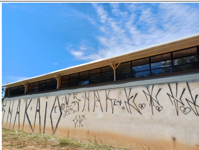
Instalação das esquadrias de alumínio e vidro (ampliação).
