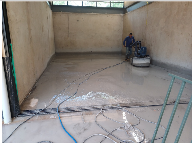
Polimento do granilite (ampliação).
