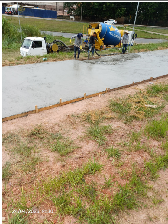
Concretagem do piso base para os equipamentos.
