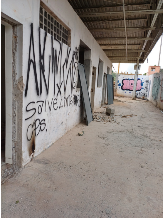
Instalação das portas metálicas.
