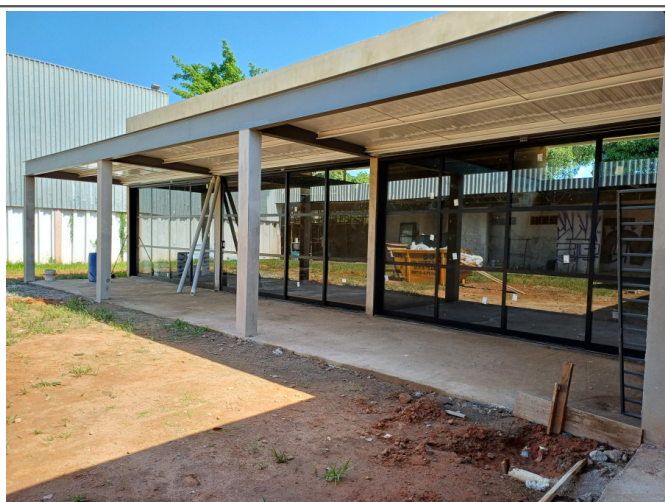
Instalação das portas de alumínio e vidro.
