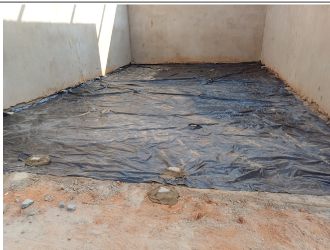
Preparação para execução do contrapiso da ampliação.
