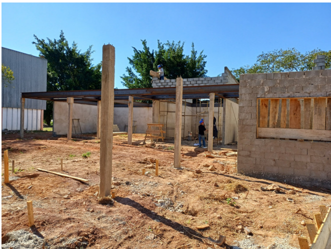
Execução dos pilares da ampliação e posicionamento das vigas metálicas.
