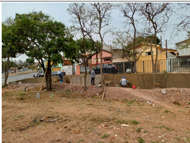
Execução do reboco do muro de arrimo.
