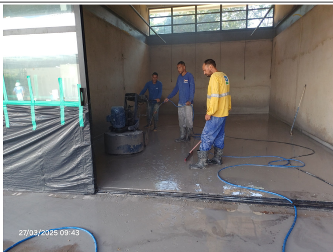
Continuidade no polimento do granilite (ampliação).
