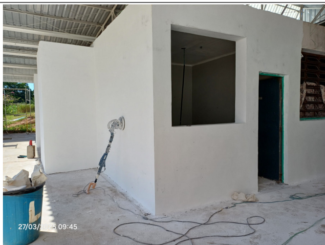
Aplicação e lixamento de massa látex.
