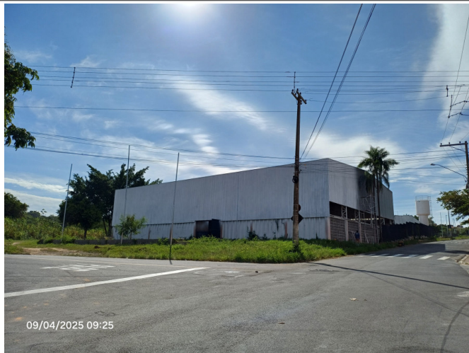
Aplicação de fundo na fachada.
