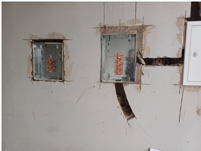
Instalação das caixas de elétrica.
