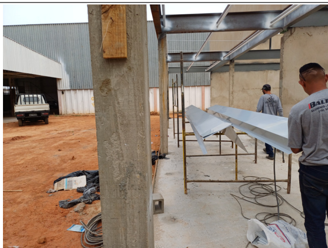
Instalação das calhas.
