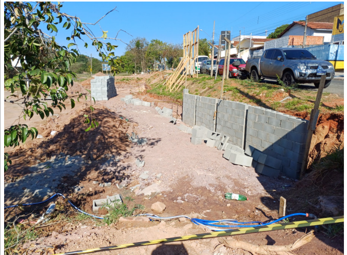
Execução da alvenaria do muro de arrimo (entre B8 e B33 - Fl.35/45 Estrutural).
