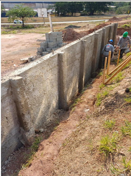
Chapisco do muro de arrimo (entre B8 e B33 - Fl.35/45 Estrutural).
