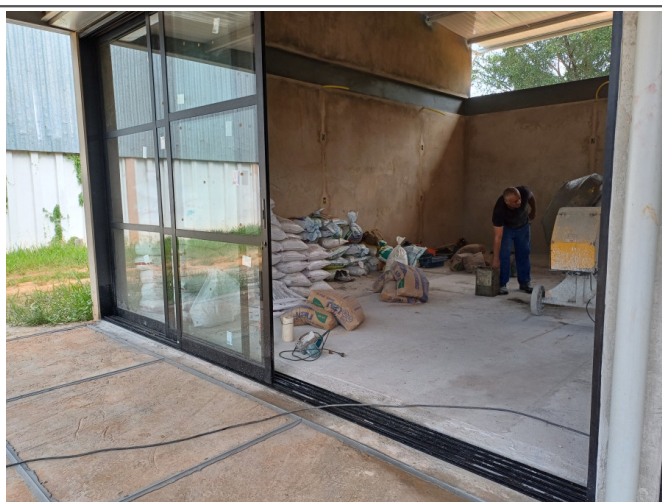
Aplicação do granilite (ampliação).
