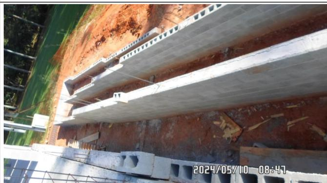
Elevação da alvenaria da rampa de acesso ao Palco.
