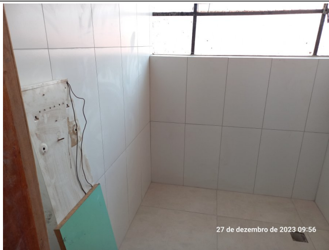
Execução do rejunte no sanitário PCD de Obras.
