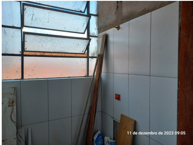
Revestimento cerâmico no sanitário PCD de Obras.
