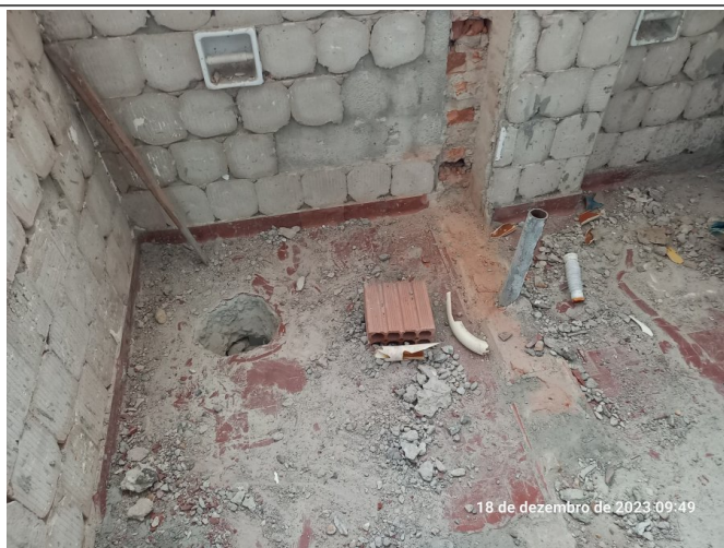
Execução dos furos na laje do sanitário da Comunicação.
