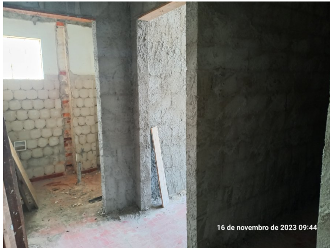
Execução da alvenaria no banheiro PCD da Comunicação.
