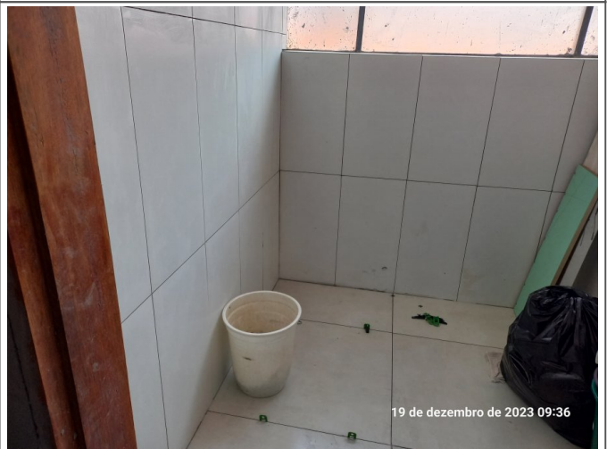
Piso cerâmico colocado no sanitário PCD de Obras.
