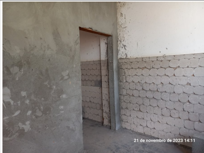
Reboco executado na copa da Comunicação.
