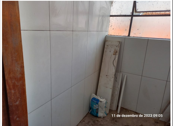
Revestimento cerâmico no sanitário PCD de Obras.
