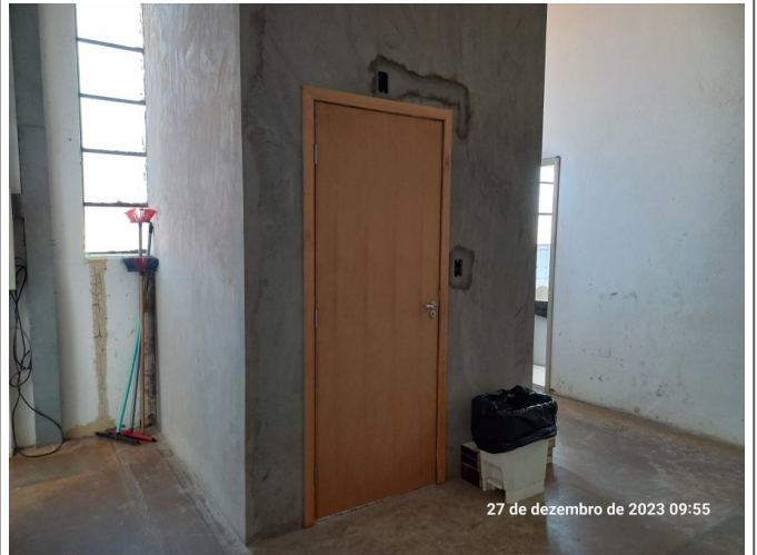
Instalação da porta do sanitário PCD de Obras.
