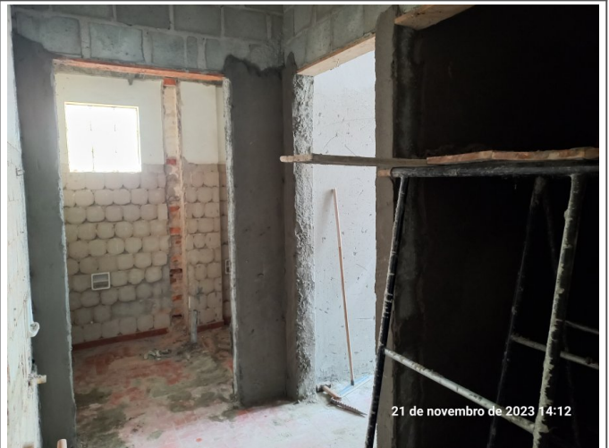
Reboco executado no sanitário PCD da Comunicação.
