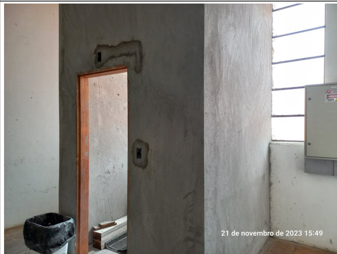
Instalação de caixas elétricas no sanitário PCD de Obras.
