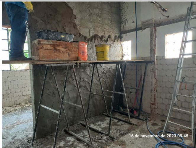
Execução da alvenaria e do revestimento na copa da Comunicação.
