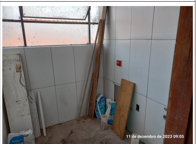
Revestimento cerâmico no sanitário PCD de Obras.
