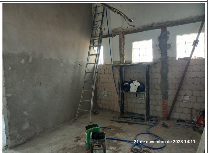
Reboco executado na copa da Comunicação.
