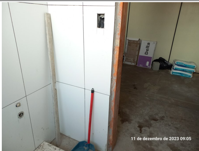
Revestimento cerâmico no sanitário PCD de Obras.
