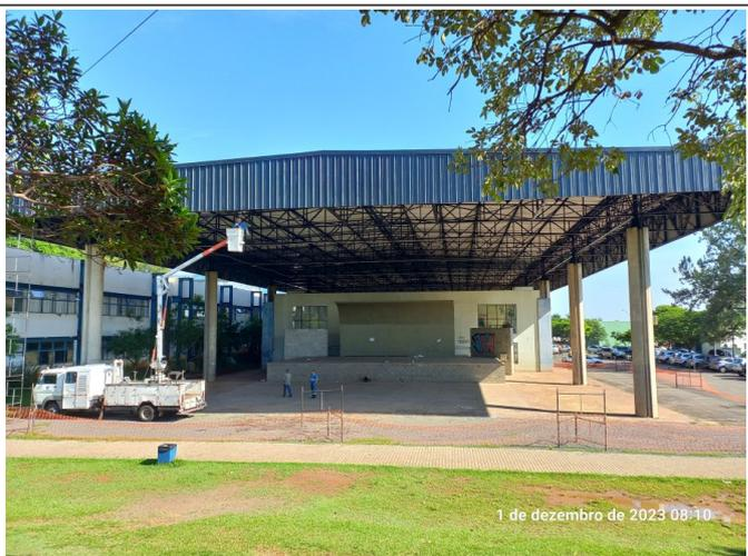
Remoção das luminárias para instalação da tela antipombo.
