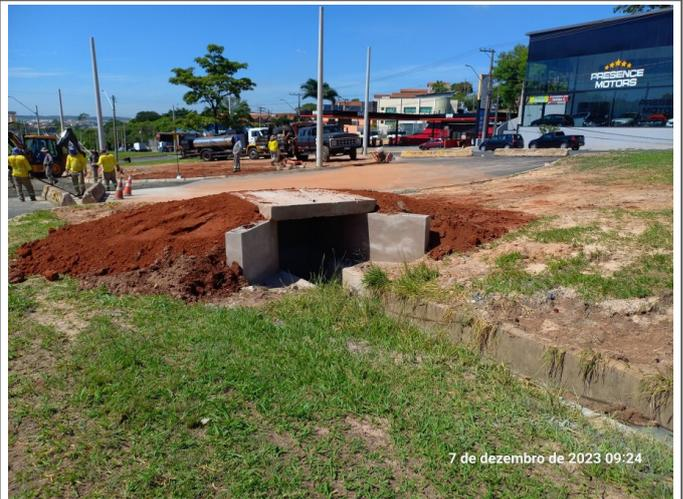
Adaptação de PV, com muro ala.
