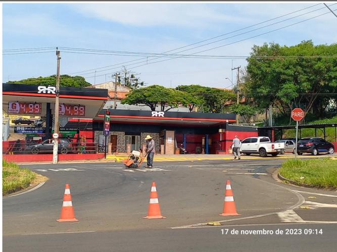
Corte no pavimento do canteiro central para passagem de tubulação elétrica.
