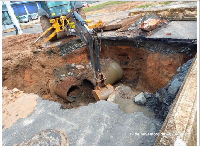
Adaptação do PV para a tubulação de 1000mm.
