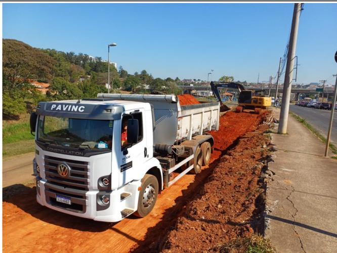
Aterro e compactação do solo em talude onde será executado uma nova calçada.
