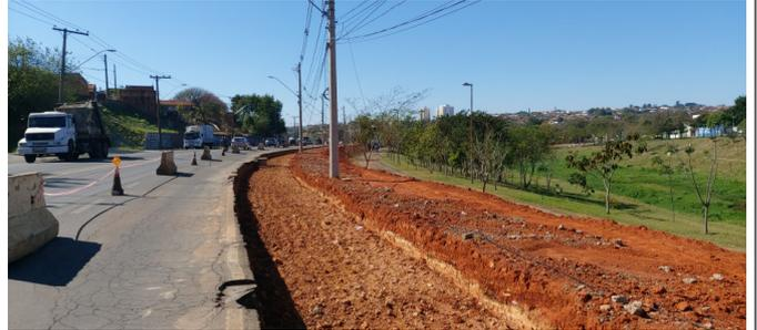
Escavação. Abertura de caixa para execução de pavimento.
