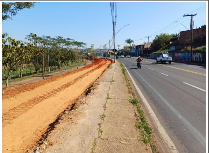
Escavação e compactação de talude.
