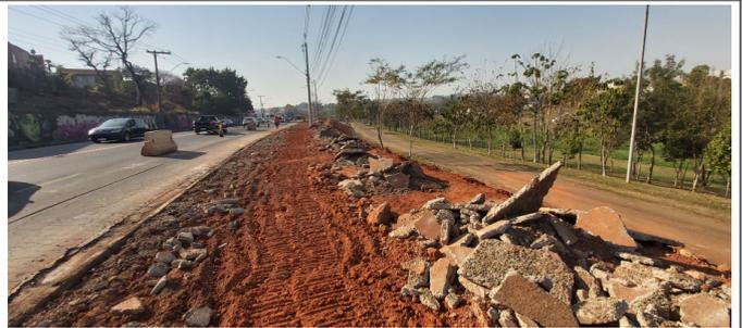
Demolição de calçada existente para alargamento da via.
