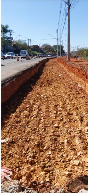
Escavação. Abertura de caixa para execução de pavimento.
