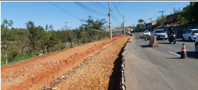
Escavação. Abertura de caixa para execução de pavimento.
