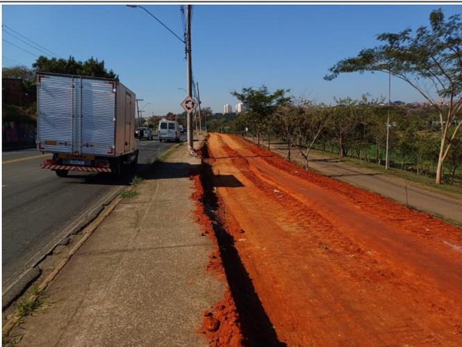
Escavação e compactação de talude.
