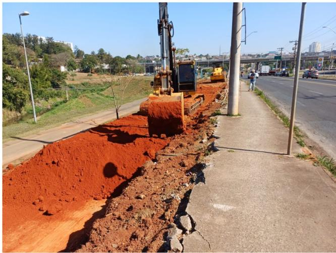
Escavação e aterro em talude.
