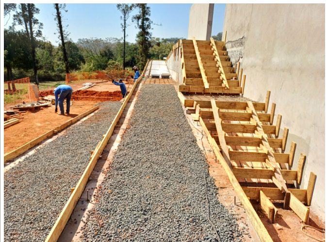
Preparação da rampa para concretagem.
