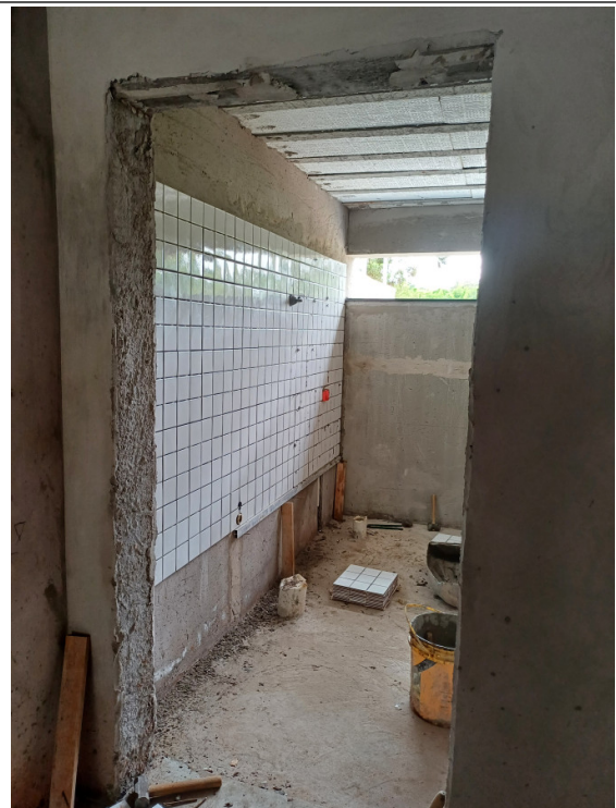
Aplicação de revestimento nos sanitários.
