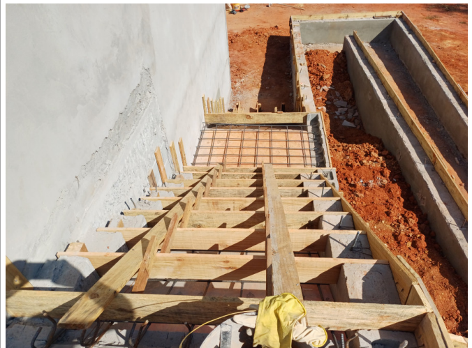
Execução da forma da escada.
