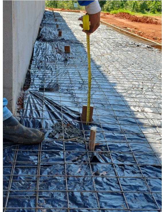
Preparação para concretagem externa.
