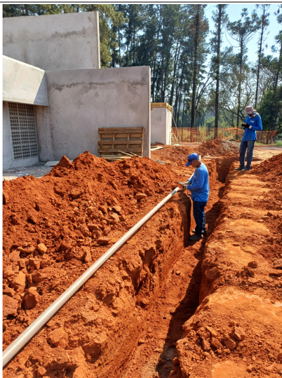
Instalação da tubulação de alimentação da hidráulica.
