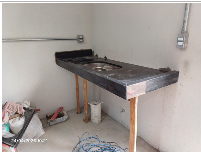
Instalação da pia de granito preto São Gabriel.
