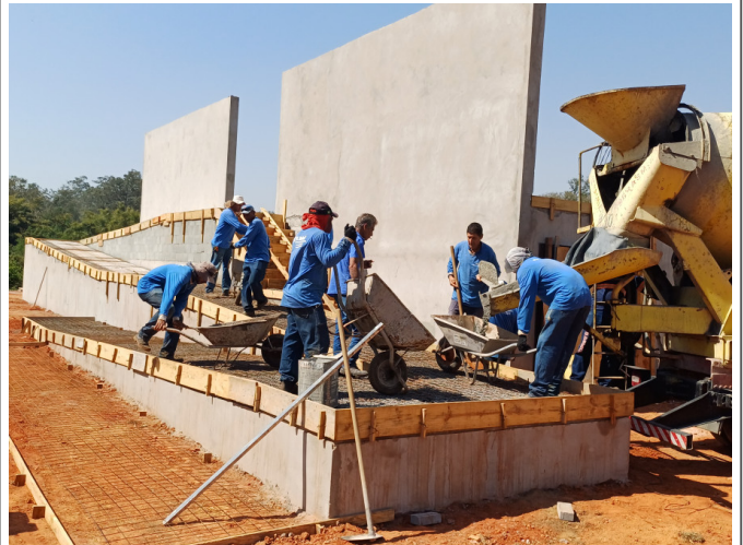
Concretagem da rampa.
