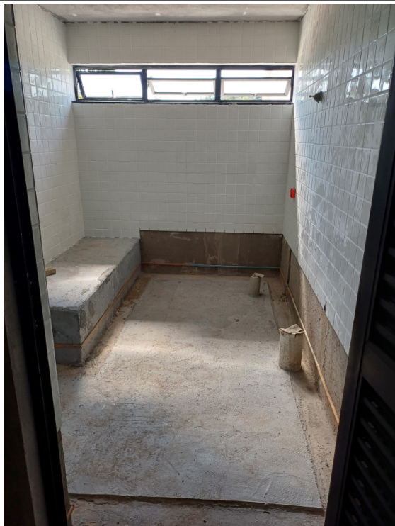
Execução do granilite dos sanitários.
