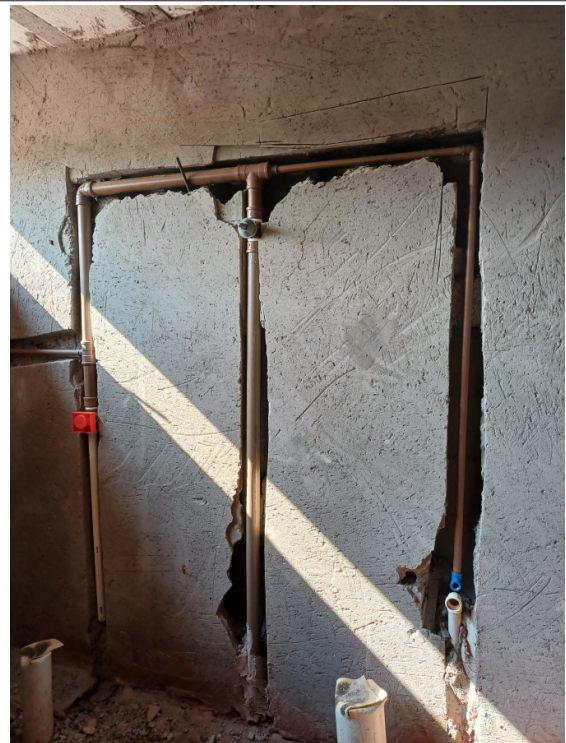
Montagem da hidráulica interna.
