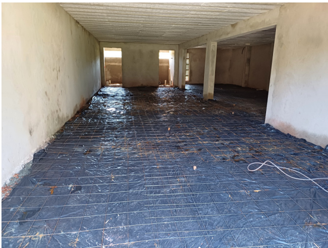
Preparação para concretagem do piso interno.
