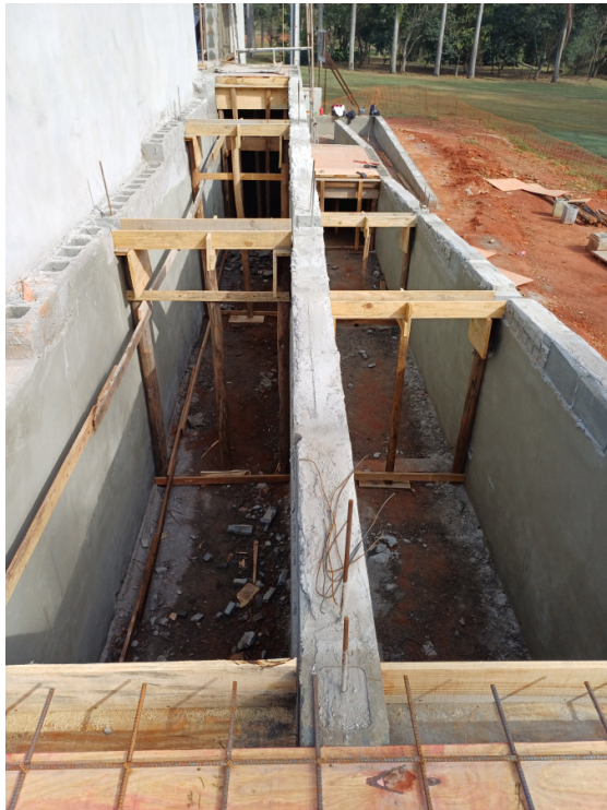
Escoramento das formas para execução da rampa.
