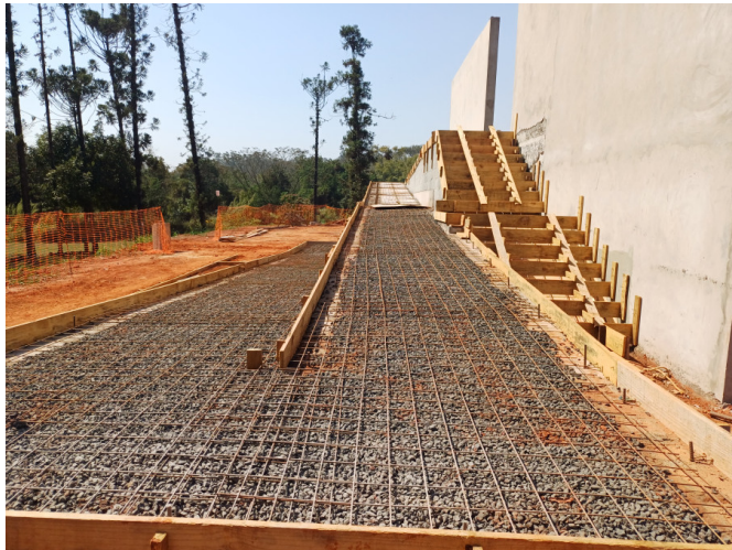
Armação da rampa para concretagem.
