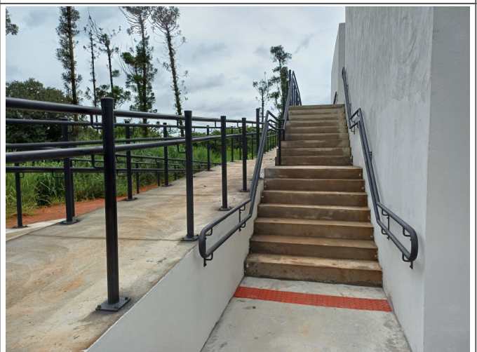
Aplicação de piso podotátil.
