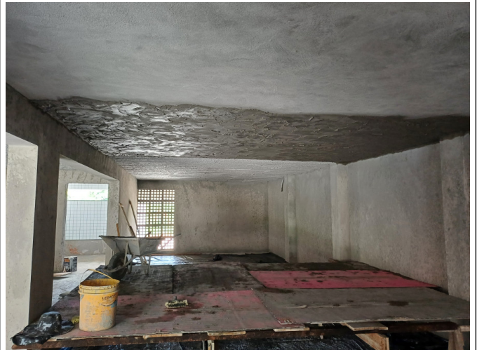
Execução de reboco do teto.
