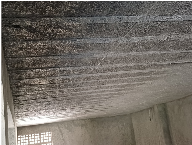
Aplicação de chapisco no teto.
