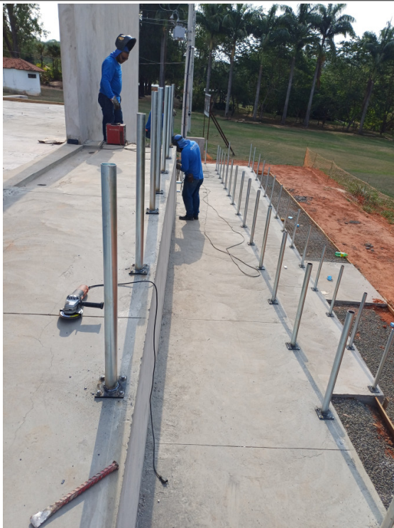
Montagem dos montantes do corrimão.
