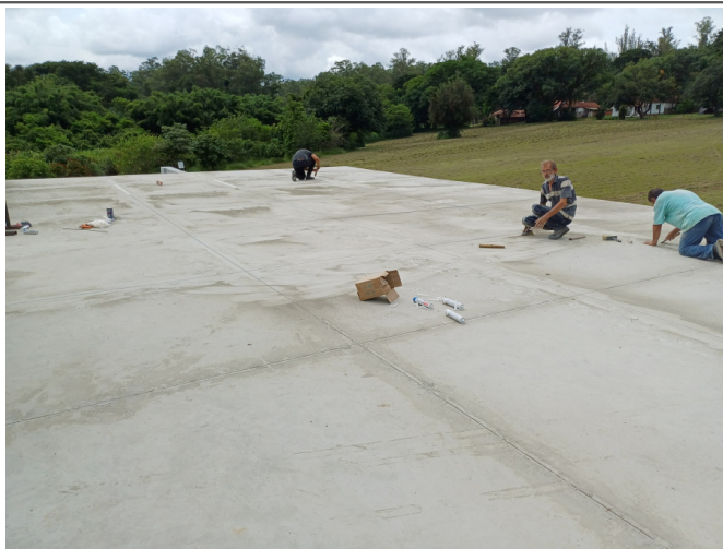
Tratamento do piso da laje e aplicação de PU.
