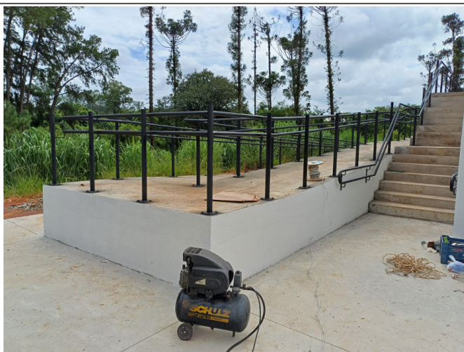
Pintura dos corrimãos.
