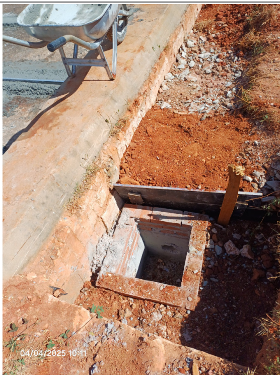
Execução de caixa de passagem.
