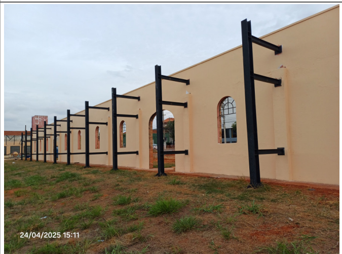
Pintura da face interna do paredão.
