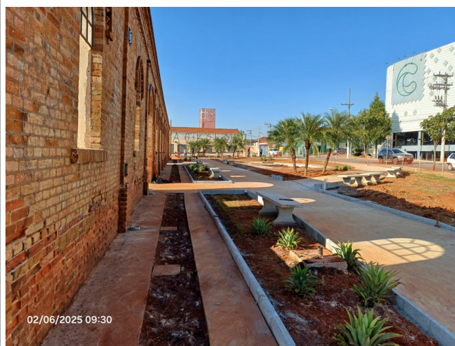
Execução do paisagismo.
