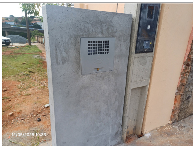
Aguardando ligação de água por parte da concessionária.
