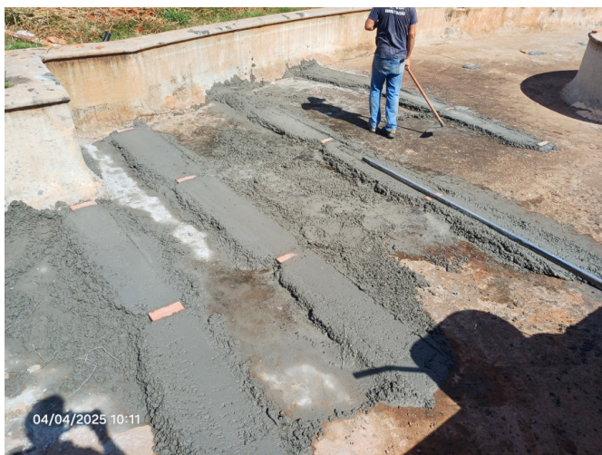
Regularização da base da fonte.
