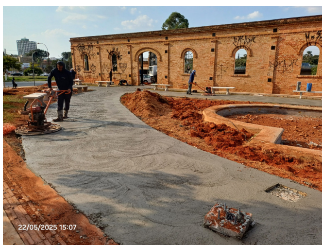
Concretagem e execução do acabamento das calçadas.
