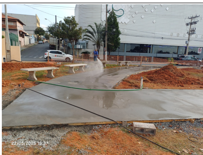
Execução de cura úmida das calçadas.
