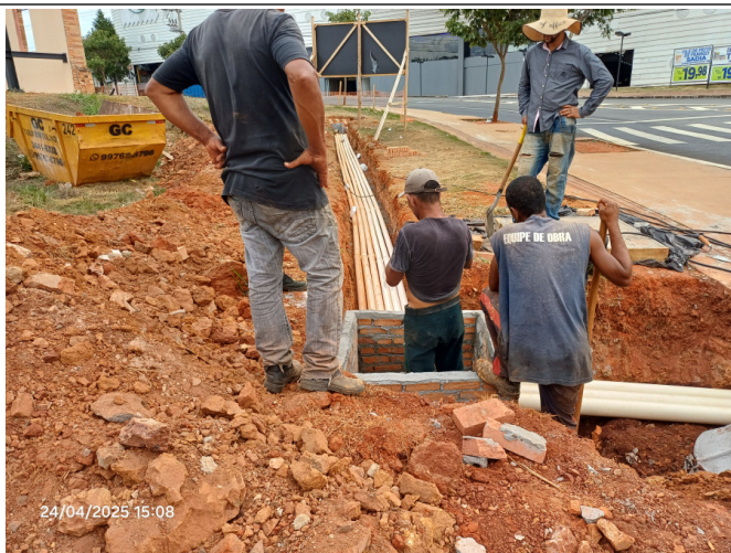
Instalação da tubulação para drenagem das águas pluviais.
