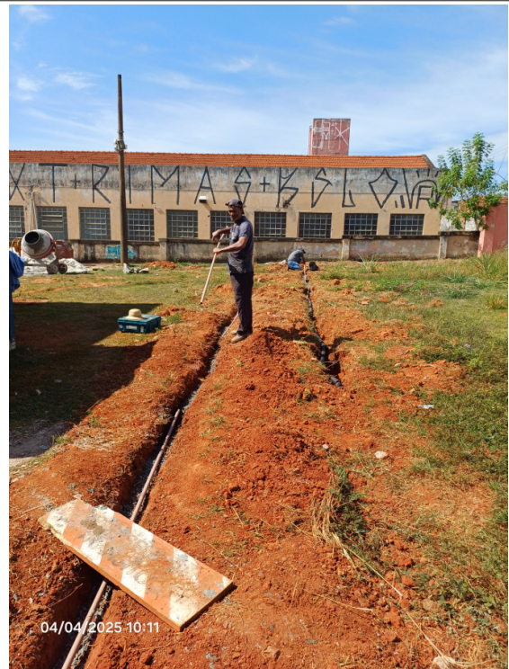
Instalação de tubulação de água fria.
