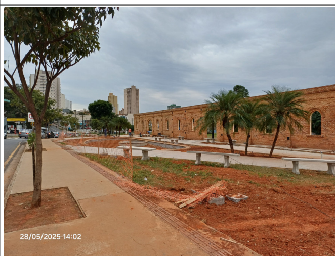
Execução do paisagismo.
