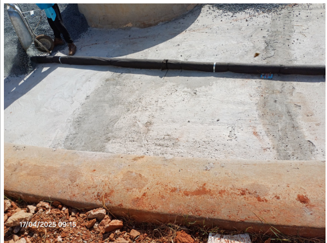
Aplicação de tubo dreno e manda geotêxtil.
