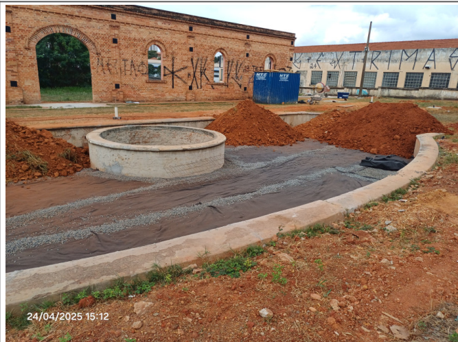
Aplicação da manta geotêxtil sobre a camada de brita para impedir a lixiviação de finos.
