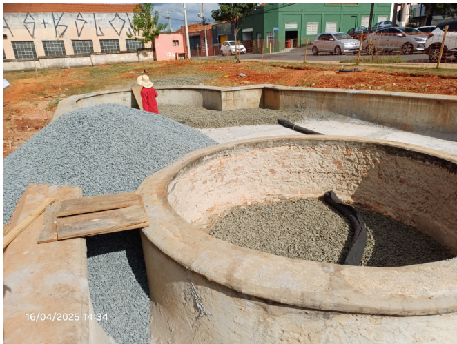
Aplicação de brita para o dreno.
