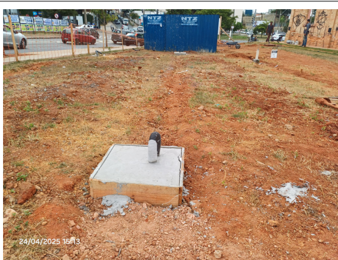
Concretagem dos blocos bases dos postes de iluminação.
