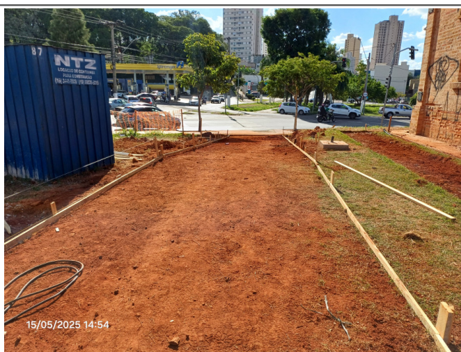
Execução de gabarito para concretagem das calçadas.
