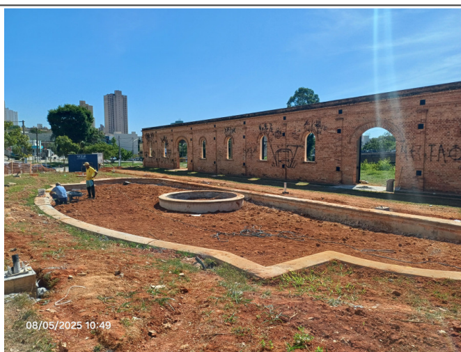
Concluída a aplicação de camada de terra na fonte.
