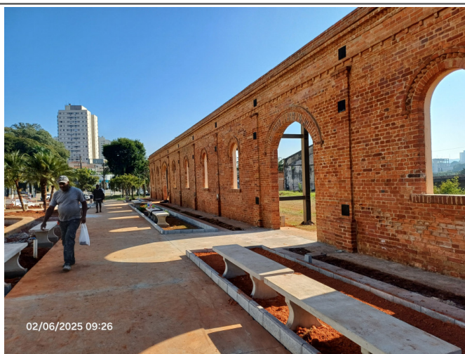
Instalação dos bancos de concreto, mini guias de concreto e aplicação de verniz anti-pichação.
