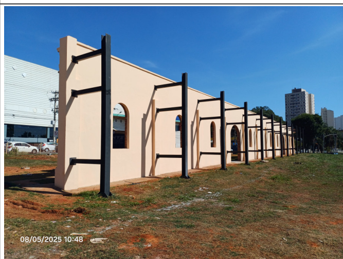
Concluída a pintura da face interna do paredão.
