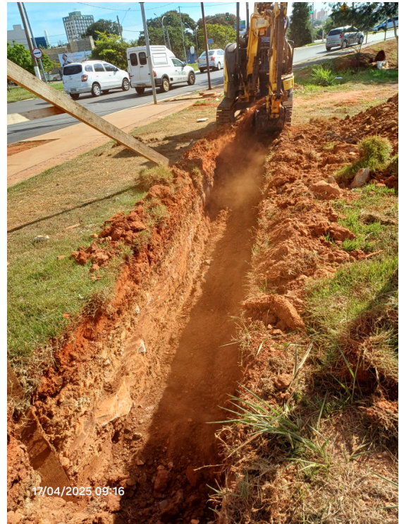
Escavação para passagem da tubulação de condução de águas pluviais.
