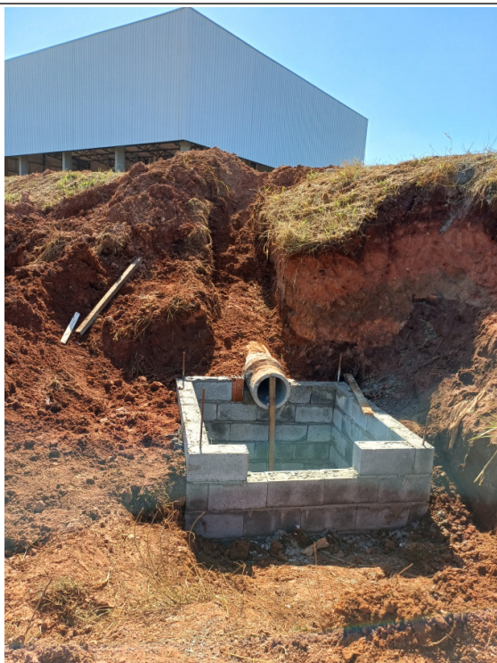
Tubulação e caixa para captação de águas pluviais.
