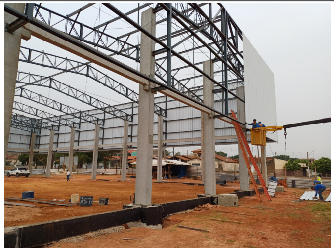
Fechamento lateral da estrutura metálica.
