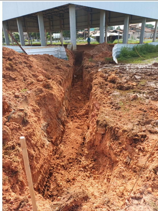
Instalação de tubulação para condução de águas pluviais.
