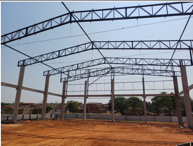
Montagem das tesouras.
