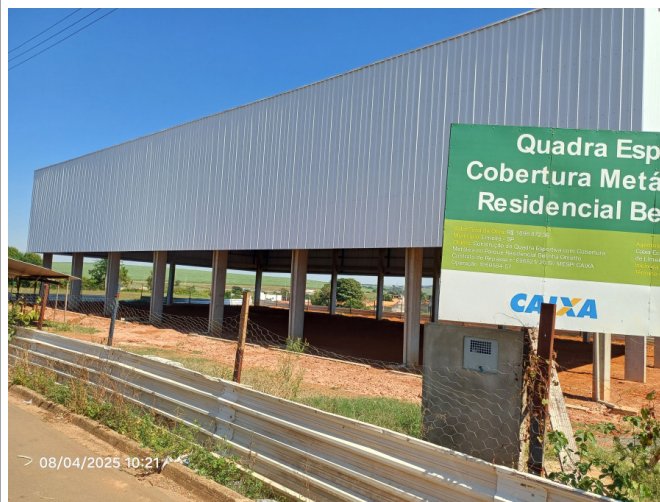
Canaletas, condutores verticais, calhas e tubulação para condução de águas pluviais, concluídos.
