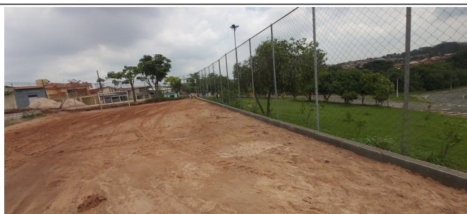
Execução de mureta no campo de areia.
