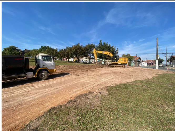
Movimento de terra. Escavação no trecho de prolongamento da Rua Placidina Ferreira Braga..
