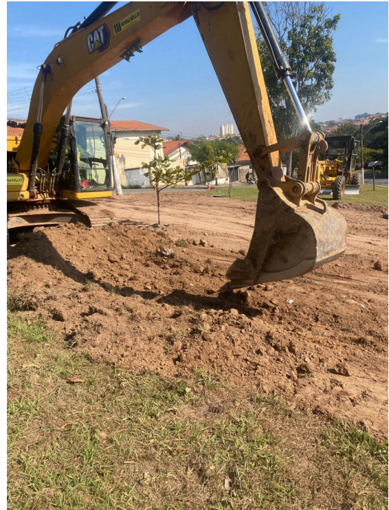
Movimento de terra. Escavação no trecho de prolongamento da Rua Placidina Ferreira Braga.
