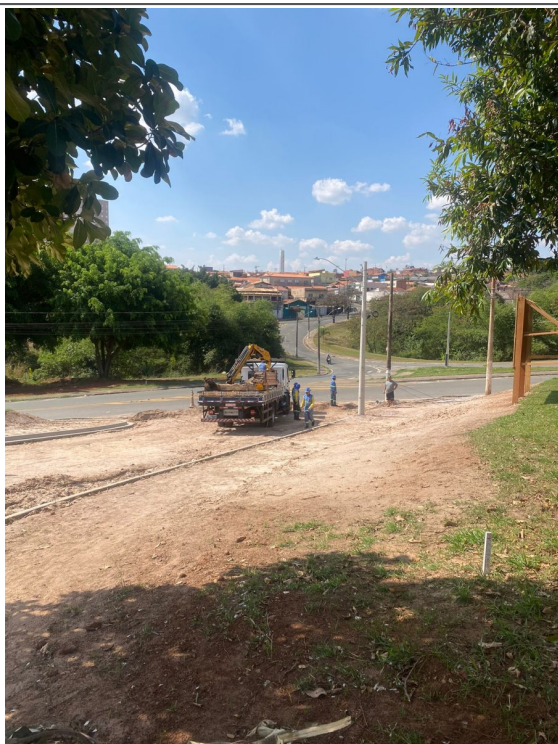
Redisposição e instalação de poste de iluminação.
