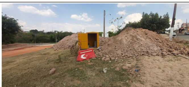
Canteiro de obra.
