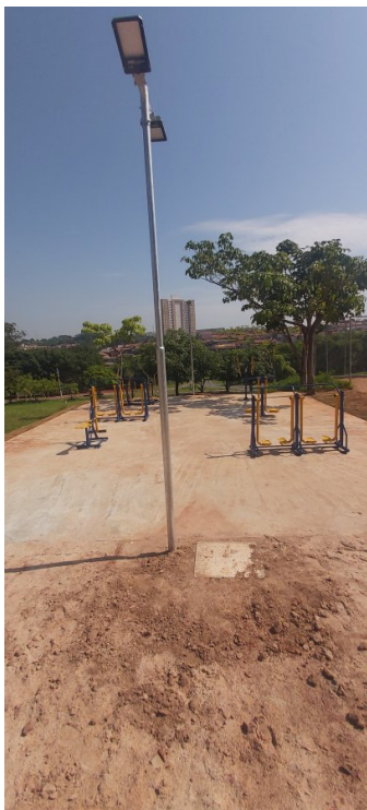
Academia ao ar livre. Instalação de poste de iluminação.
