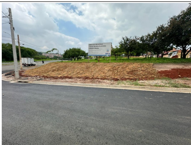
Prolongamento da Rua Placidina Ferreira Braga: Execução da camada de Concreto Asfáltico. (CBUQ).
