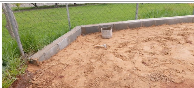
Execução de mureta no entorno do campo de areia.
