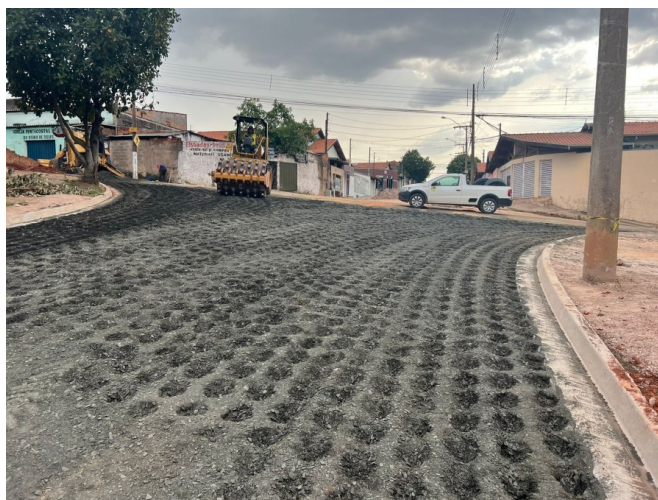
Prolongamento da Rua Placidina Ferreira Braga.: Compactação da camada de Brita Graduada (BGS).
