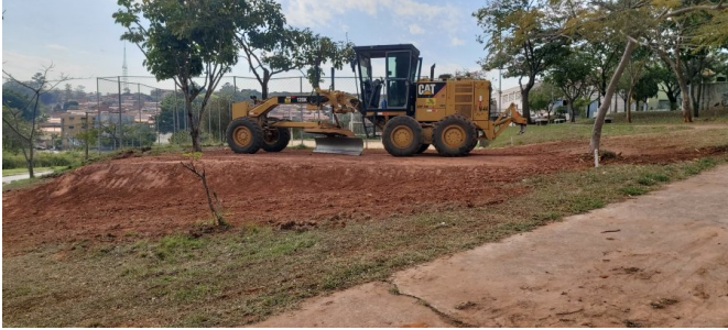
Execução de academia ao ar livre. Terraplenagem
