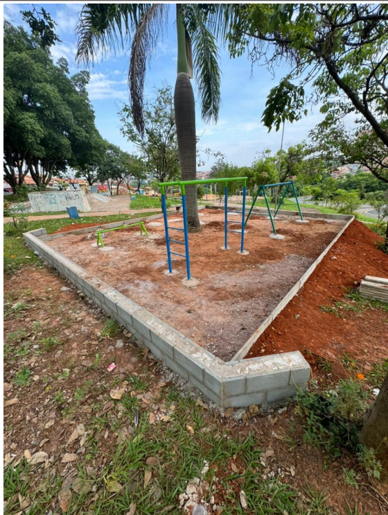
Execução de playground.
