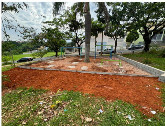
Execução de playground.
