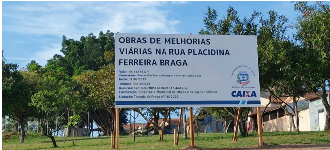
Placa de obra.
