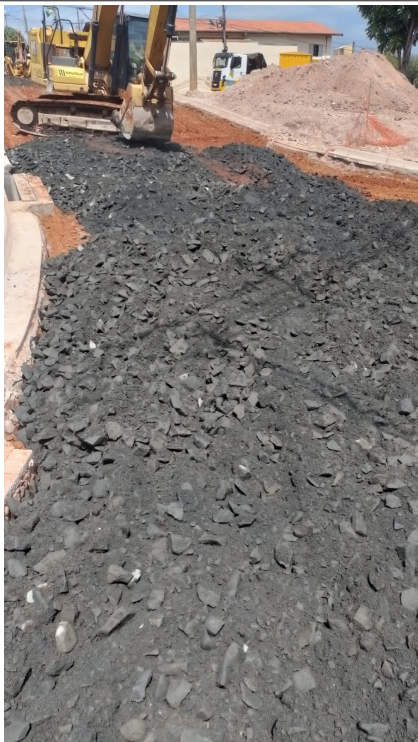
Prolongamento da Rua Placidina Ferreira Braga. Execução de lastro de rachão
