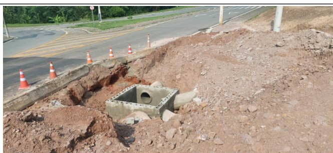
Execução de poço de visita.
