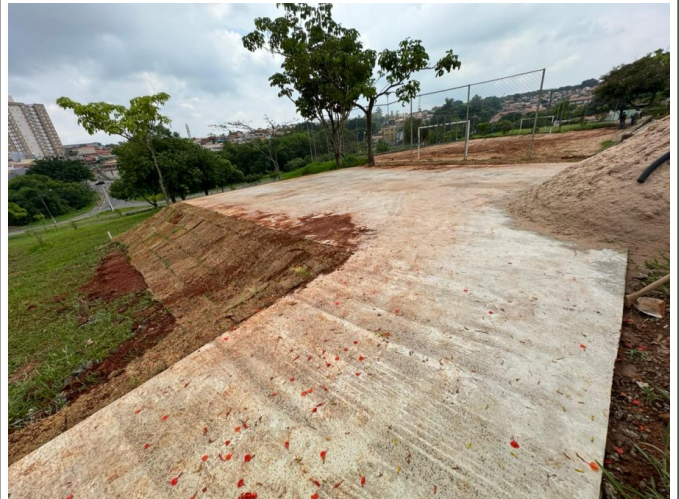
Academia ao ar livre. Execução do piso de concreto
