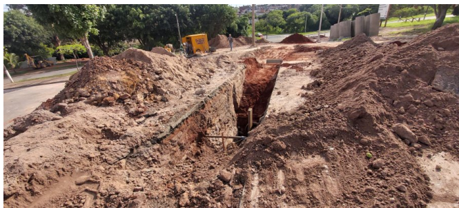
Escavação para execução de galeria de água pluvial.
