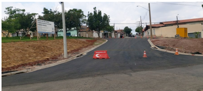
Prolongamento da Rua Placidina Ferreira Braga: Execução da camada de Concreto Asfáltico. (CBUQ)
