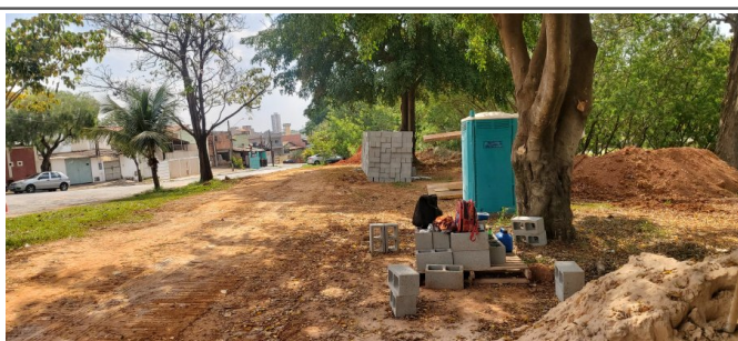
Canteiro de obra.
