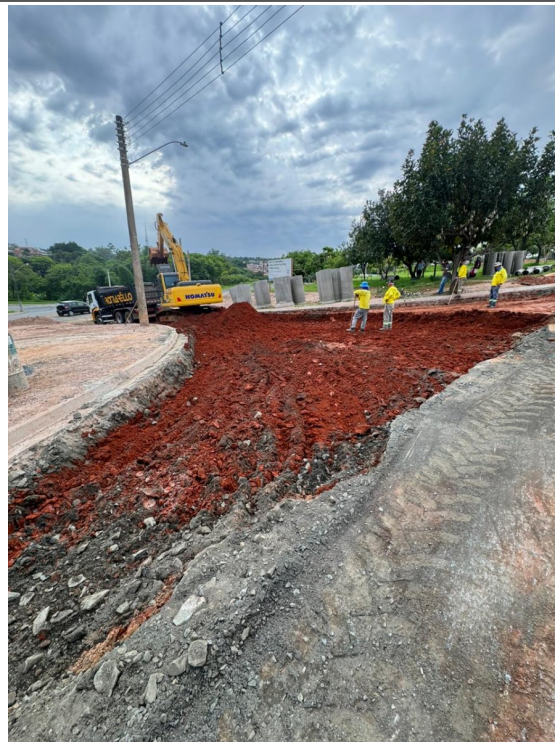
Prolongamento da Rua Placidina Ferreira Braga: Pavimentação /Abertura de caixa.
