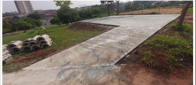
Academia ao ar livre. Execução do piso de concreto
