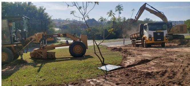
Movimento de terra. Escavação no trecho de prolongamento da Rua Placidina Ferreira Braga..
