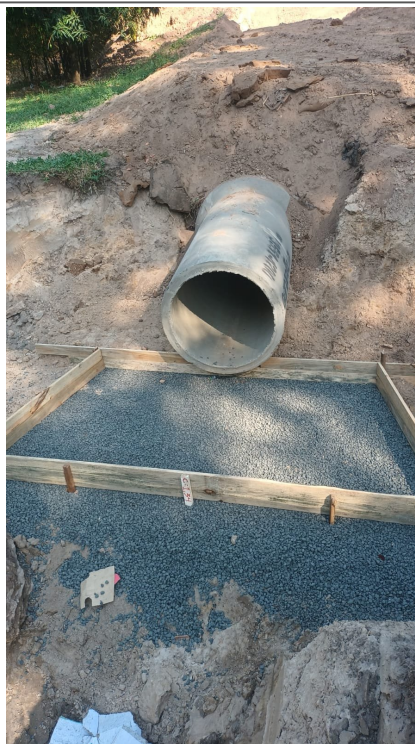
Execução da laje do muro ala.
