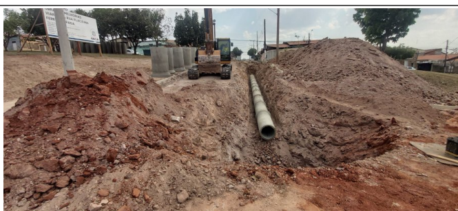
Instalação de tubos de concreto em galeria de água pluvial.
