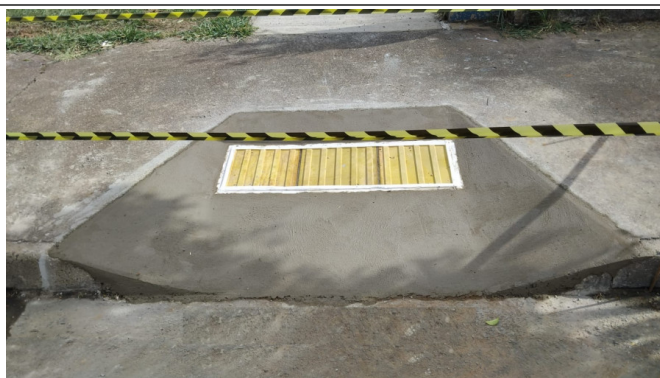
Rua Cesarino Ferreira, Vila Pizza - Rampa de acessibilidade
