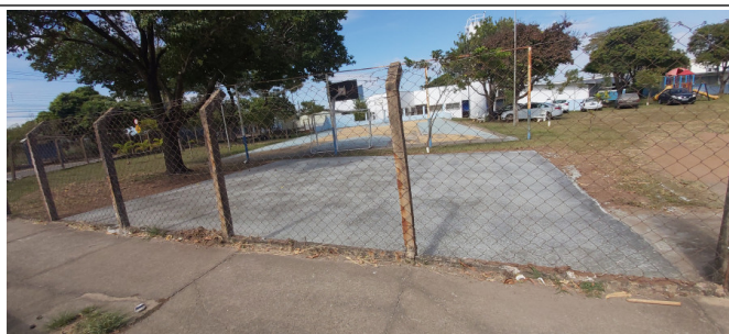
Rua José Fontanin - Jd. Nova Limeira - Execução de base de Concreto para instalação de playground
