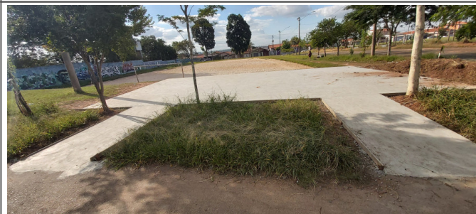
Rua Dario Roland, Pq. Novo Mundo - Execução de base de concreto para instalação de playground
