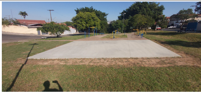
Rua Mário Ferraz x Rua Antonio Salviatti ,Jd. Novo Horizonte - Execução de base de concreto para instalação de playground
