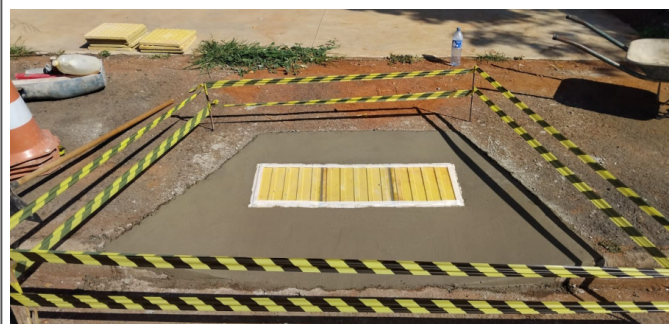
Rua Alberto de Lourdes Padovan - Jd. São Paulo - Rampa de acessibilidade
