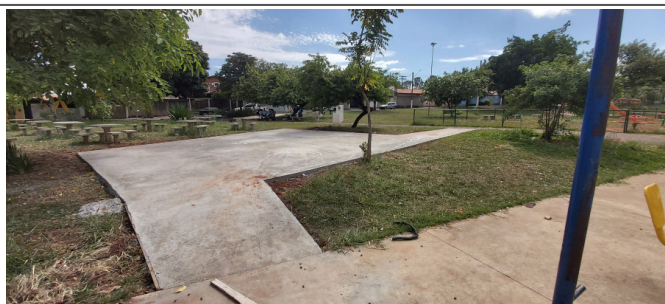
Rua José Eduardo Mecate, Pq. Abilio Pedro - Base de concreto para instalação de playground
