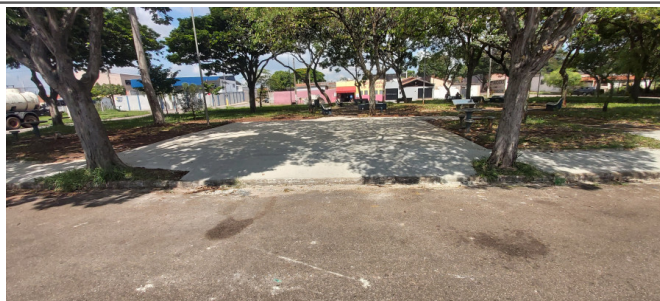
Rua Francisco Denadai x Rua virginia M. Rosada, Jd. Vanessa - Execução de base de concreto para instalação de playground.
