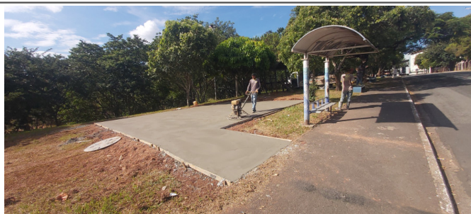
Rua Maestro Biagio Pincelli, Jd. Olga Veroni - Execução de base de concreto para instalação de playground
