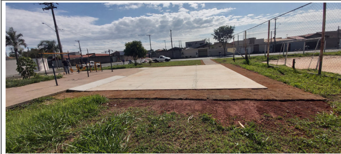
Rua Orivaldo Gaspar x Rua Jandira F. Furlan, Res. Nobre Vile - Execução base de concreto para instalação de playground e plantio de grama
