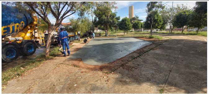
Rua Sebastião B. Camargo x Rowilson M. Carvalho, Pq. Pompeu - Execução de base de concreto para instalação de playground
