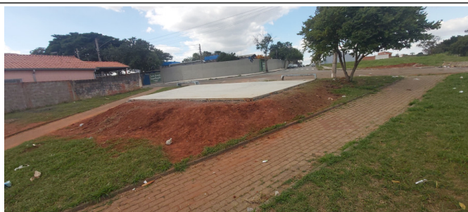
Rua Joaquim Bernardo, Jd. Boa Esperança - Execução de base de concreto para instalação de playground
