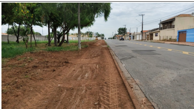
Rua Orivaldo Gaspar x Rua Jandira F. Furlan, Res. Nobre Vile - Execução de calçada
