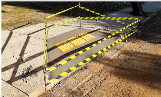
Rua Francisco Denadai x Rua virginaia M. Rosada, Jd. Vanessa - Execução de rampa de acessibilidade
