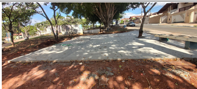
Rua Manoel Rodrigues Ferreira - Pq. Hipolyto - Execução de base de concreto para instalação de playground
