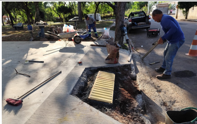
Rua Francisco Denadai x Rua virginaia M. Rosada, Jd. Vanessa - Execução de rampa de acessibilidade
