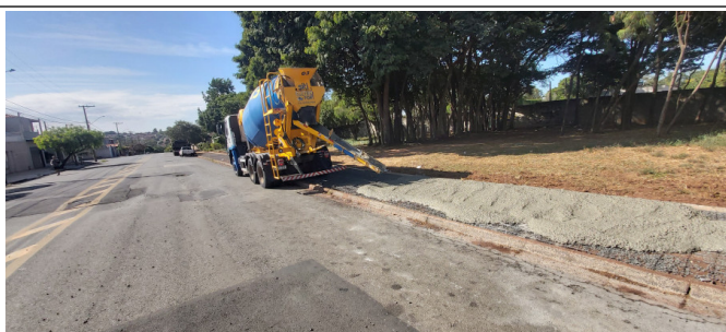
Rua Orivaldo Gaspar x Rua Jandira F. Furlan, Res. Nobre Vile - Execução de calçada
