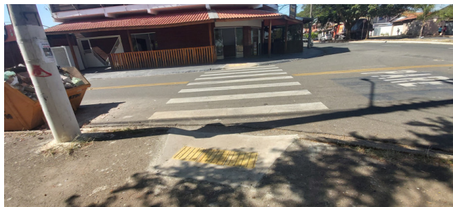
Av. Nelson Aparecido do Nascimento x Rua Luiz Pereira Prado - Jd. Vitorio Lucato - Rampa de acessibilidade
