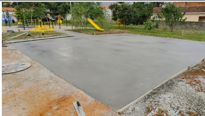
Rua Nicolau Fanelli, Jd. Planalto - Execução de base de concreto para instalação de playground
