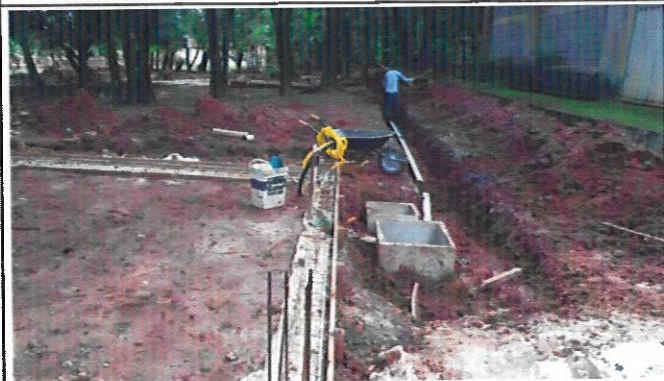
Foram executadas as demolições e limpeza para execução das fundações, estacas e radiers...
