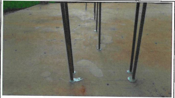
Foram executadas as demolições e limpeza para execução das fundações, estacas e radiers...
