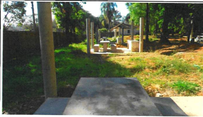
Pilares executados, lixeiras instaladas, será iniciado o revestimento interno das churr...
