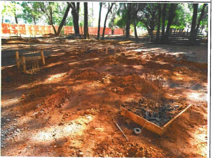
Foram executadas as demolições e limpeza para execução das fundações, estacas e radiers...
