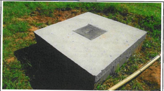
Pilares executados, lixeiras instaladas, será iniciado o revestimento interno das churr...
