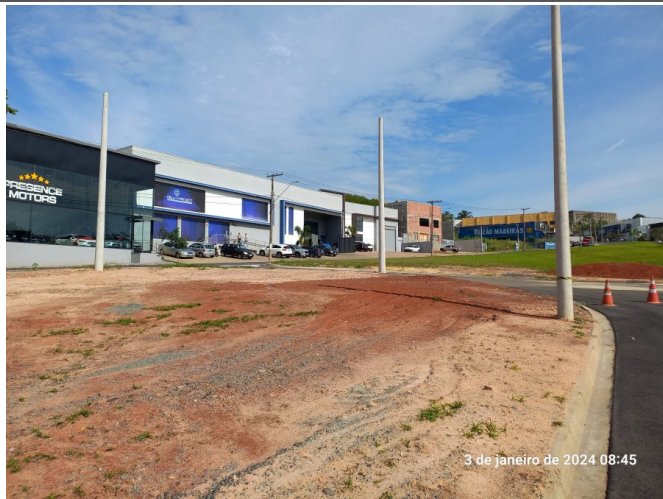
Instalação de postes de iluminação.
