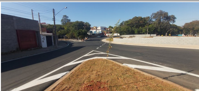
Pavimentação concluída com sinalização de trânsito.
