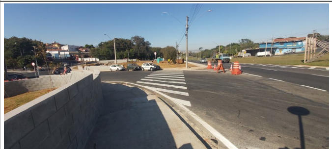
Pavimentação concluída com sinalização de trânsito.
