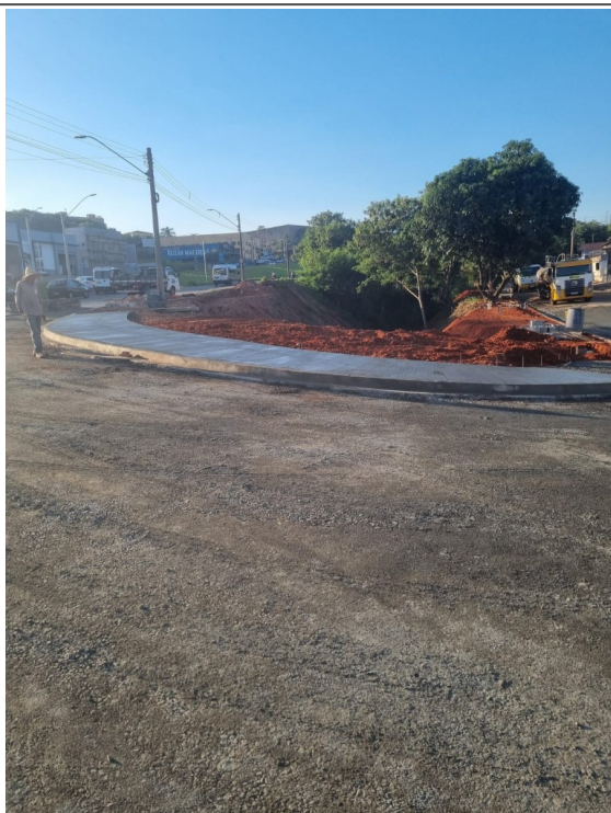
Execução de camada de concreto asfáltico (Binder).
