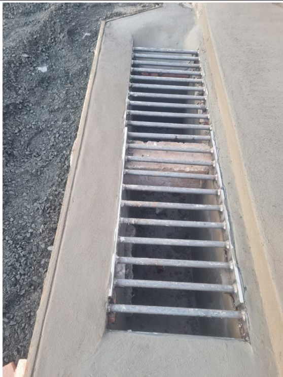
Execução de boca de leão dupla.
