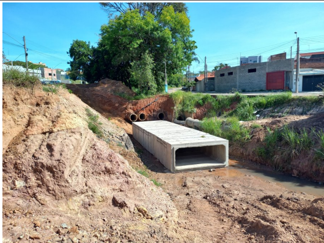
Instalação de um dos trechos da aduela.
