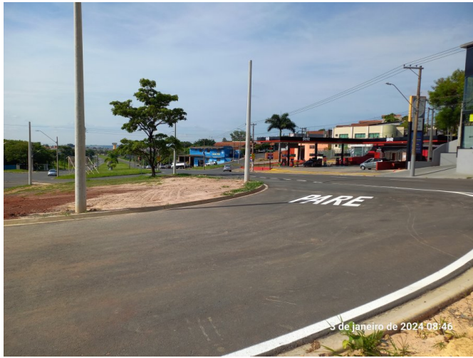
Pintura do asfalto no retorno.
