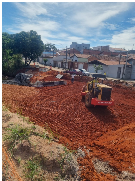
Aterro e compactação do solo sobre a canalização em aduelas.
