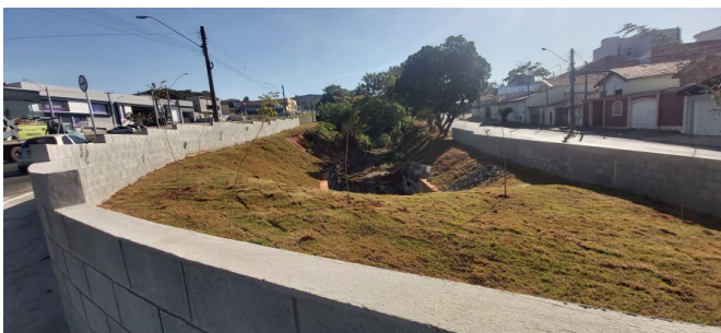
Mureta no entorno do muro ala e plantio de grama em talude
