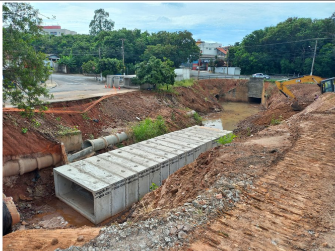
Instalação de um dos trechos da aduela.
