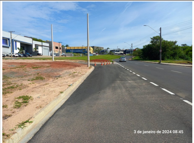
Pintura do asfalto no retorno.
