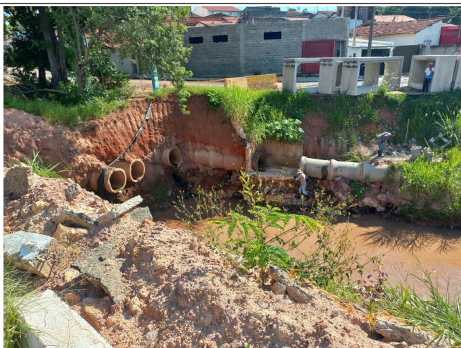
Limpeza da área para continuidade dos trabalhos.
