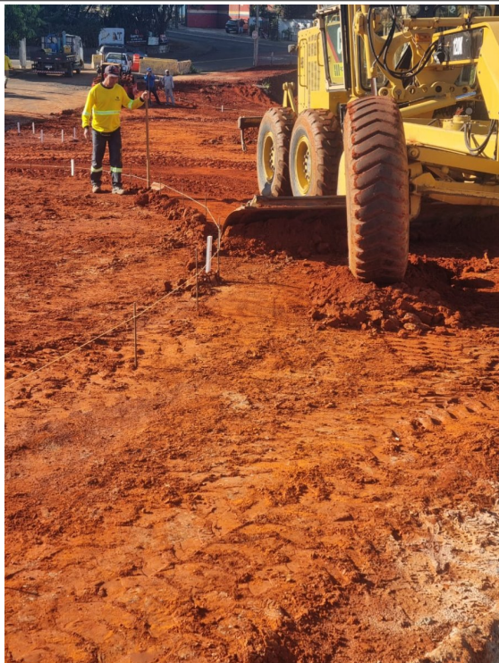
Nivelamento da sub-base do pavimento.
