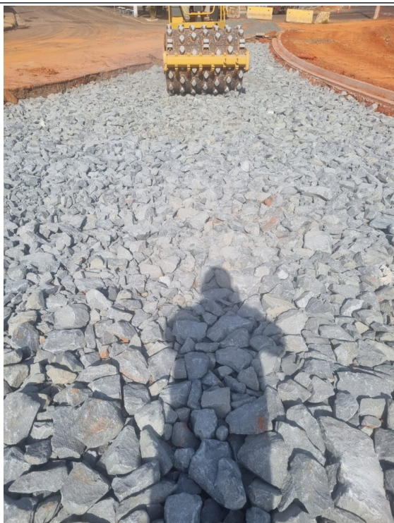
Compactação da camada de rachão do pavimento.
