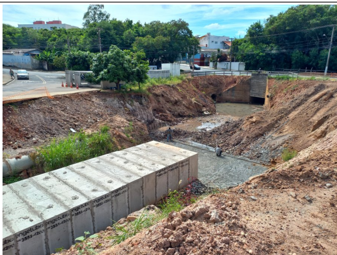
Execução do muro ala à jusante.
