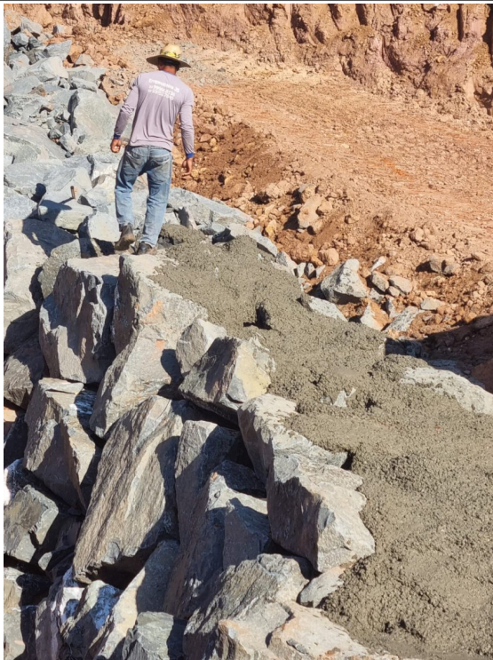
Contensão de talude com pedra argamassada as margens do córrego
