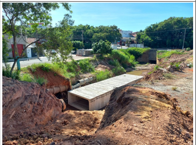
Instalação de um dos trechos da aduela.
