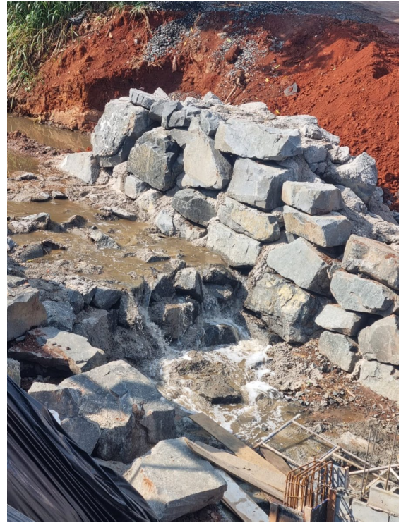
Contensão de talude com pedra argamassada as margens do córrego
