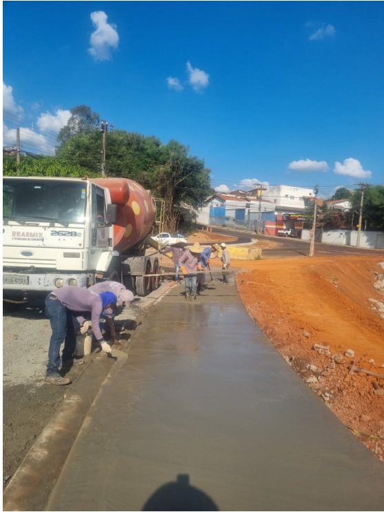
Execução de calçada.
