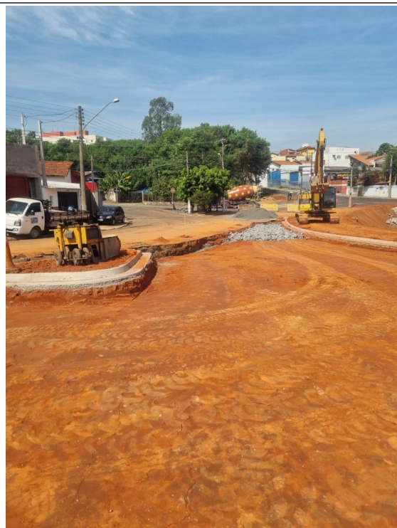
Execução de guia e sarjeta.
