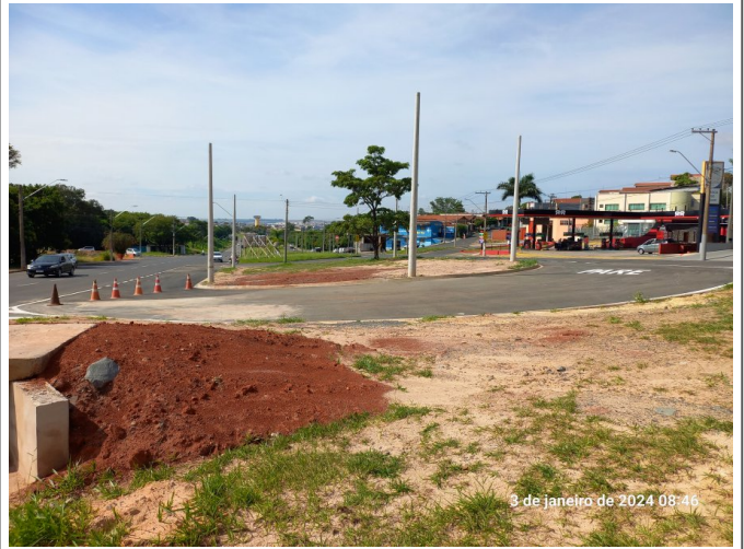
Pintura do asfalto no retorno.
