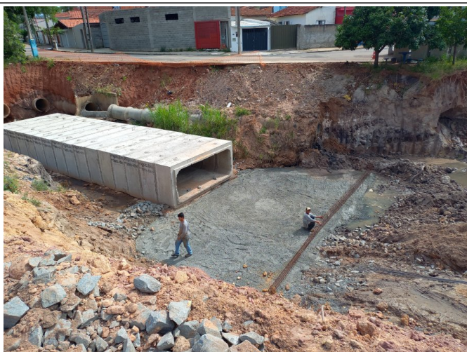
Execução do muro ala à jusante.
