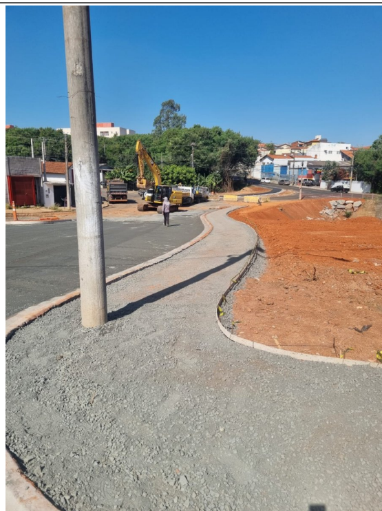
Execução de calçada.
