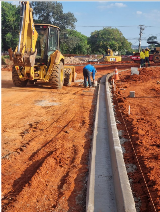
Execução de guia e sarjeta
