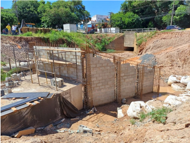
Execução do muro ala á jusante.
