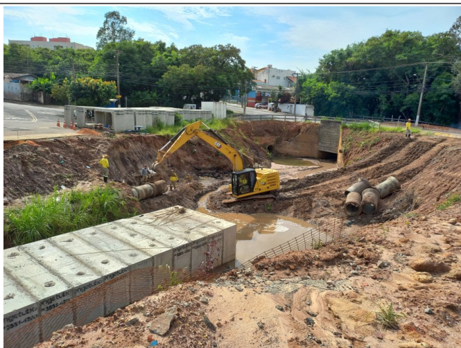
Mudança do curso do córrego para execução do muro ala.
