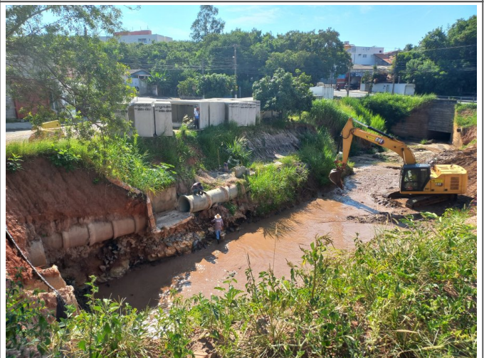
Limpeza da área para continuidade dos trabalhos.
