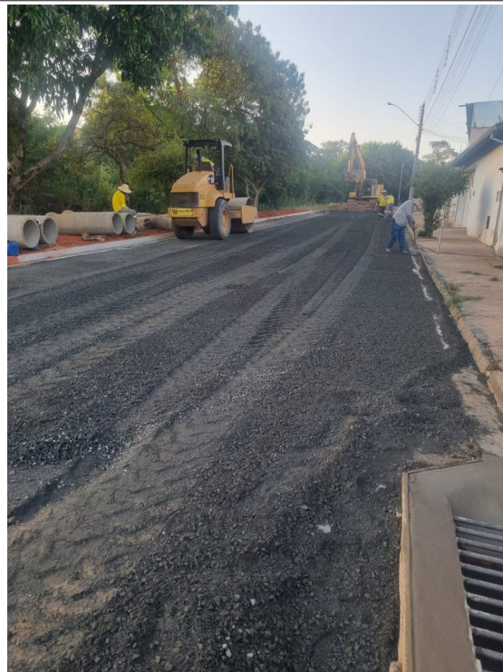
Execução de camada BGS (Brita Graduada Simples).
