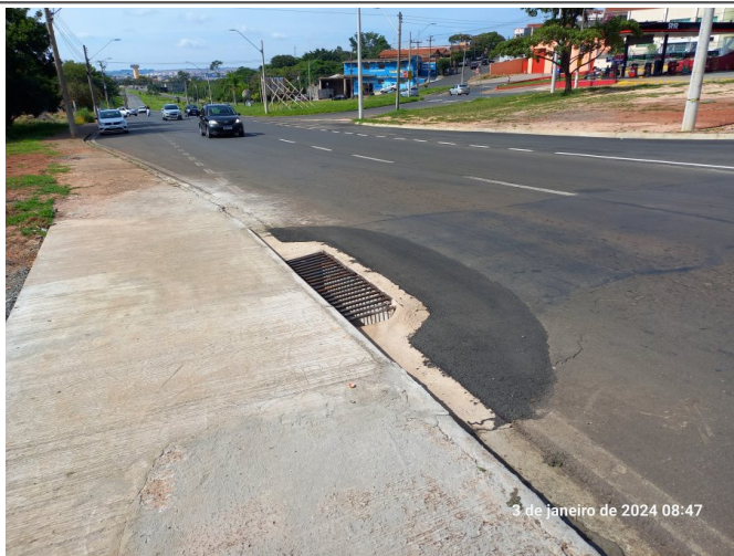
Execução de boca de leão.
