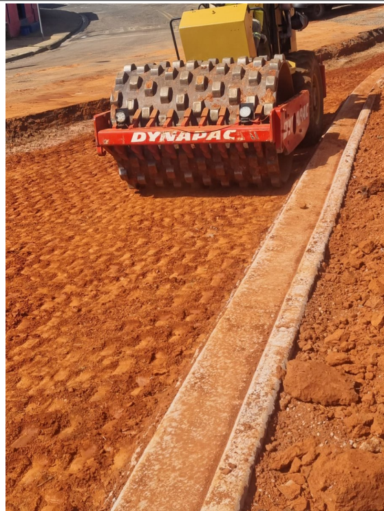
Compactação da sub-base do pavimento.
