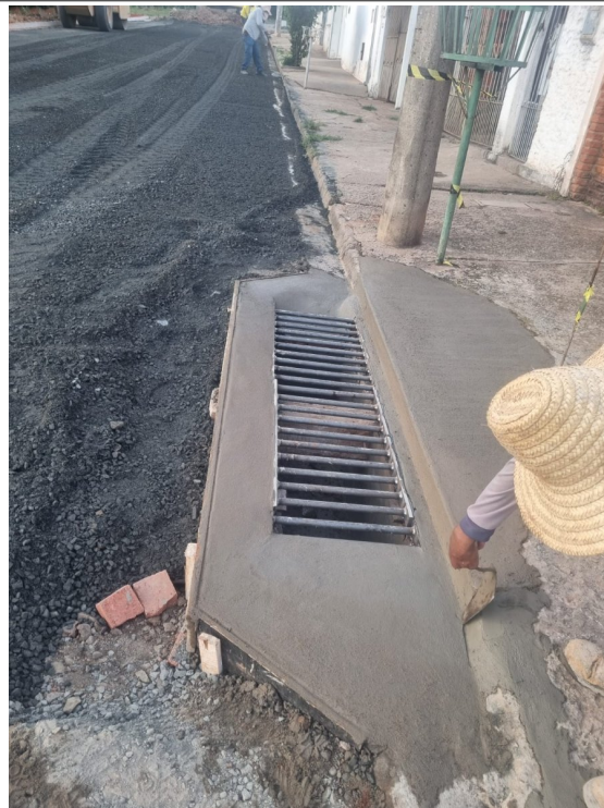
Execução de boca de leão dupla.
