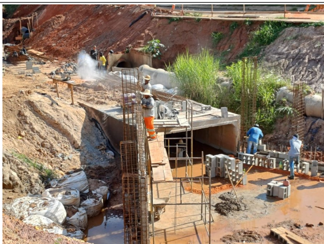
Execução do muro ala á jusante.
