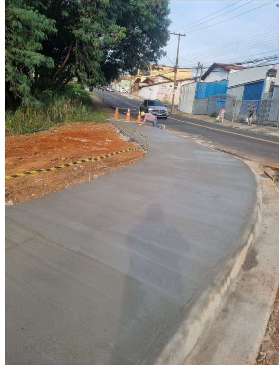
Execução de calçada.
