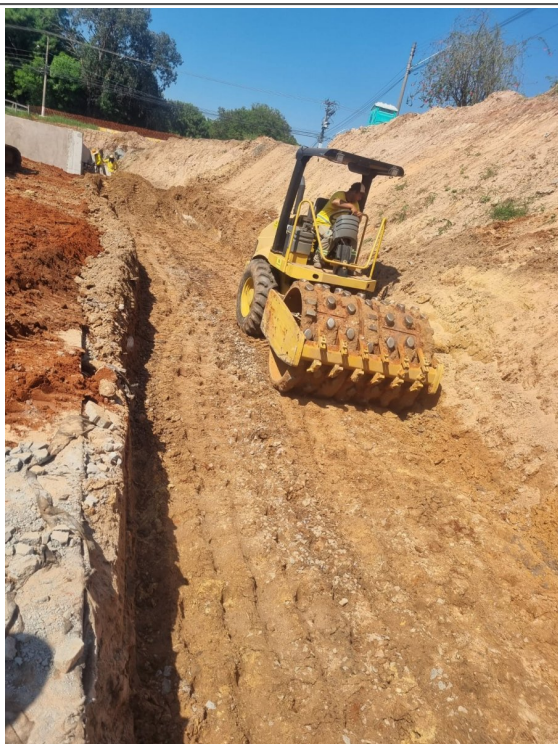
Aterro e compactação do solo.
