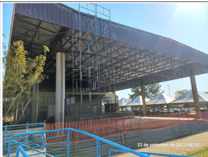
Montagem de andaime para execução de serviços em altura.
