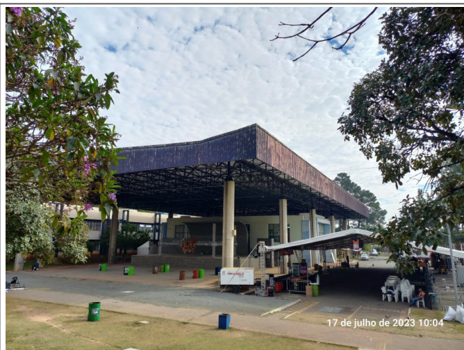
Vista geral da cobertura a ser recuperada.
