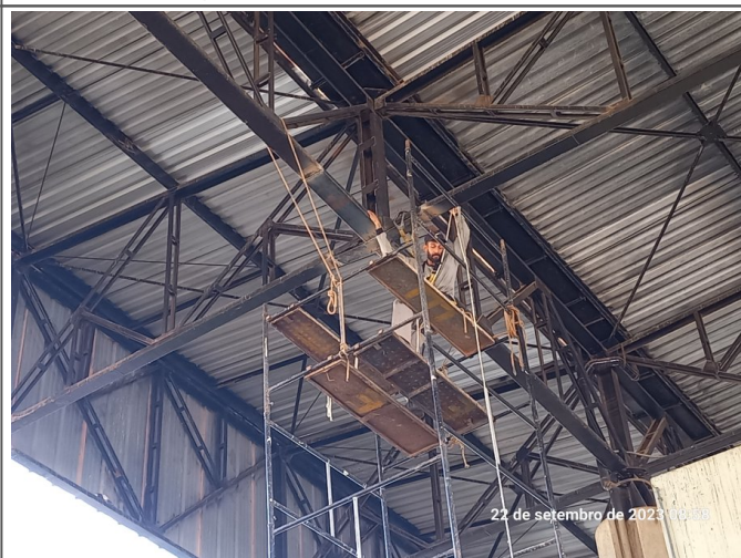
Recuperação de trecho da estrutura metálica.
