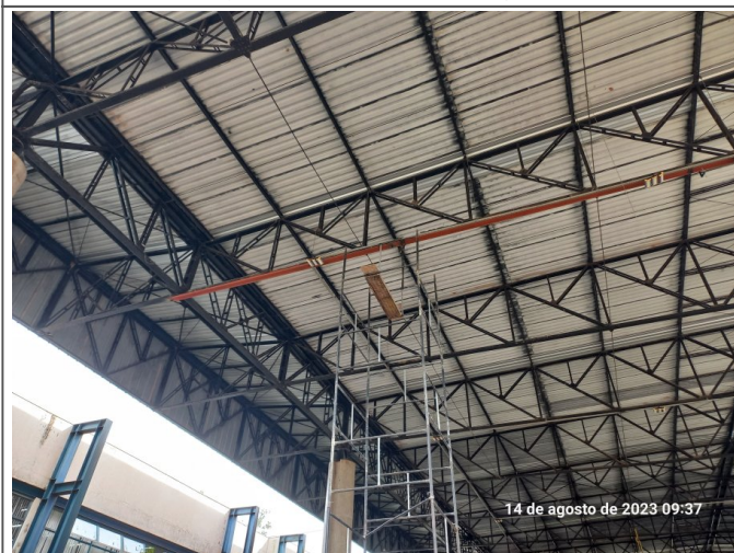
Perfil soldado em substituição ao que estava danificado.
