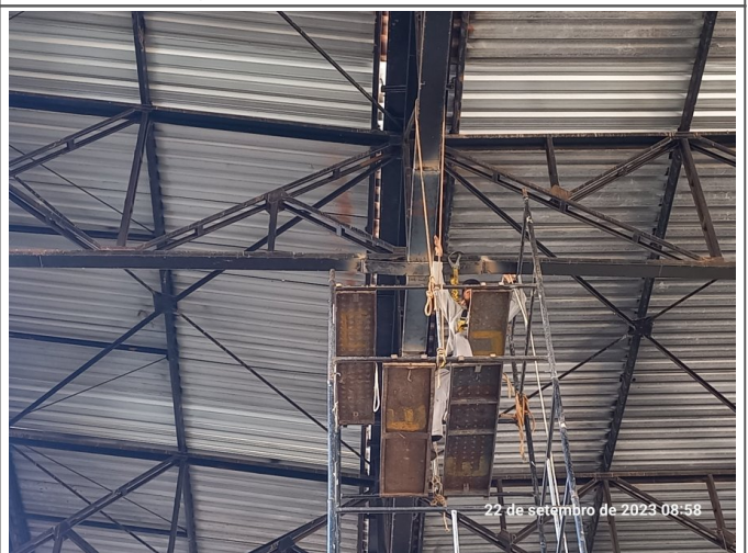
Recuperação de trecho da estrutura metálica.
