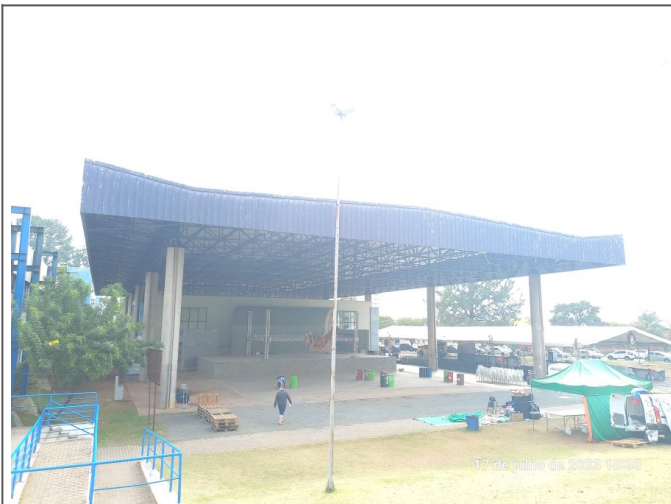
Vista geral da cobertura a ser recuperada.
