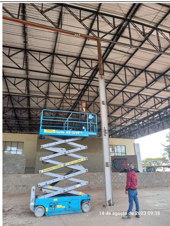
Perfil soldado em substituição ao que estava danificado.
