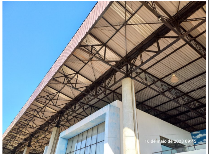
Aspecto da estrutura metálica que cobre a Biblioteca Pedagógica e o Palco no Parque Cidade.
