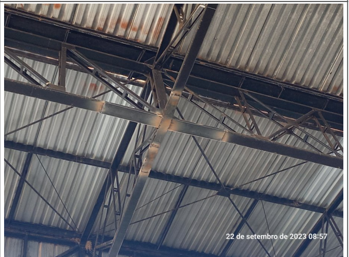
Recuperação de trecho da estrutura metálica.
