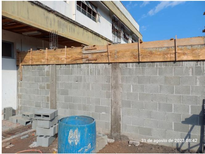
Execução do muro aos fundos. Concretagem da viga.
