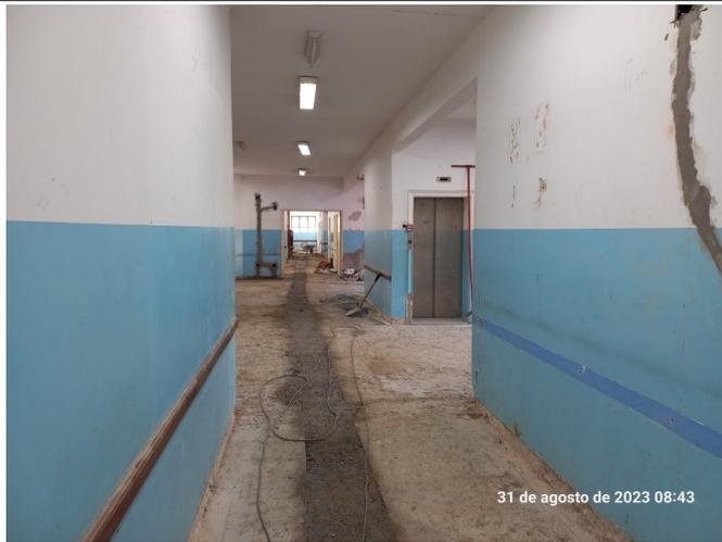
Compactação e concretagem de eletroduto no pavimento térreo.
