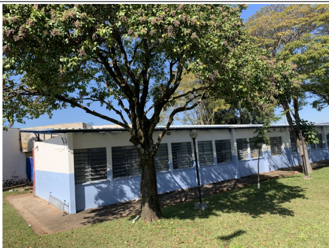
Cobertura de telha termo acústica
