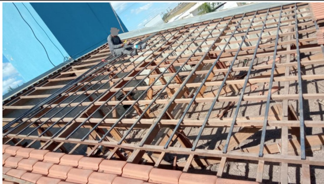
Recolocação de ripas
