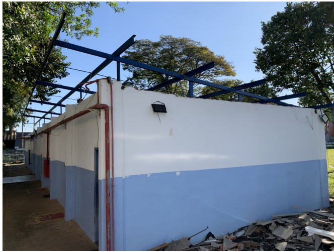
Execução de estrutura metálica
