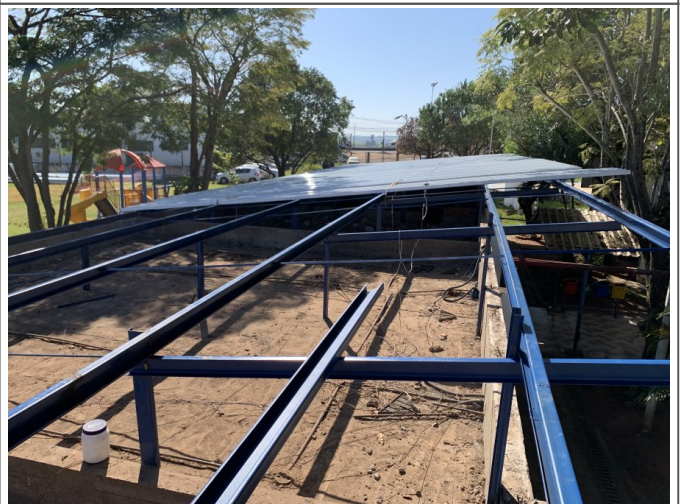
Estrutura metálica e cobertura
