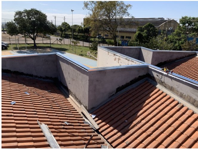
Retirada de cabos de SPDA e rufos
