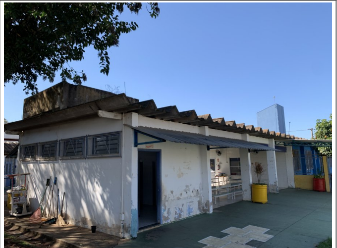
Remoção do kalhetão
