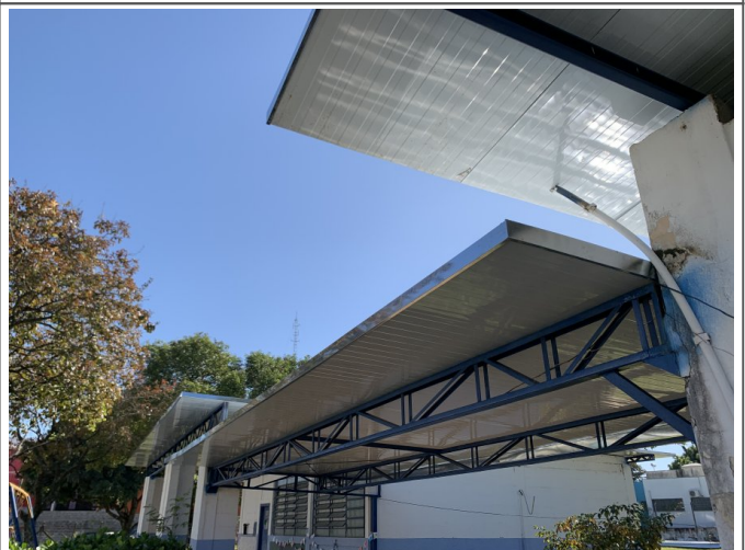
Cobertura de telha termo acústica
