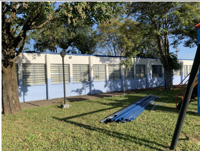
Remoção de kalhetão
