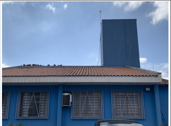
Recolocação das telhas cerâmicas
