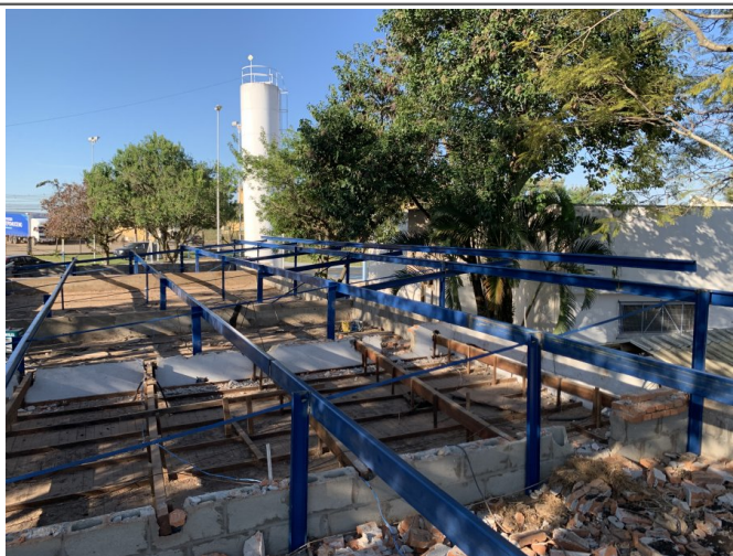
Execução de estrutura metálica
