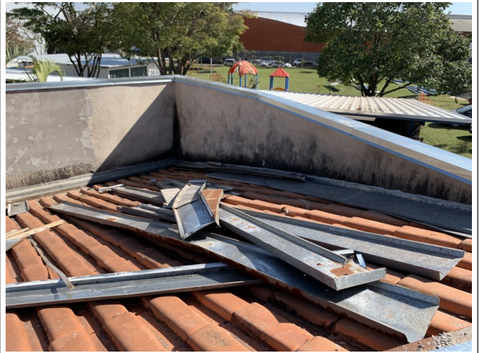
Retirada de cabos de SPDA e rufos
