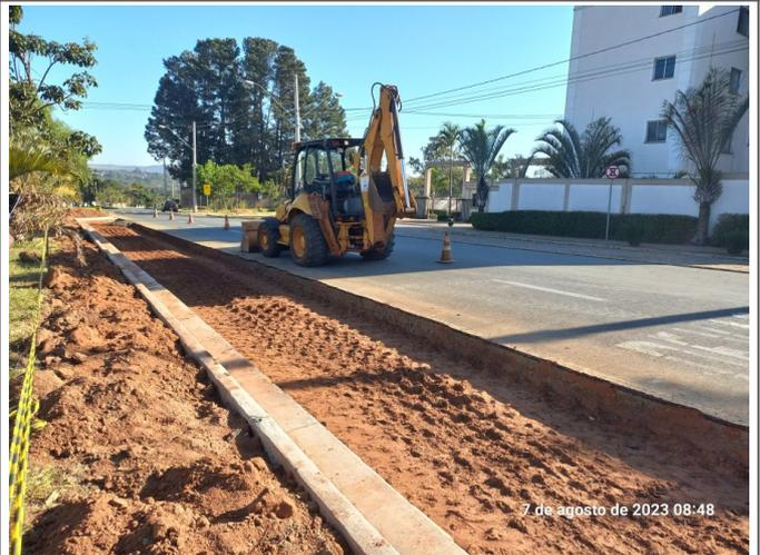
Solo-brita já lançado para base de pavimento.
