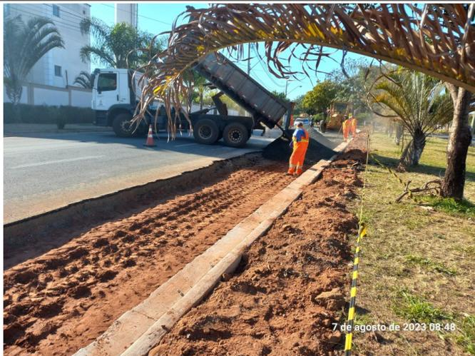
Solo-brita já lançado para base de pavimento e lançamento de brita graduada.
