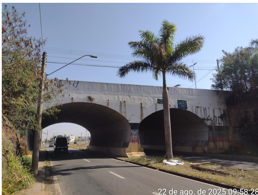
Figura 1: Vista anel viário
