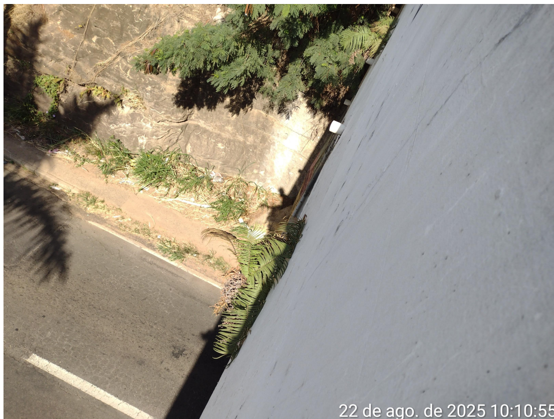
Figura 3: Barbacãs entupidos por vegetação, vista superior
