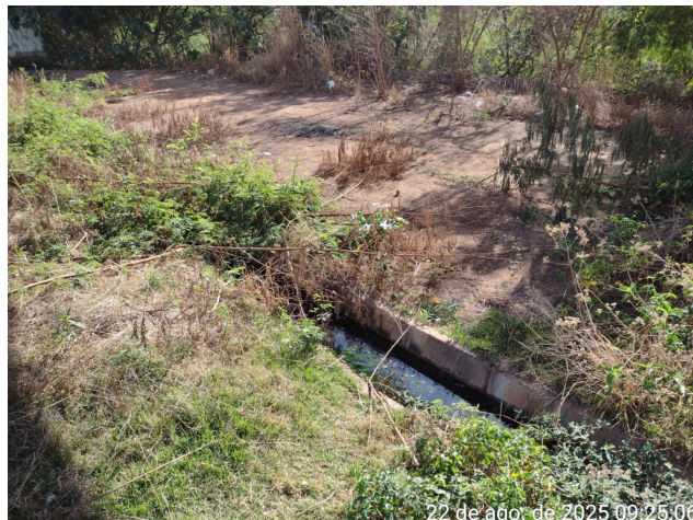
Figura 12 dispositivo de drenagem entupido e avariado pela vegetação
