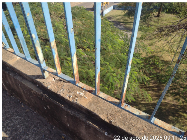
Figura 5 Gradis danificados pelas intempéries
