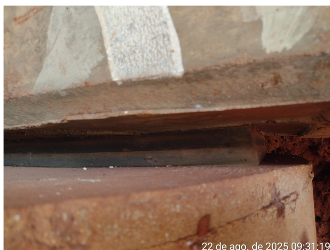
Figura 18 - Aparelhos de apoio em boas condições.
