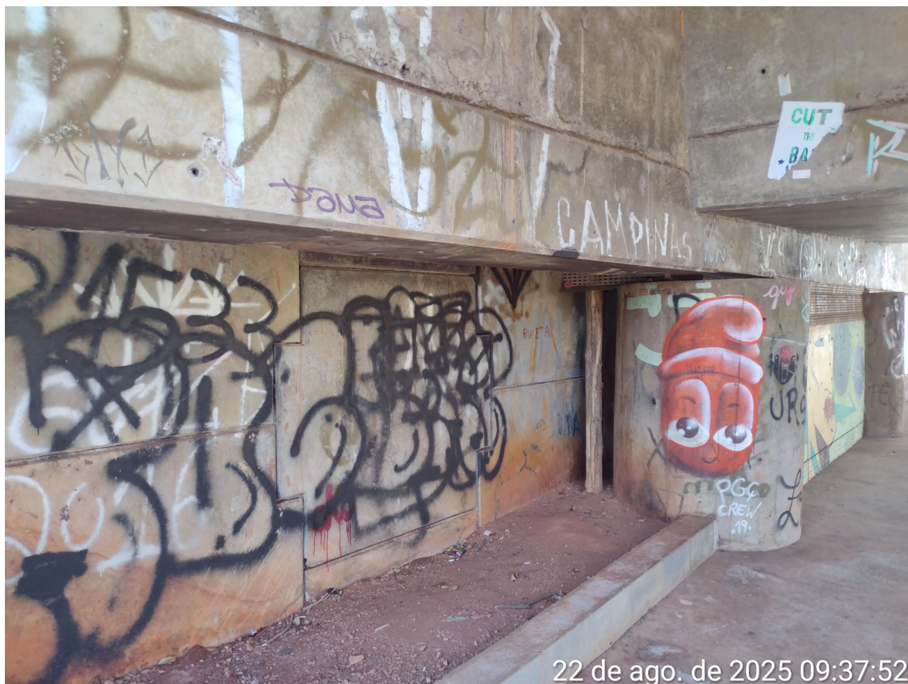
Figura 20 Cabeceira oposta com contenção em terra armada.
