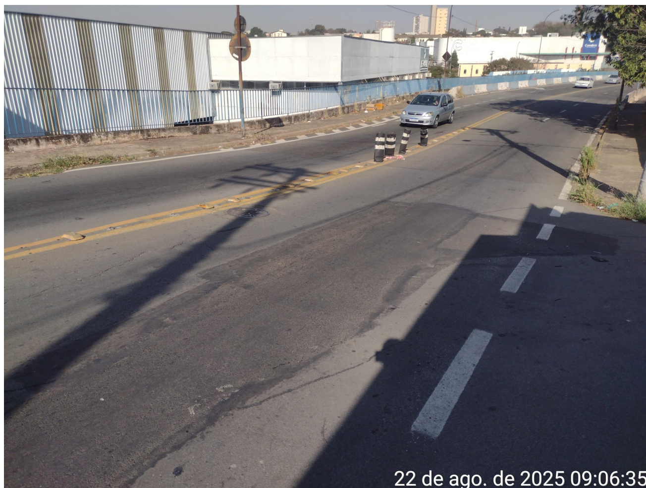
Figura 1 Sinais de abertura de vala para manutenção das redes.
