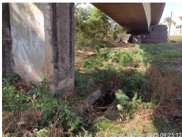
Figura 12 dispositivo de drenagem entupido e avariado pela vegetação
