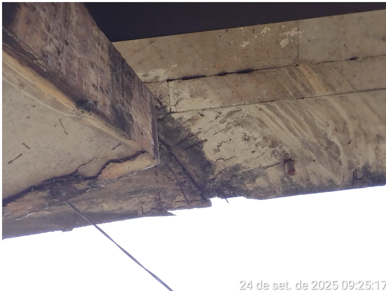
Figura 23 - Exposição da armadura
