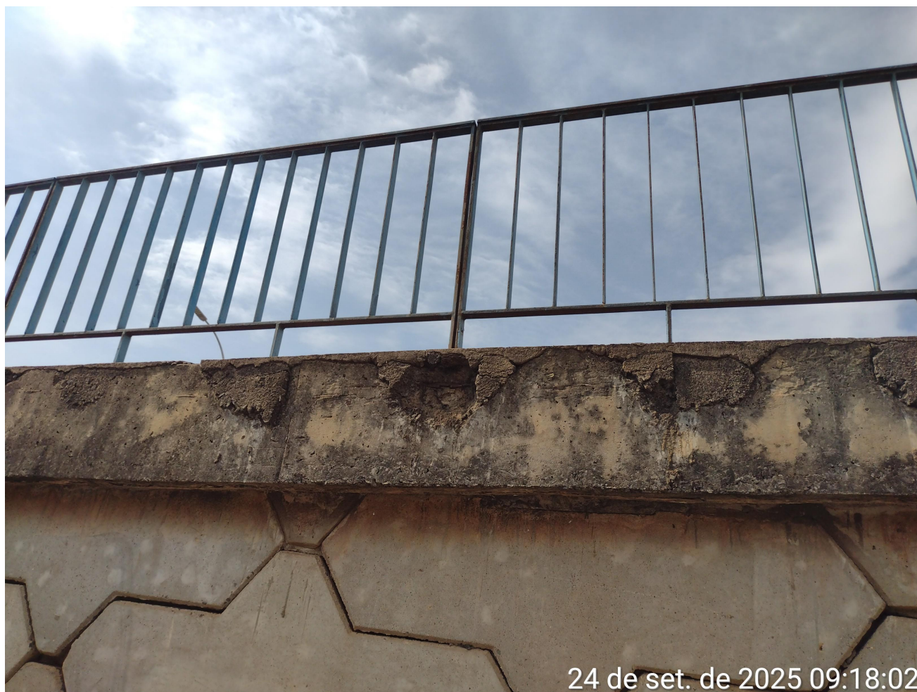
Figura 13 - Exposição de armaduras
