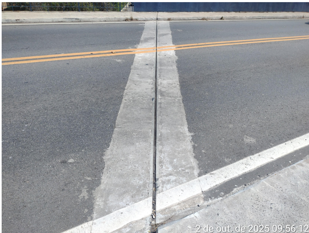
Figura 2 - Juntas de dilatação em boas condições
