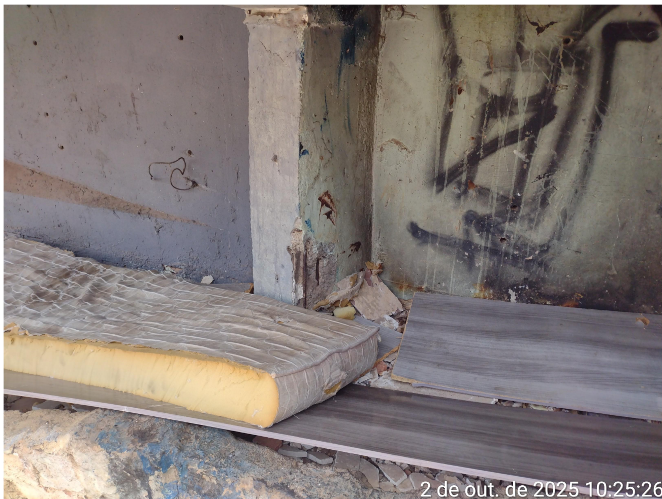
Figura 24 - Armadura exposta na estrutura de contenção
