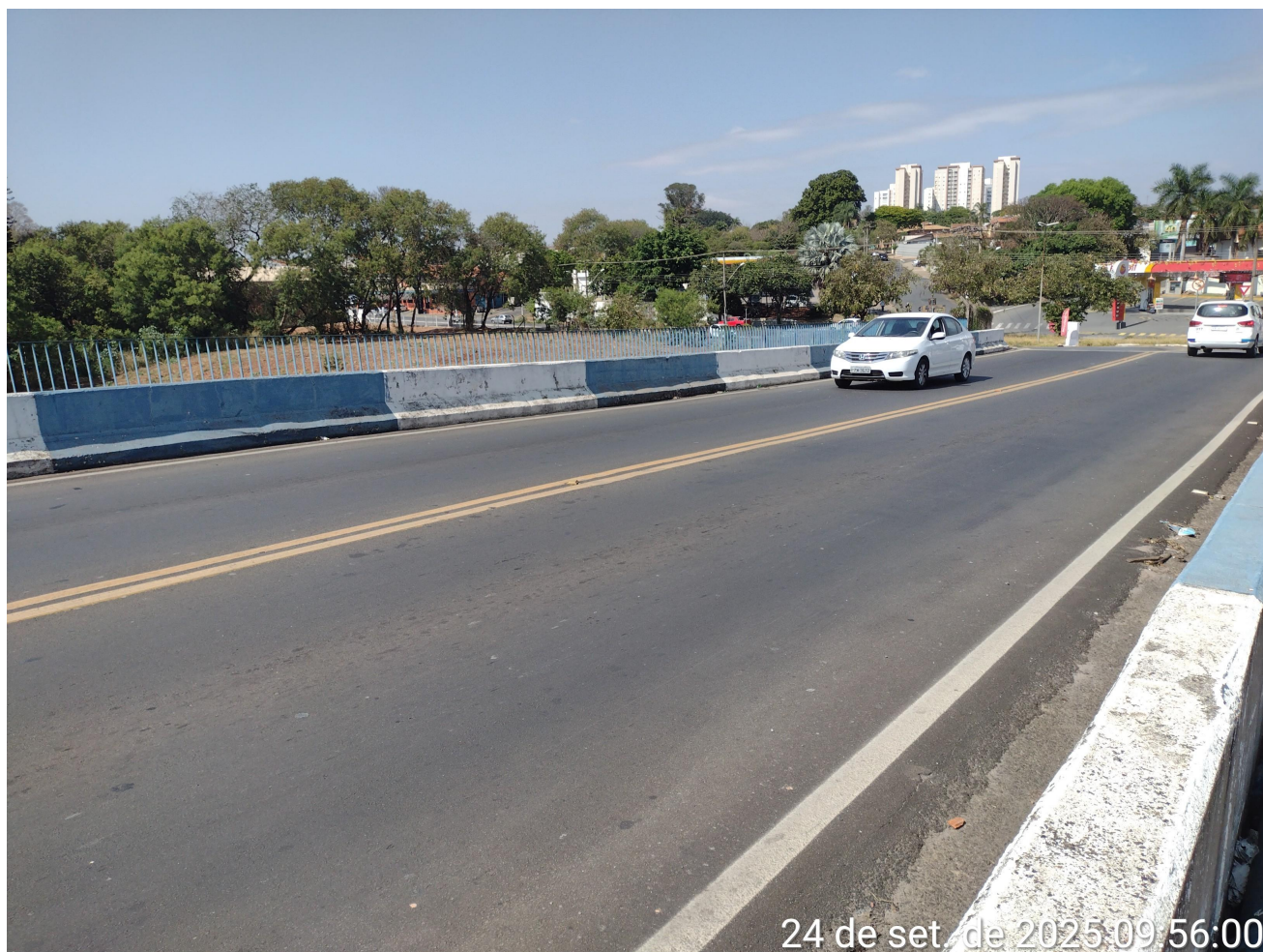
Figura 3 - Pavimento em boas condições
