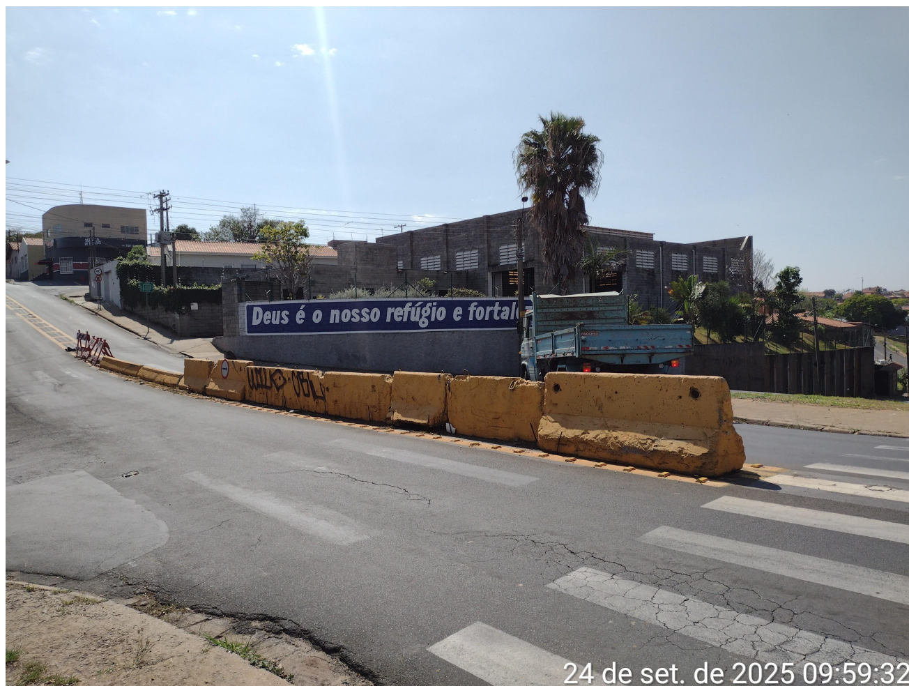
Figura 7 - Barreiras de concreto usada como solução temporária para trânsito
