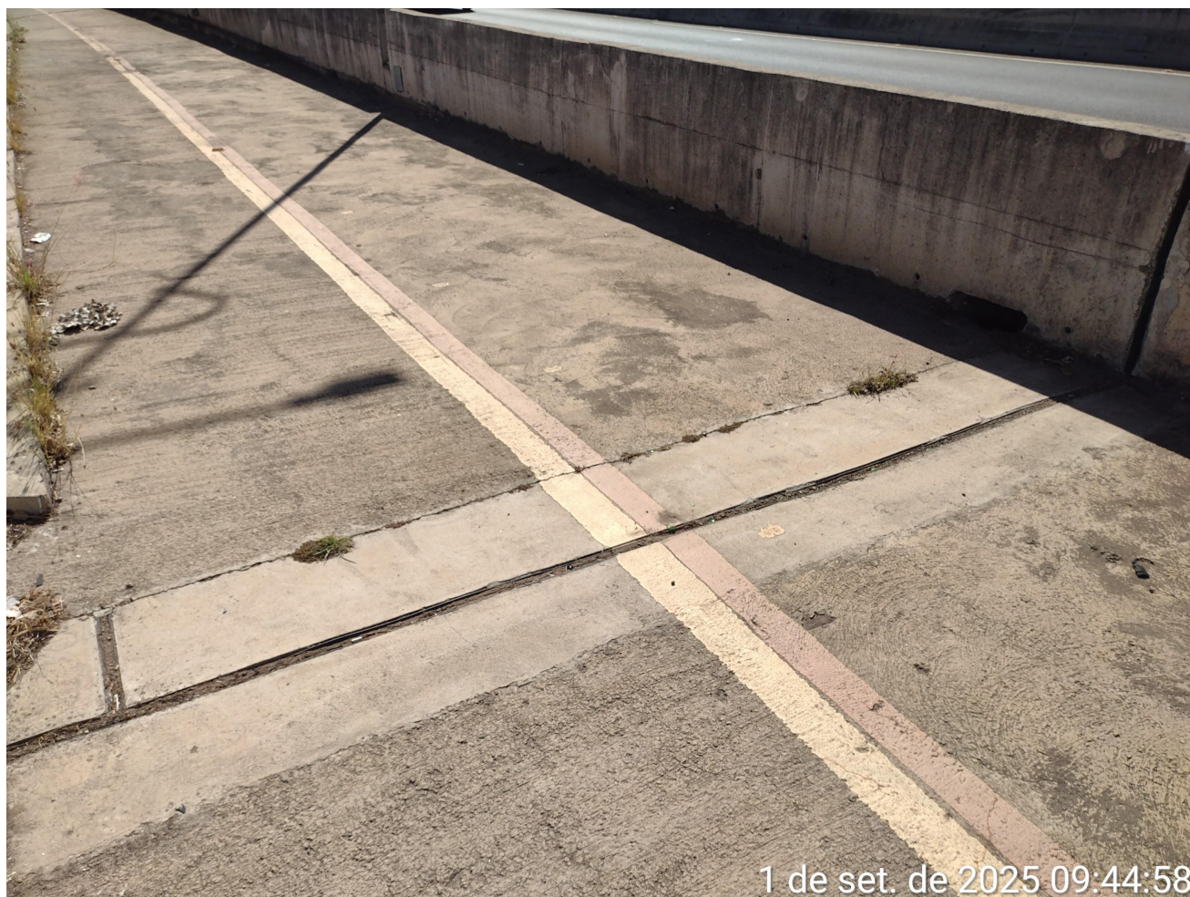
Figura 4 juntas de dilatações, sem patologias
