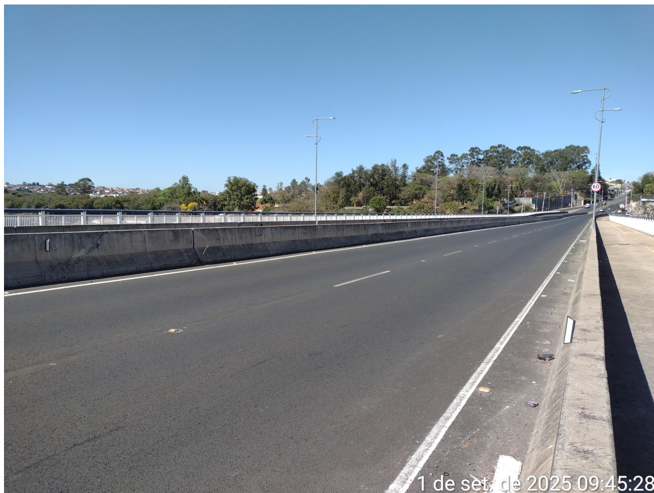
Figura 1 - Estado de conservação do pavimento, sem patologias
