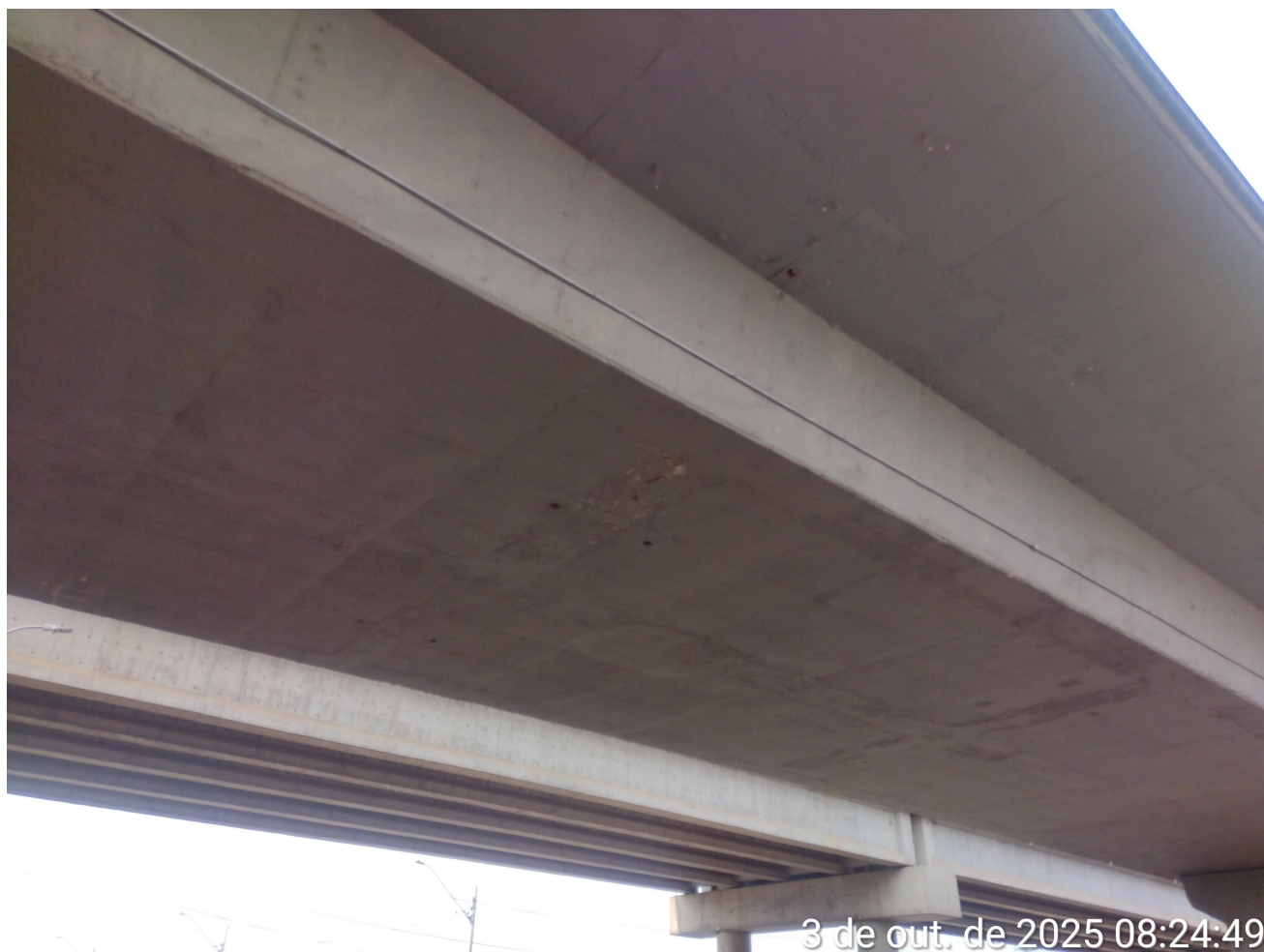
Figura 15 - Caixaão perdido em boas condições
