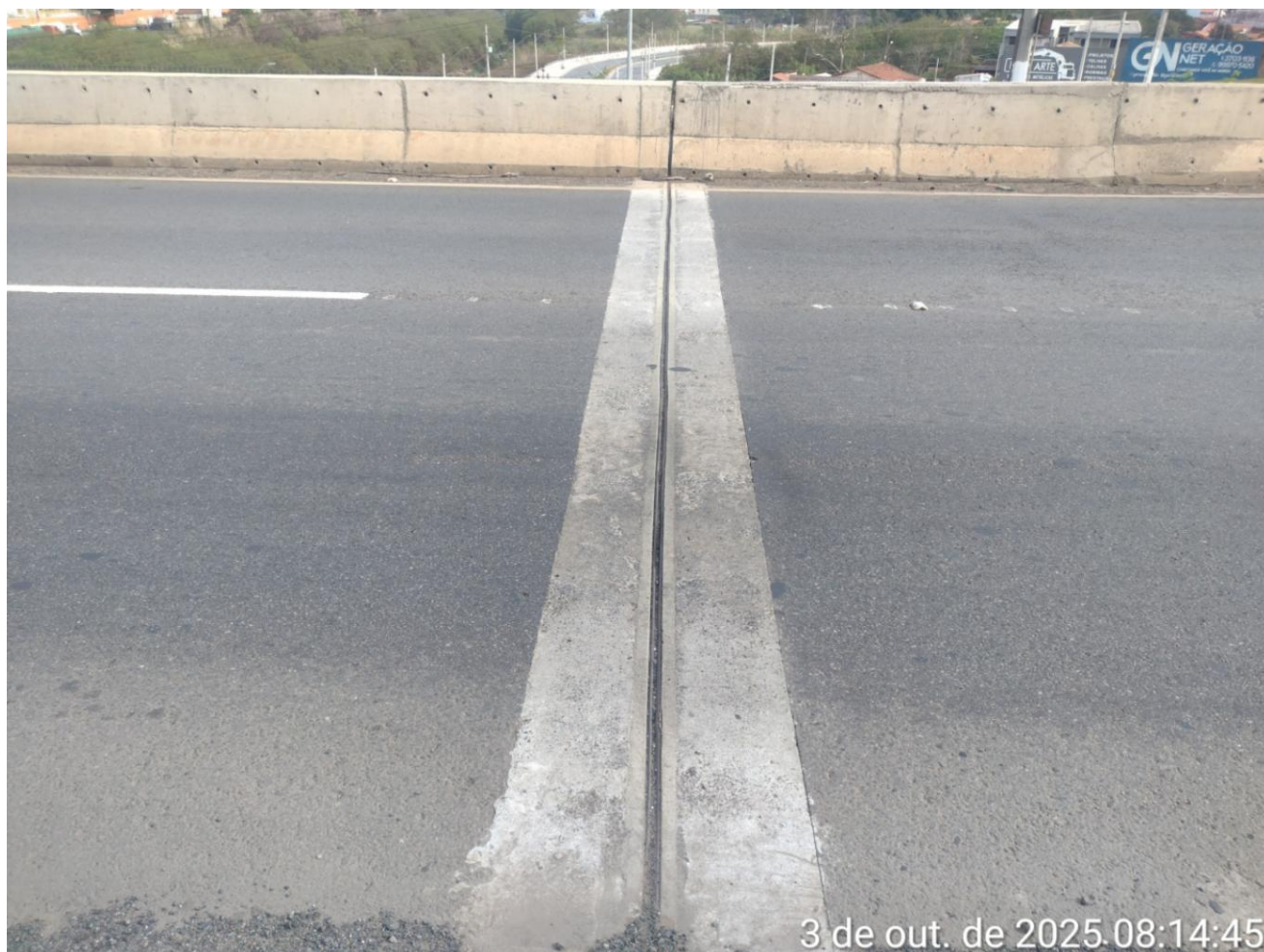
Figura 2 - As juntas de dilatação da ampliação apresentam boas condições
