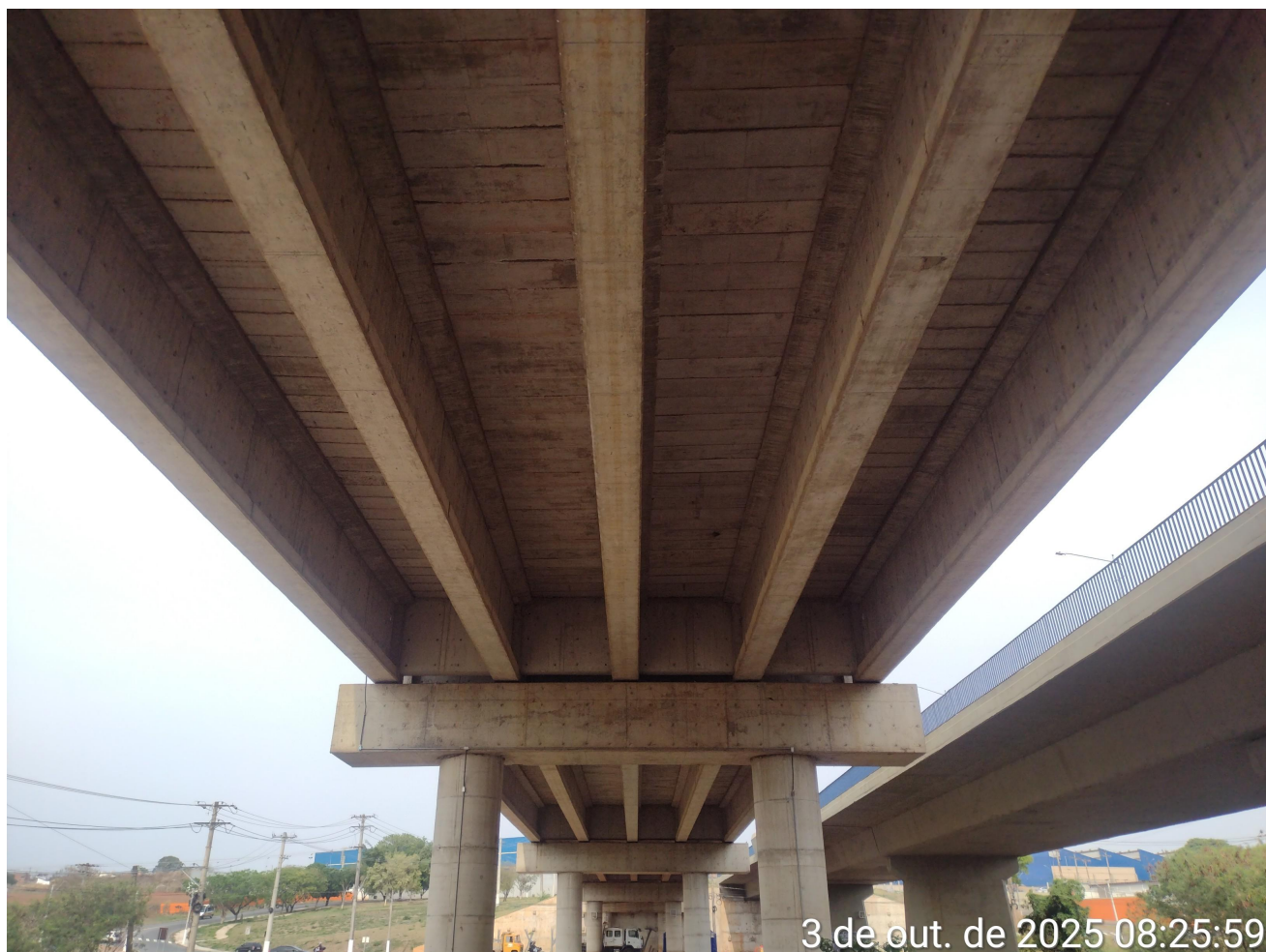
Figura 16 - Superestrutura e aparelhos de apoio em boas condições
