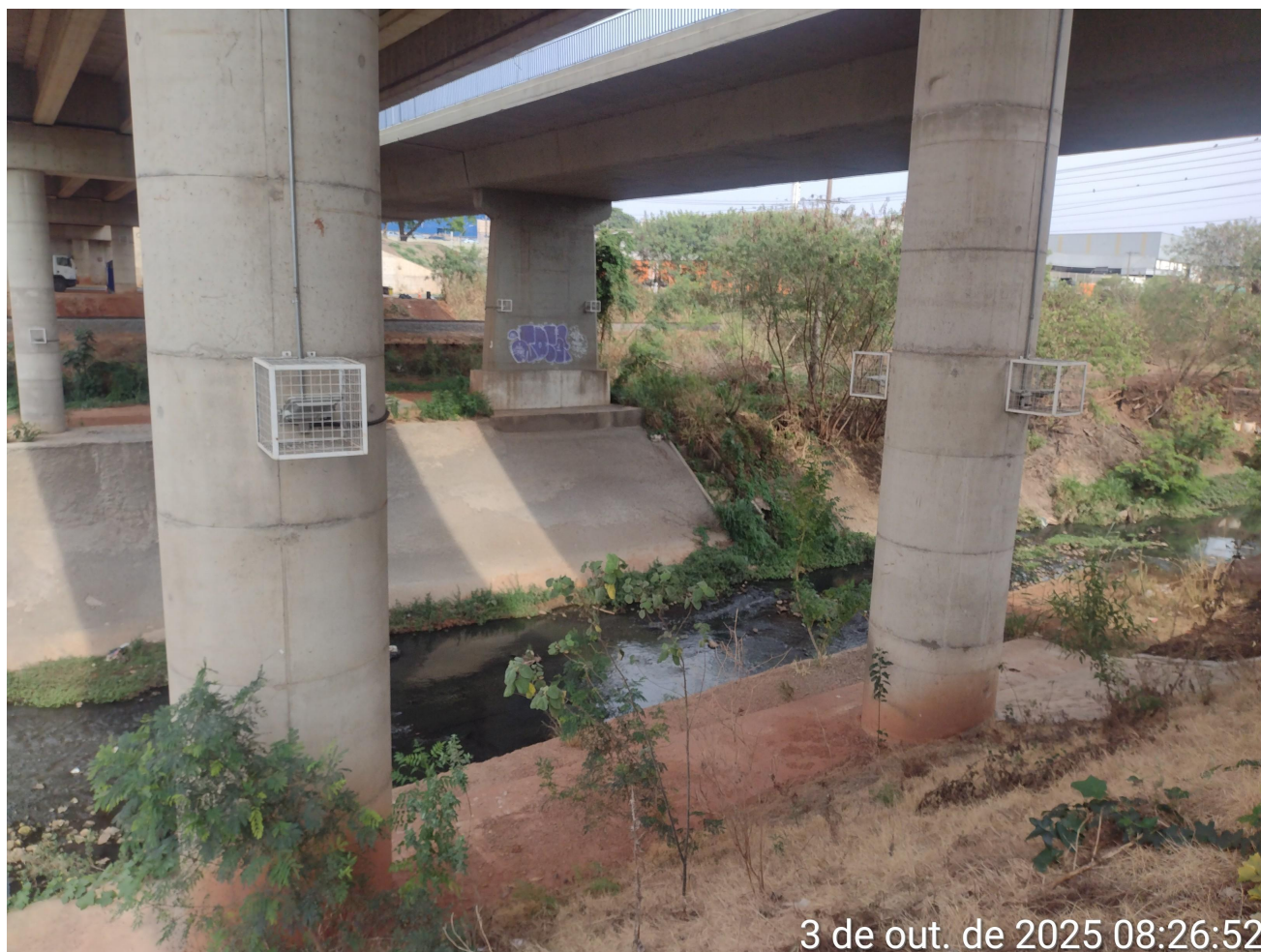
Figura 18 - Pilares em boas condições
