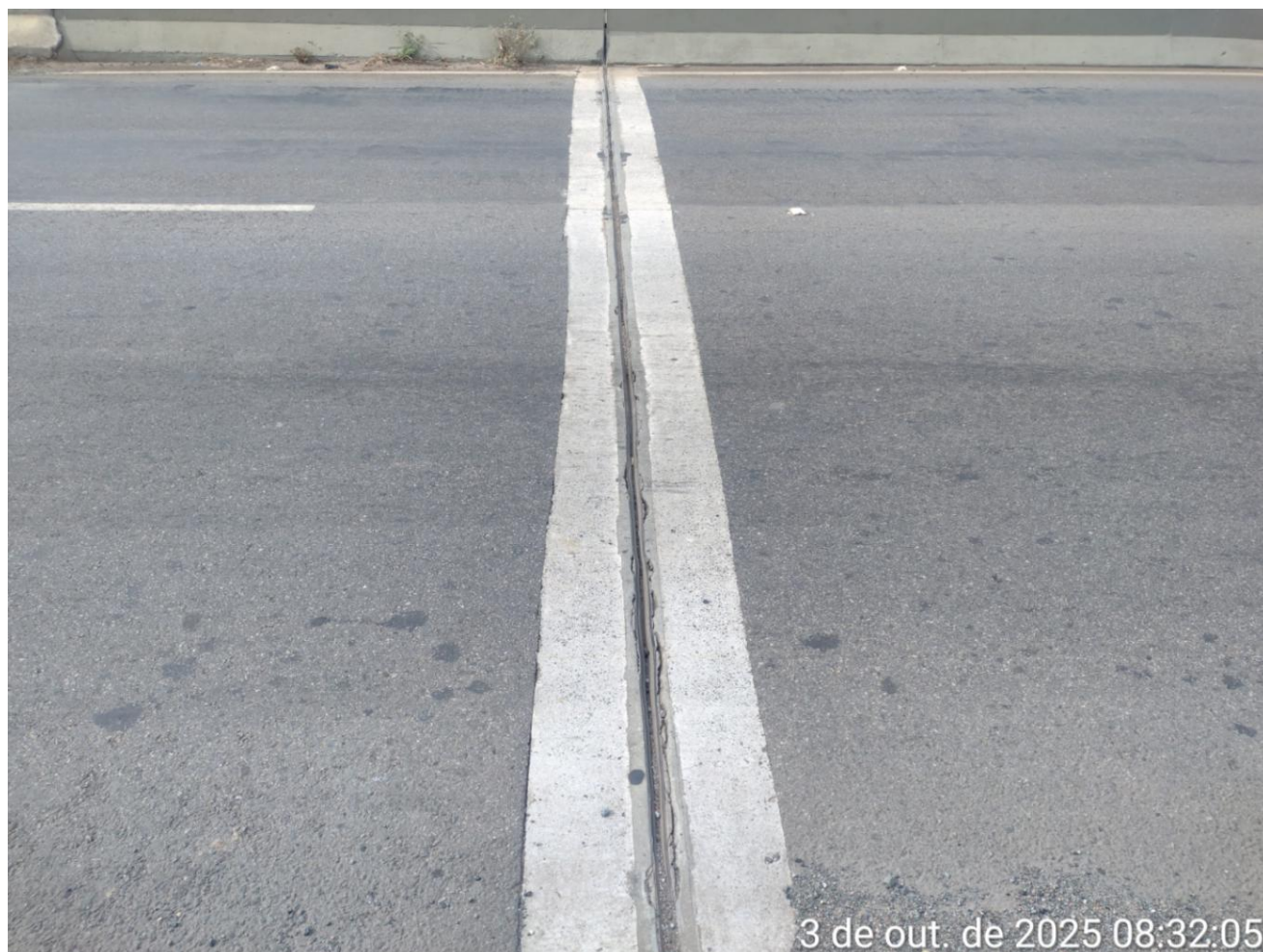
Figura 3 - Algumas juntas do antigo apresentam avarias que necessitam de visitas periódicas para avaliações
