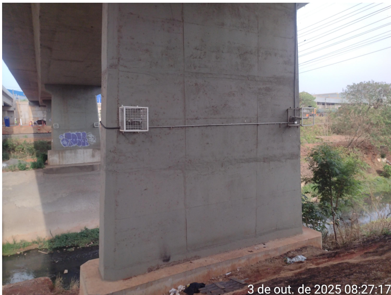
Figura 17 - Pilares em boas condições
