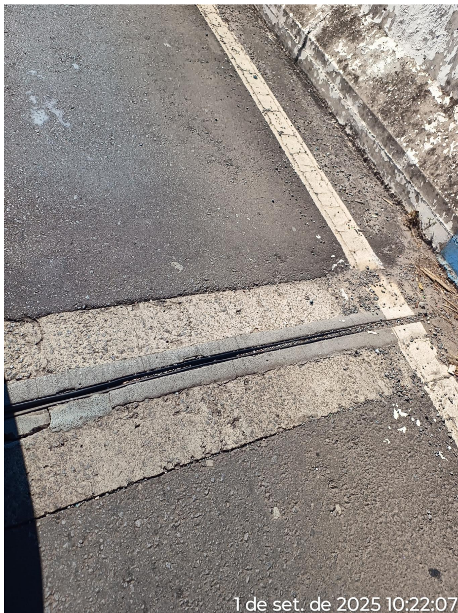
Figura 8 - Juntas de dilatação em bom estado
