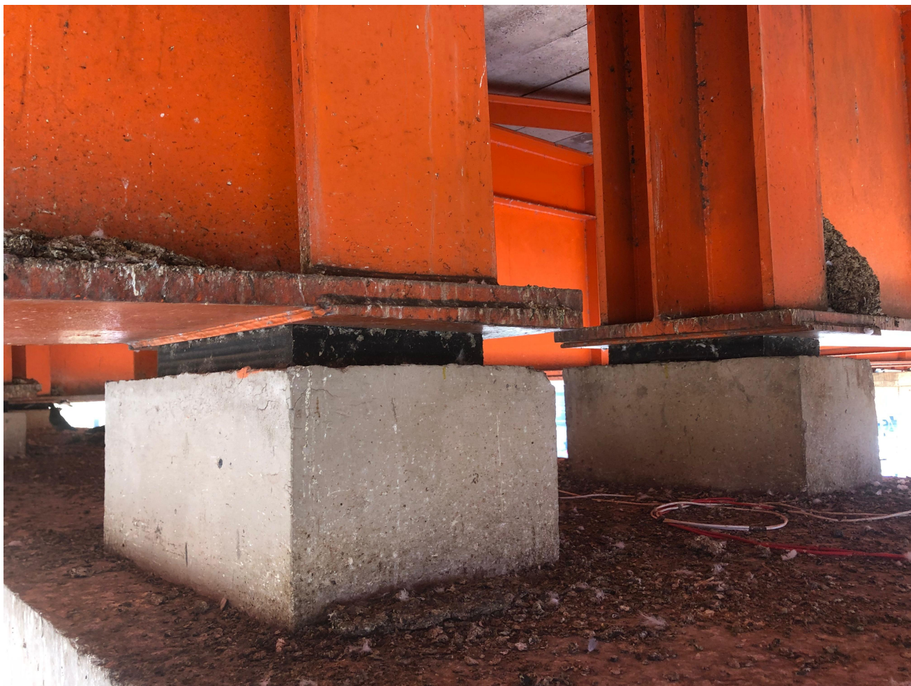
Figura 15 - Aparelhos de apoio neoprene
