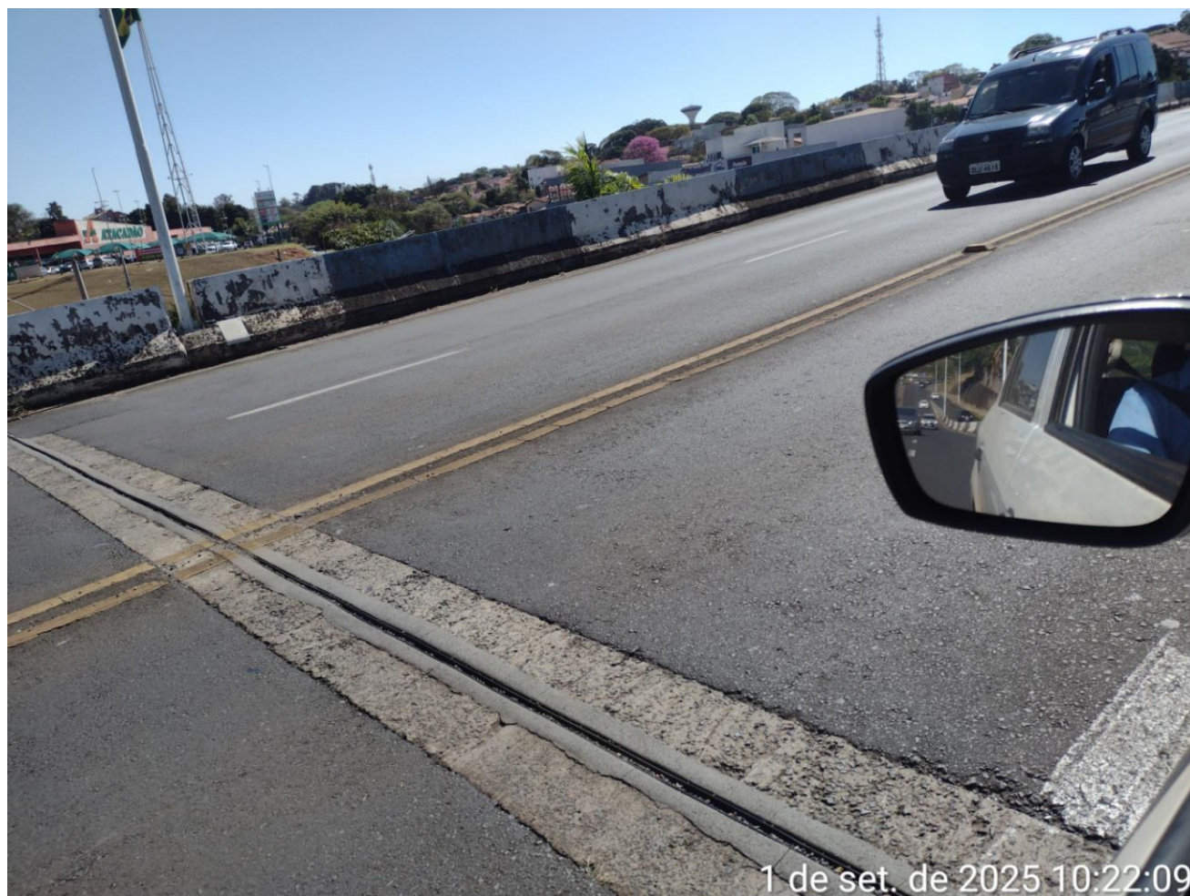
Figura 9 - Junta de dilatação
