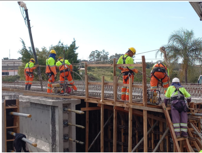
Concretagem de viga protendida
