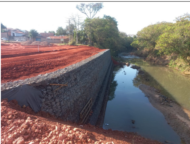
Execução de muro Gabião
