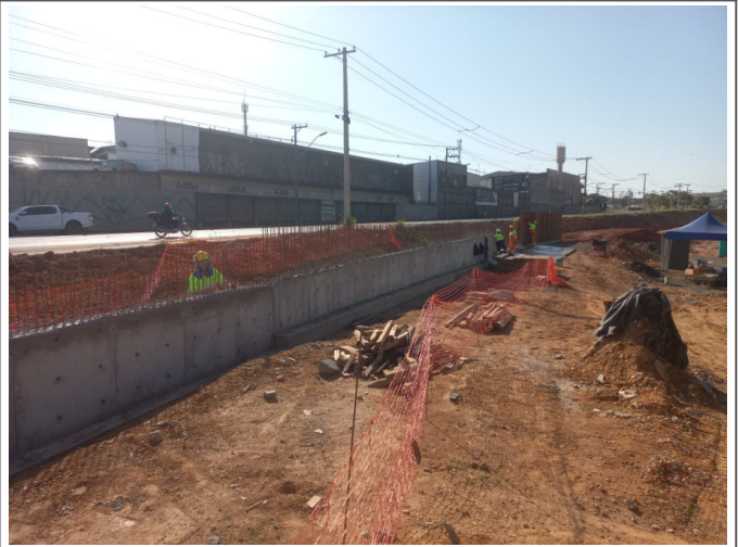
Muro em concreto armado
