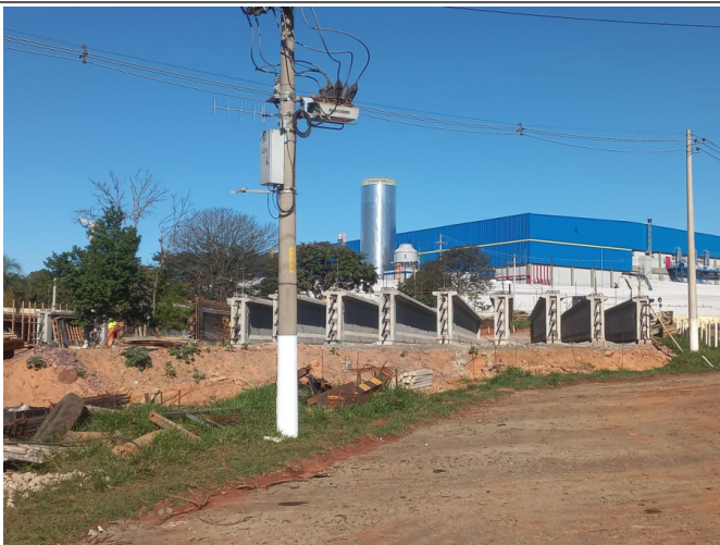
Pátio de Vigas protendidas
