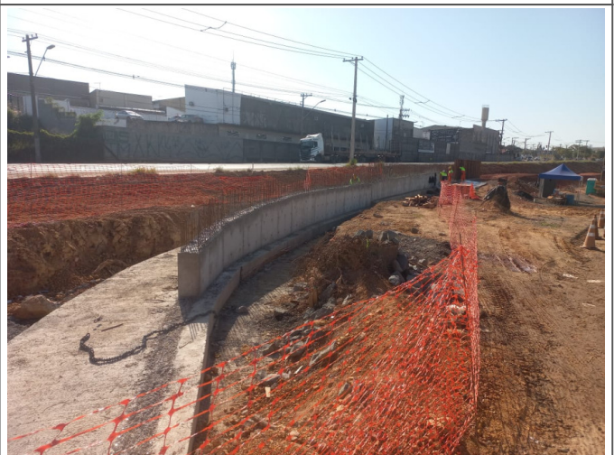
Muro em concreto armado
