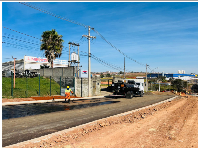
Imprimação para pavimentação
